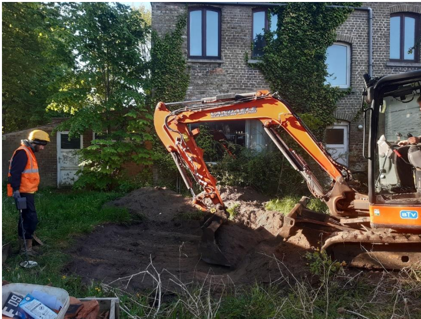
Figuur 18: Aanleg proefput met 5 tons kraan.
