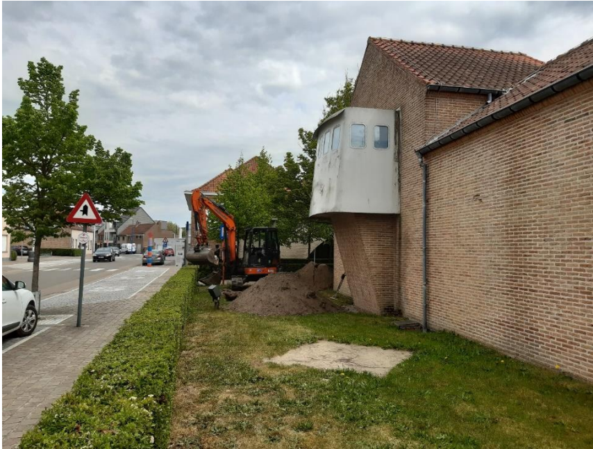
Figuur 19: Aangelegde proefput 6 tussen bestaande bebouwing en de Vrijheidstraat.
