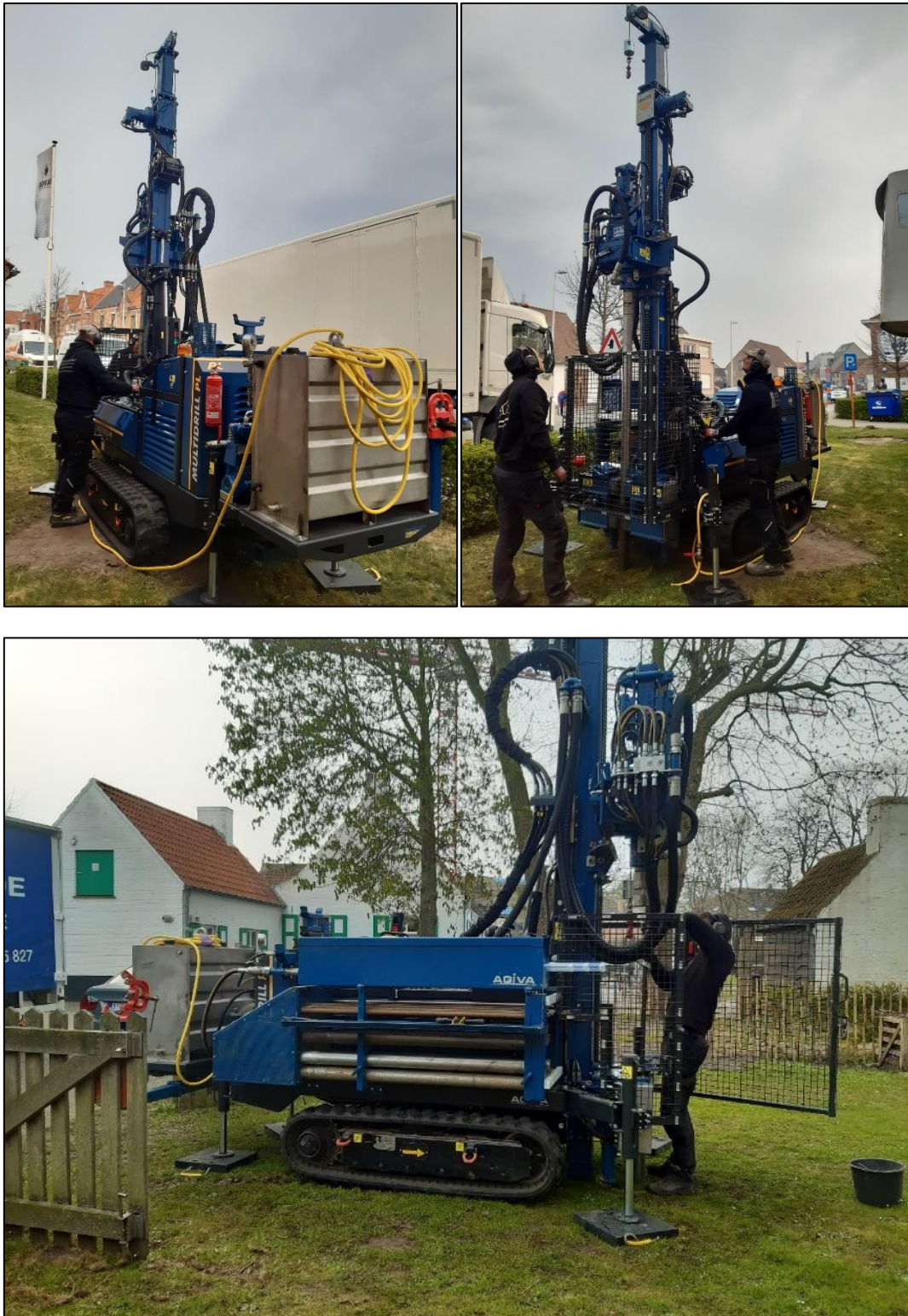
Figuur 12: Zicht op de AGIVA boortoren gebruikt voor het uitvoeren van de boringen
