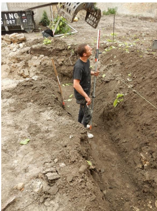
Figuur 11: fotografische opname van de uitgegraven funderingsleuf (WP2 – 19 aug 2021).
