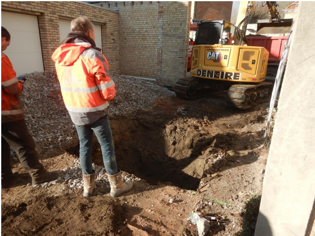
Figuur 67: fotografische opname van de aanleg van werkput 8.
