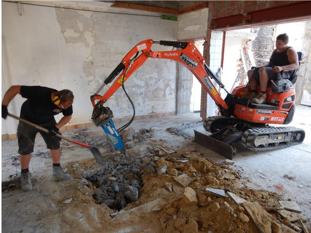
Figuur 48: fotografische opname van de aanleg van werkput 3.
