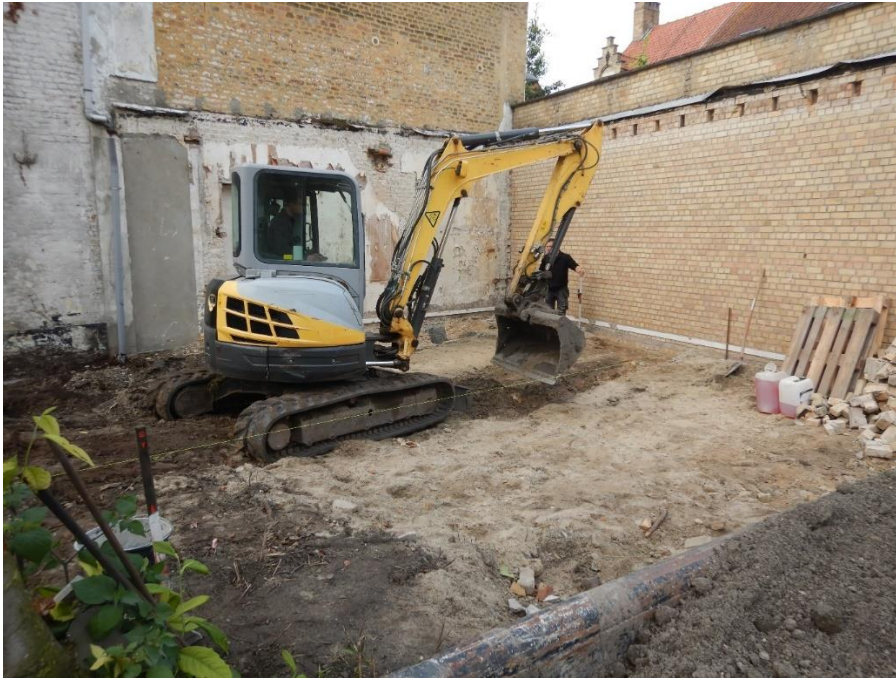
Figuur 10: fotografische opname van werkput 2 en het uitgraven van een sleuf voor de fundering (19 aug 2021).
