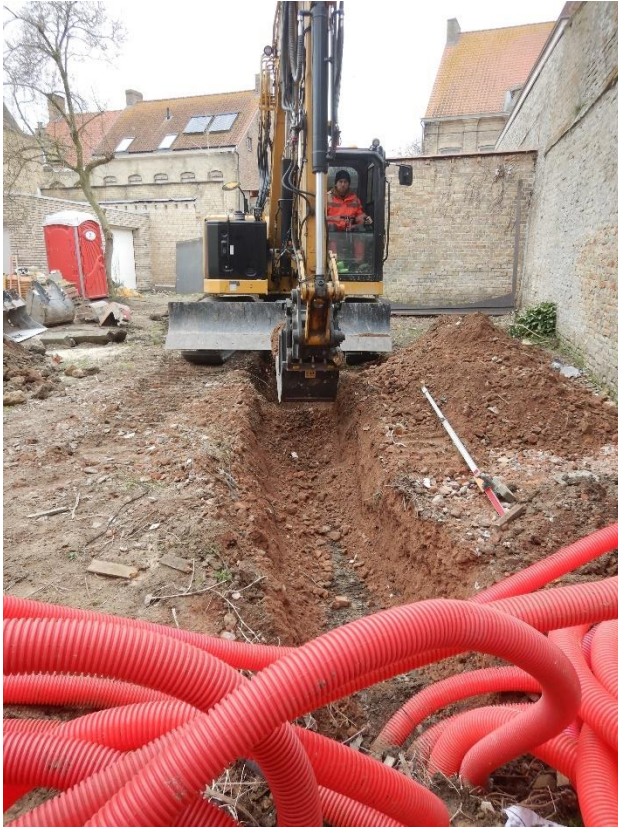
Figuur 14: graven van een sleuf voor de leidingen (WP 6- 24 februari 2023).
