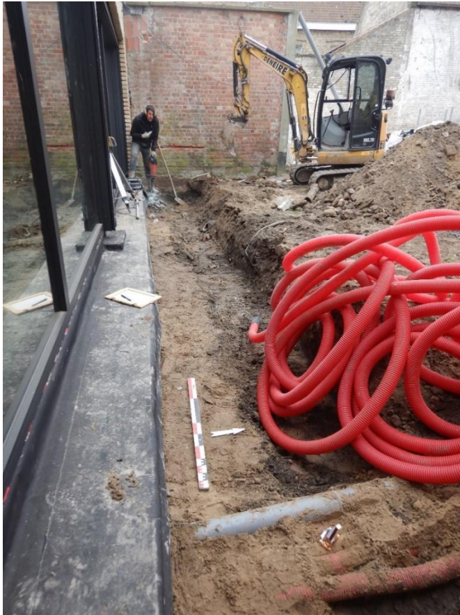
Figuur 58: de sleufuitgraving tegen de achterbouw (WP 6 - 24 februari 2023)
