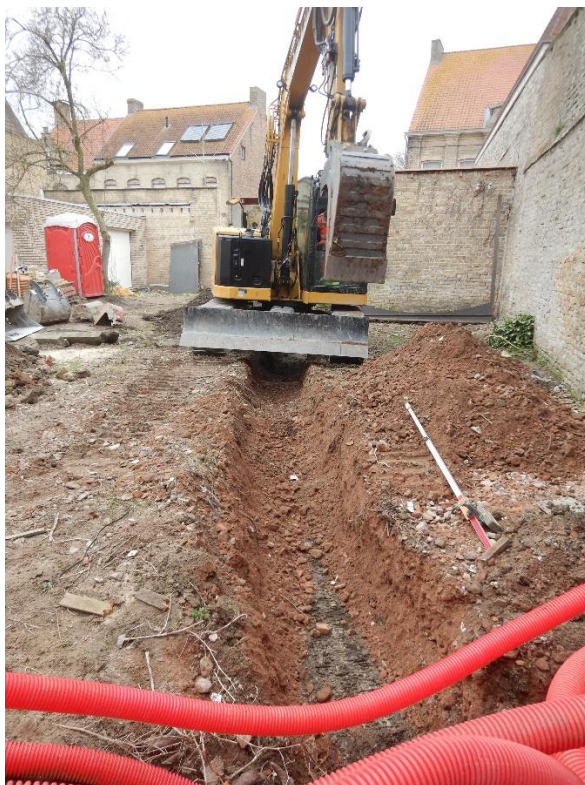
Figuur 59: fotografische opname van de noordwestelijke sleufuitbreiding van werkput 6 naar de hoek van de bestaande garage.
