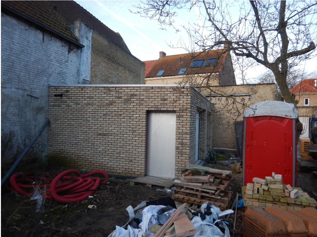
Figuur 46: zicht op de locatie van werkput 2 na opbouw van de nieuwe garages (24 februari 2023).
