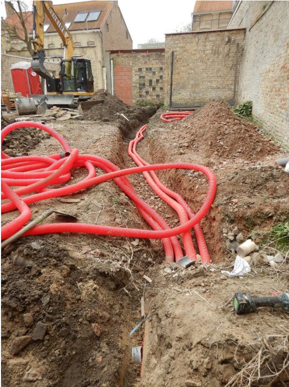
Figuur 60: fotografische opname van het leggen van de leidingen in de noordwestelijke sleufuitbreiding van werkput 6 naar de hoek van de bestaande garage.
