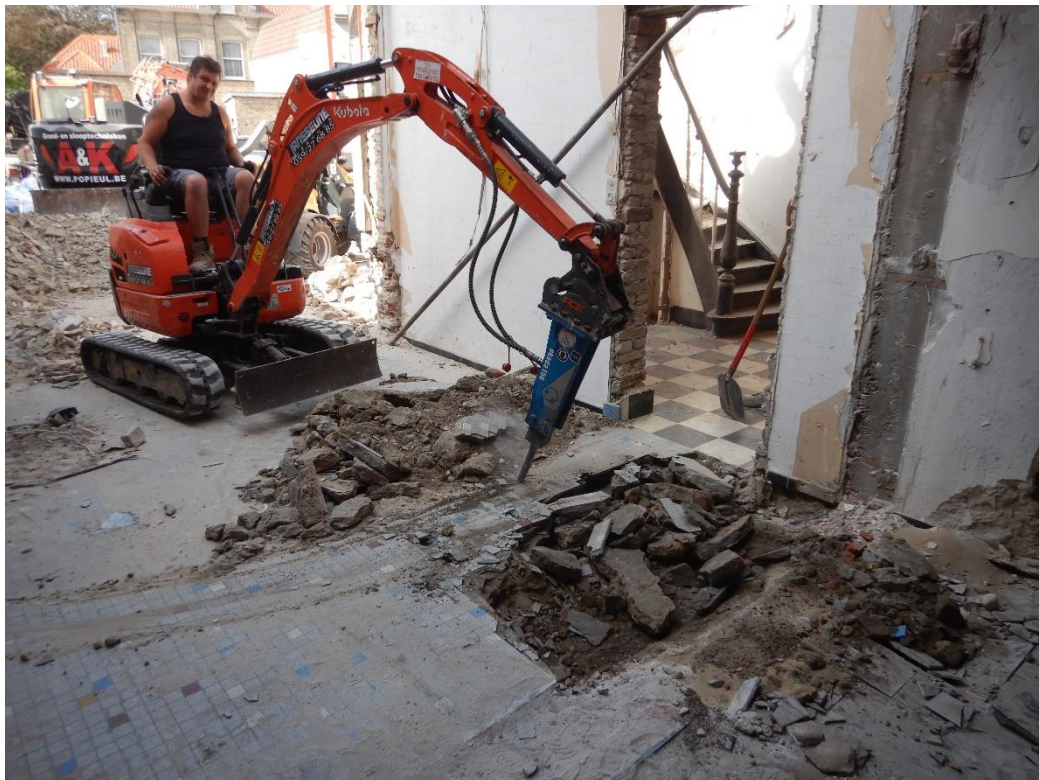
Figuur 55: fotografische opname van de aanleg van werkput 5.
