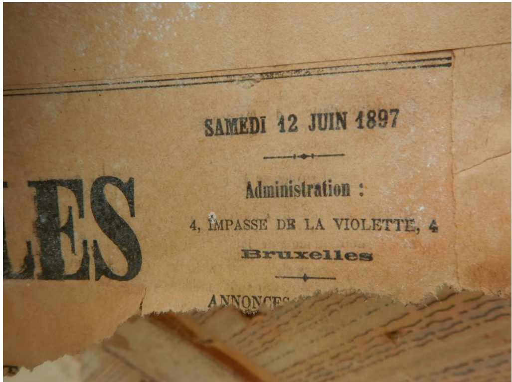
Figuur 44: fotografische detailopname van de beplakking in de kelder (M04)
