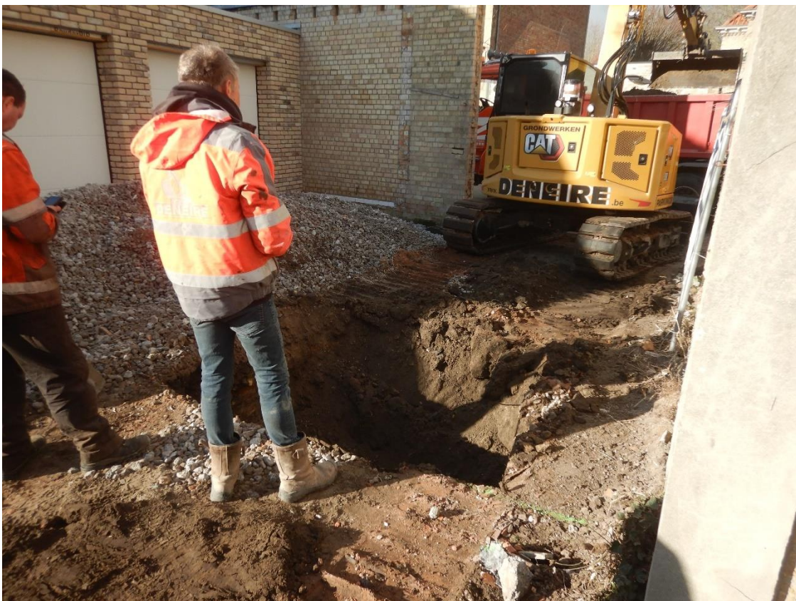
Figuur 15: uitgraving tbv het infiltratiebekken (WP 8 , 3 maart 2023).
