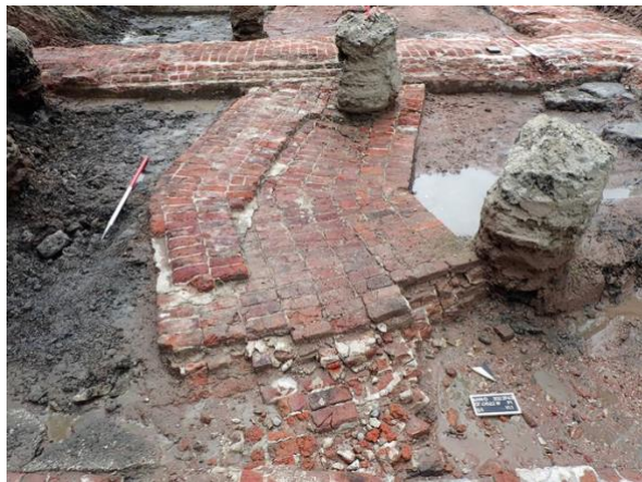
De hoogte van het bewaarde oppervlak schommelde tussen 4,30 en 4,09 m TAW, waarbij het vlak afhelde vanaf de dwarsmuren van MU1 naar het midden. Een 4 cm brede spleet tussen de fundering en de pleisterlaag van MU1 is een gevolg van deze verzakking, hoewel het boren van een betonnen funderingspijler vlak bij deze plaats hierop ook een invloed zal gehad hebben. De andere bouwnaden van de draaiplatformen sluiten nog wel vrij goed aan bij de muren van MU1. De fundering is jonger dan het muurwerk MU1. Van een baksteen met mortelresten werd een monster genomen (v3).
