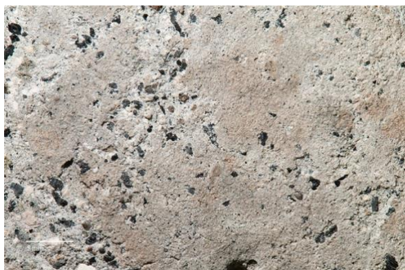
Figuur 45: bovenzvlak van vloer VR6 (v6.1) (©Fodio).
