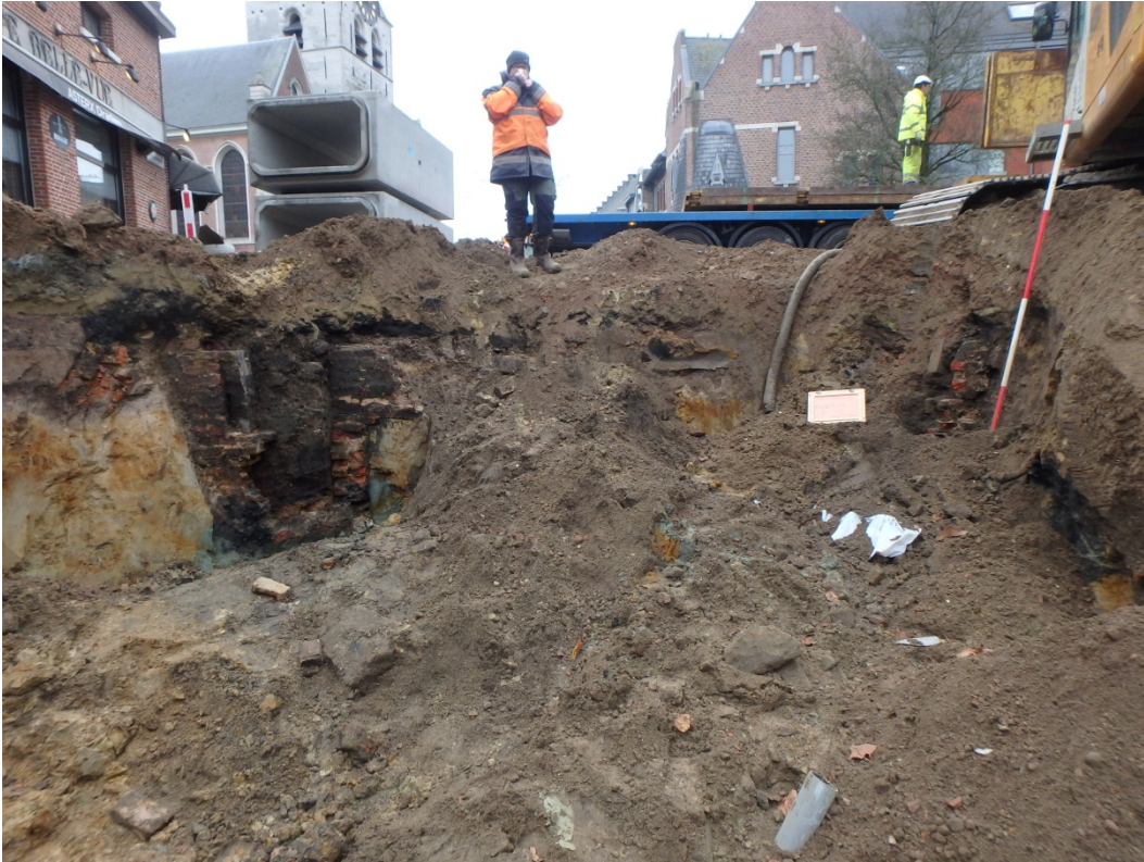
Afb. 4.3. Overzicht van het gemetseld hoekwerk en het metselwerk ten westen ervan.
