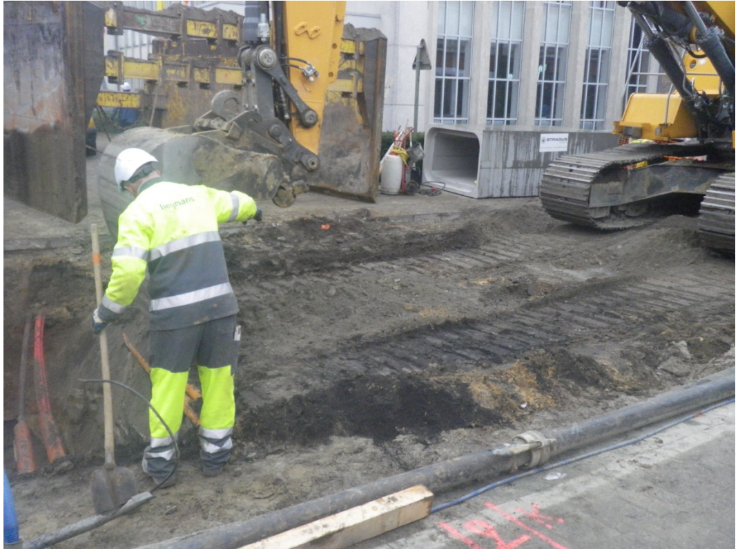
Afb. 1.3. Impressie van de werfbegeleiding in de Eikenstraat, ter hoogte van het gemeentehuis.
