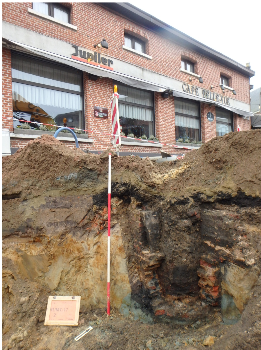
Afb. 4.2. Detail van het metselwerk. De noordpijl is gericht naar de zuidelijk gelegen Maria Magdalenakerk.
