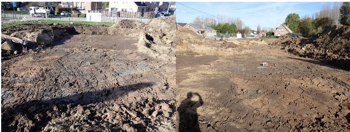
Figuur 71: Vlak 2, werkput 5 (© J. Verrijckt bv)
