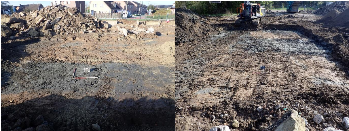
Figuur 70: Vlak 2, werkput 3 (© J. Verrijckt bv)
