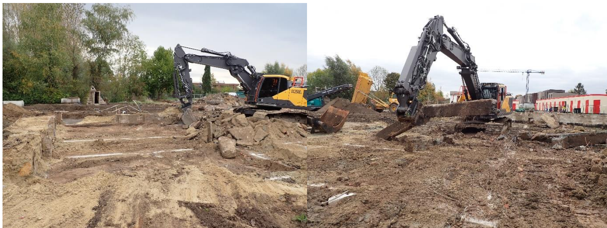
Figuur 66: Vlak 1 ter hoogte van werkput 3 en het uithalen van de fundering in dezelfde werkput (© J. Verrijckt bv)
