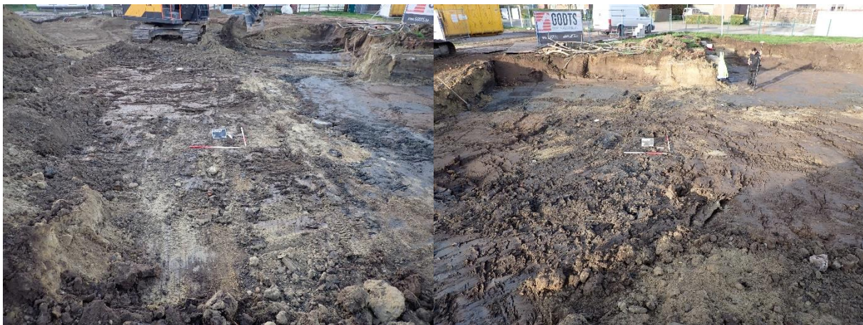
Figuur 72: Vlak 2, werkput 6 (© J. Verrijckt bv)
