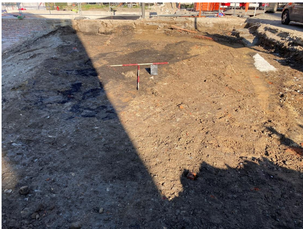
Figuur 6. Overzichtsfoto aangelegde vlak werkput 1.
