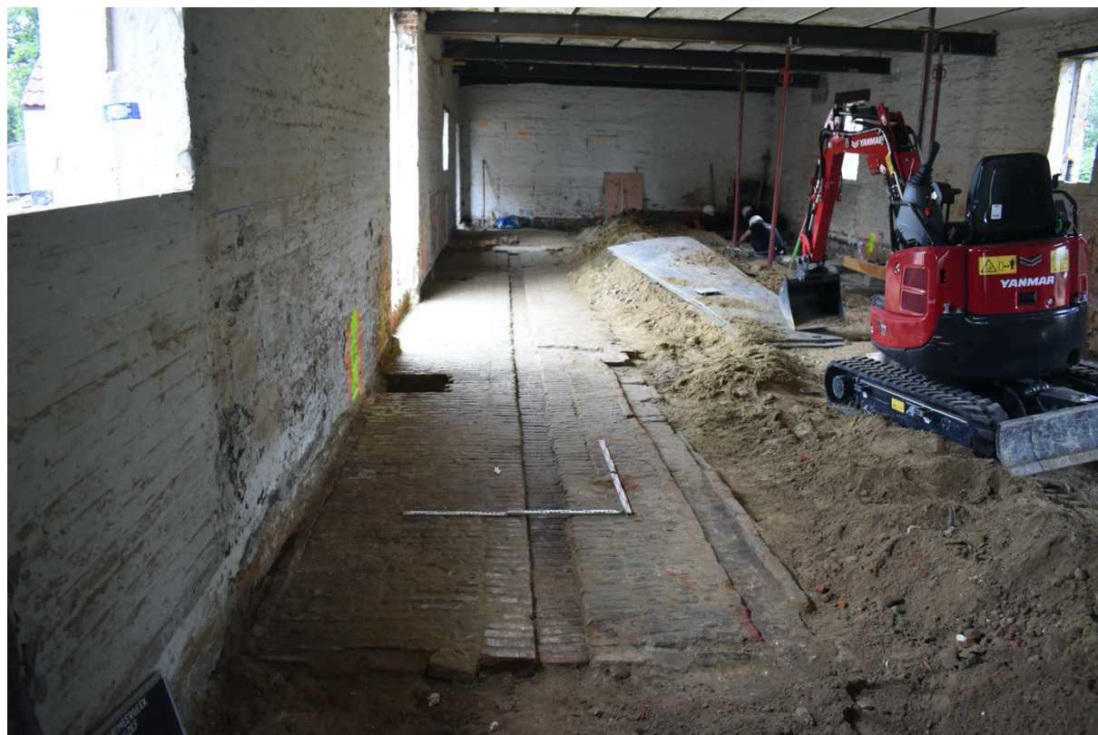
Fig. 1.19: Verdiepen van het stalgedeelte.
