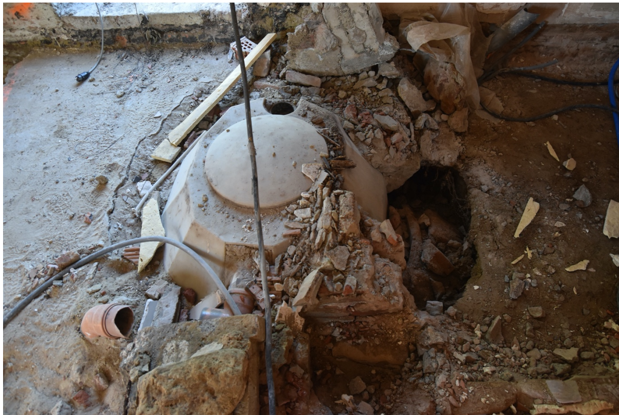
Fig. 3.24: Recente septicse put.
