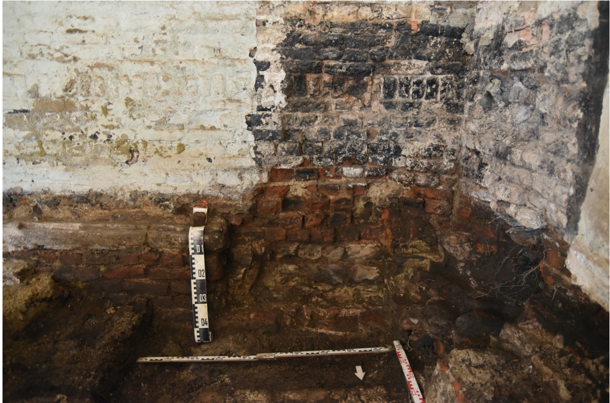
Fig. 3.35: Fundering ter hoogte van werkput 2.
