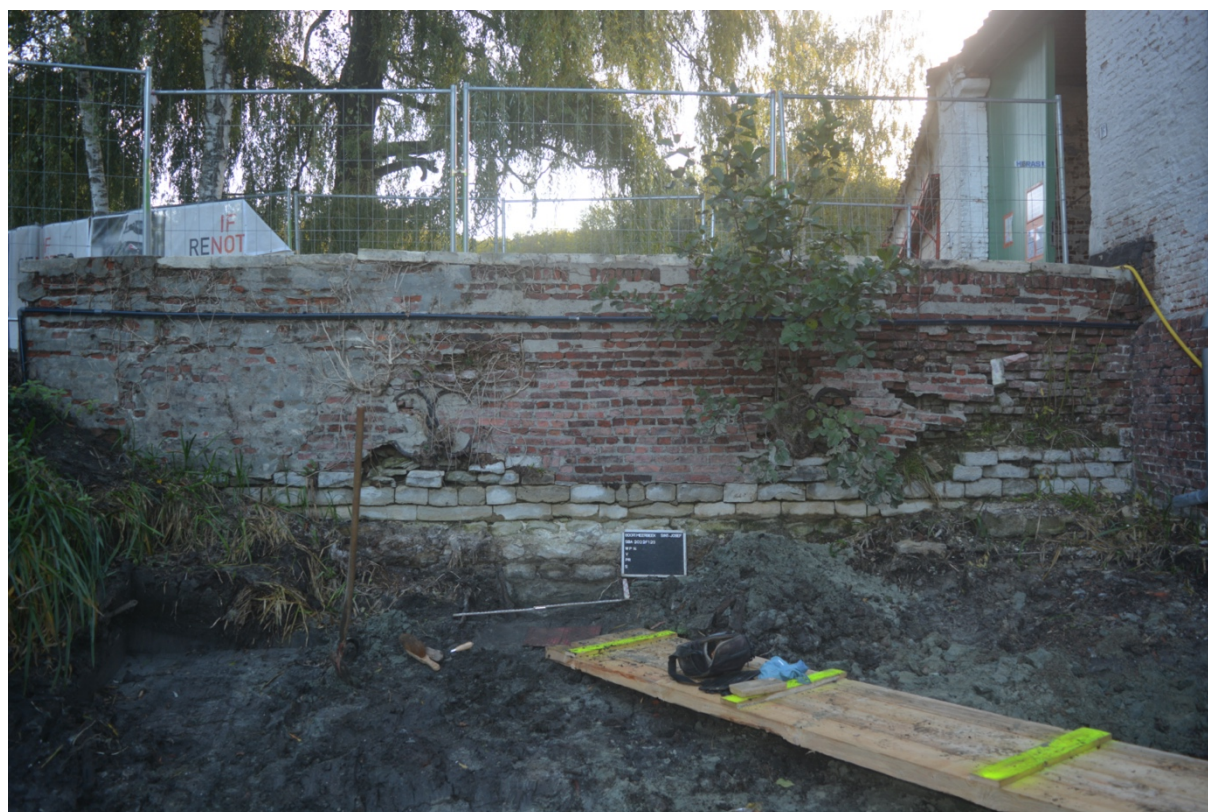
Fig. 3.18: Opbouw van de brug boven het wateroppervlak.
