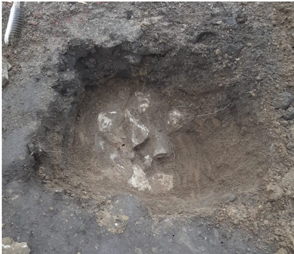
Fig. 3.17: Natuurstenen brokken onder de kasseiverharding (©Foto Renotec).
