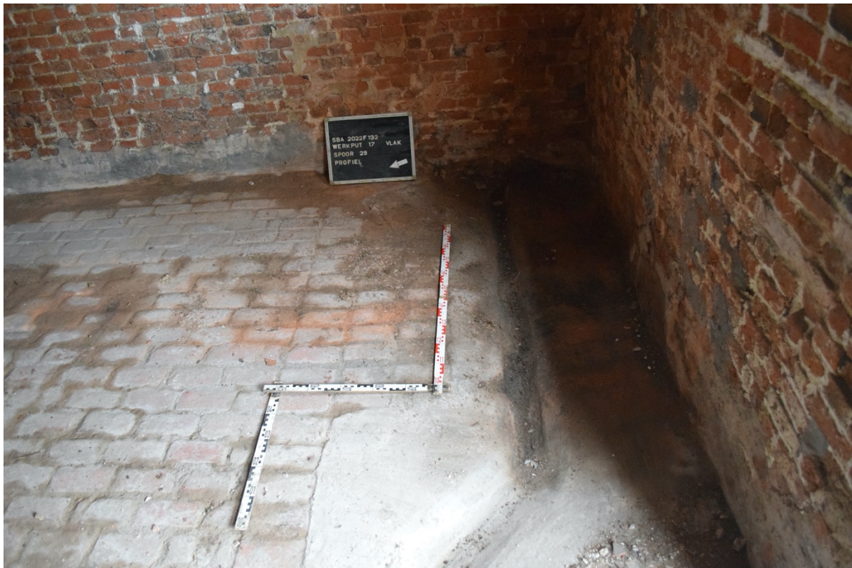
Fig. 3.11: S29 met halfsteens verband (links), dambordverband (midden) en goot (rechts).
