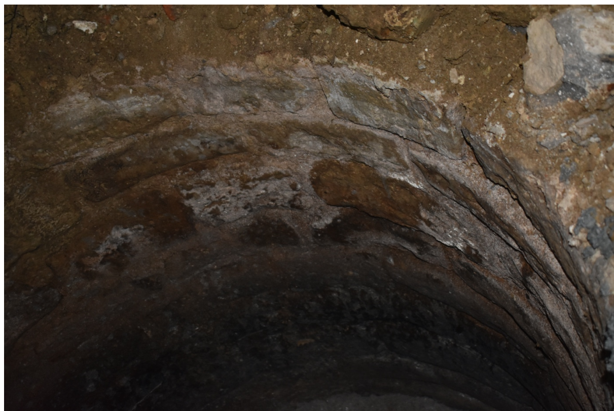
Fig. 3.23: Recente waterput in de keuken.
