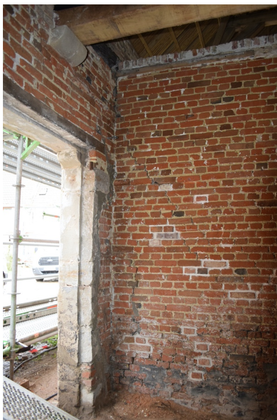
Fig. 3.10: Niet ingebonden binnenmuur.
