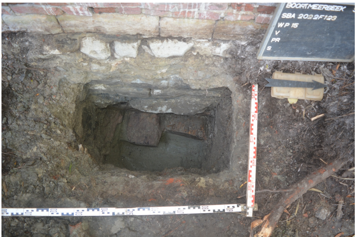
Fig. 3.19: Opbouw van de funderingen onder het wateroppervlak.
