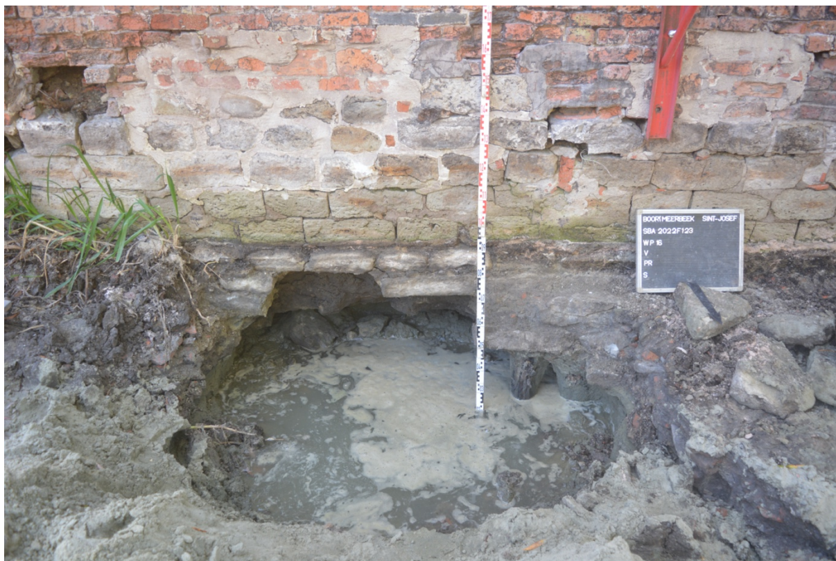
Fig. 3.20: Wateroverlast in werkput 16.
