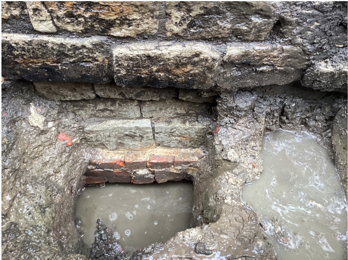
Fig. 3.46: Fundering schuur (©Foto Renotec).
