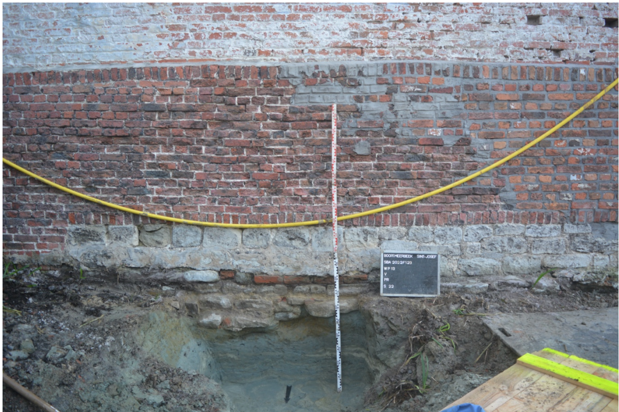
Fig. 3.27: Funderingsopbouw ter hoogte van werkput 13.
