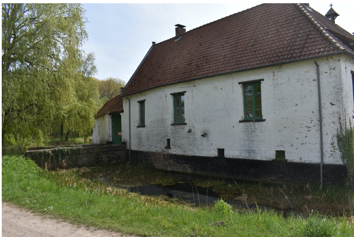
Fig. 1.4: Noordgevel woongedeelte (terreinbezoek 19/04/2022).
