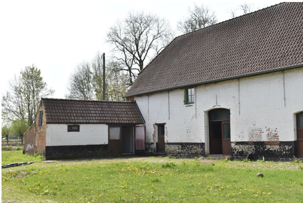
Fig. 1.7: Oostgevel stallingen en kleine varkensstal (terreinbezoek 19/04/2022).
