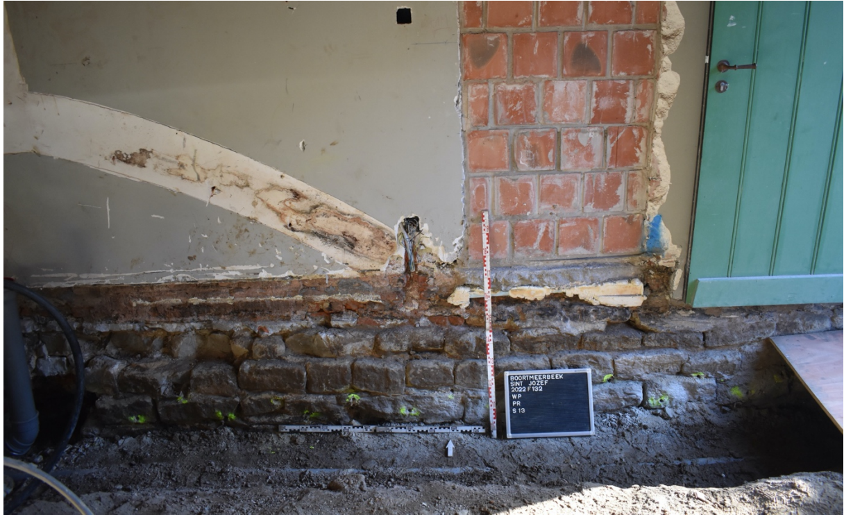
Fig. 3.26: Natuurstenen fundering (S13) onder de scheidingsmuur hal-woning.
