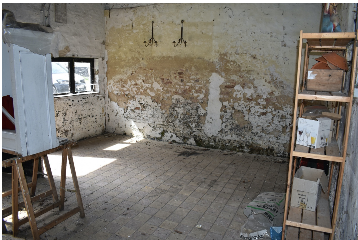
Fig. 1.6: Centrale ruimte poortgebouw (terreinbezoek 19/04/2022).
