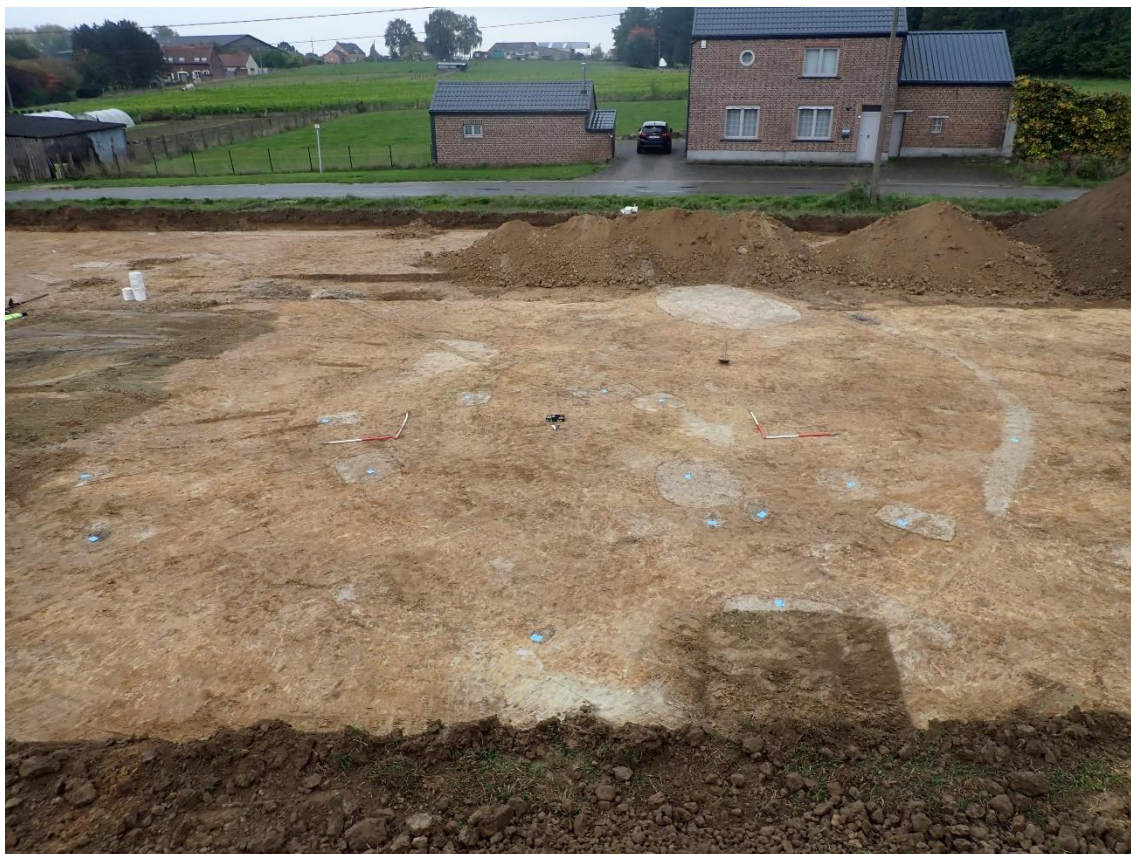
Figuur 13: Overzichtsfoto WP1 in zuidelijke richting (© J. Verrijckt bv).
