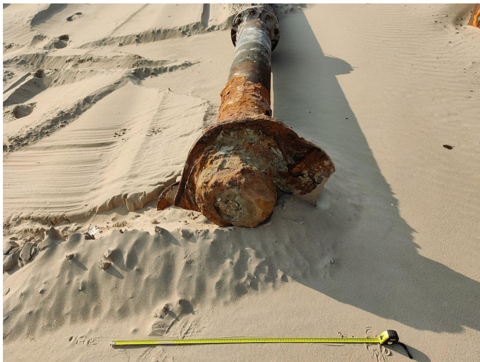
Figuur 14: De ijzeren palen werden met een soort schroef ingeheid en -gedraaid. Deze palen dienden zowel als fundering voor de latere betonnen pier als, waar nog mogelijk, de huidige nieuwe Pier.
