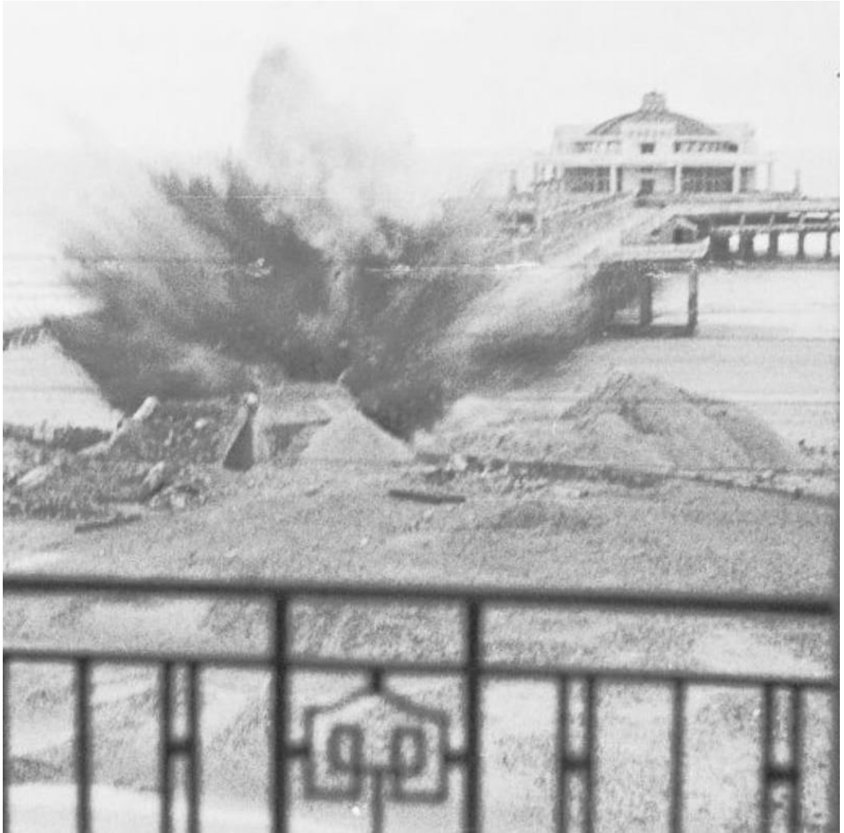
Figuur 70: Actiefoto van het opblazen van de bunker (© Pierre Nowak).
