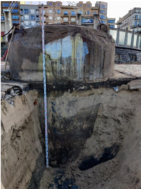
Figuur 27: Dieptepeiling van de Belgische bunker tot 3,5m TAW.
