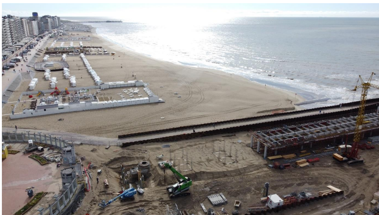
Figuur 43: Overzichtsfoto van de Belgische bunker.
