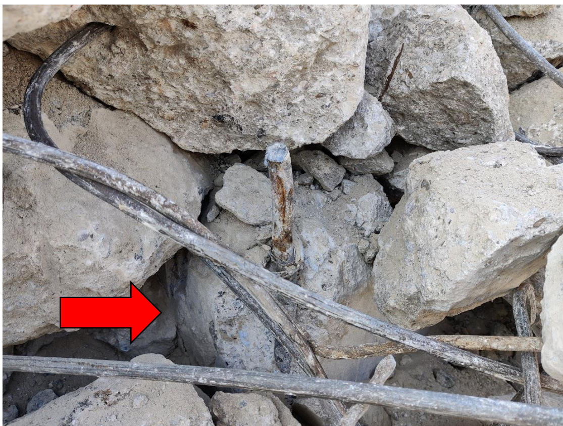
Figuur 20: Restant van een originele paal onder het afbraakpuin van de Duitse (gewapende) vloerplaat.
