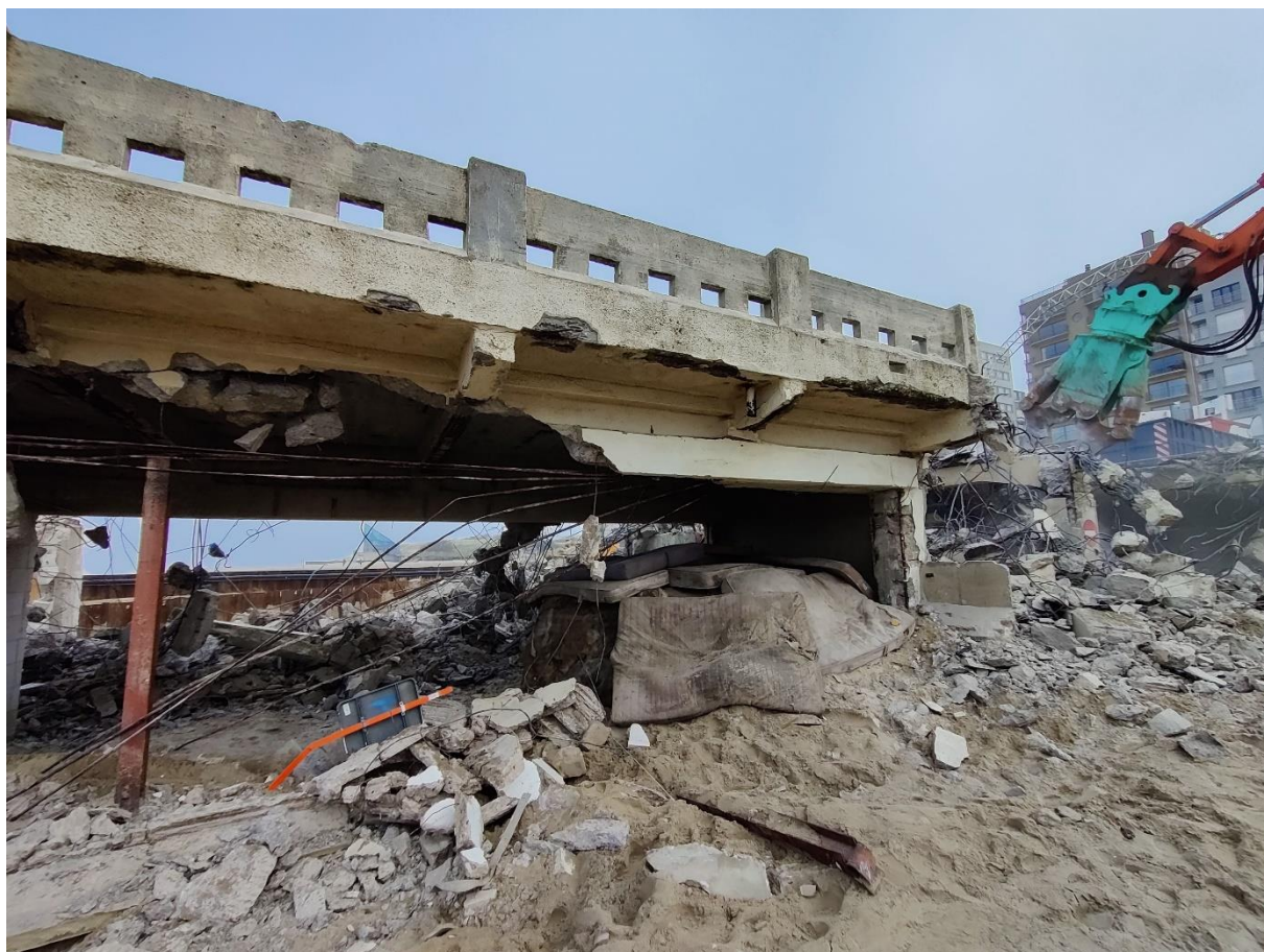
Figuur 6: Bescherming van de opstaande bunkerstructuur met matrassen tijdens de afbraak van de pier, 10 januari 2022.
