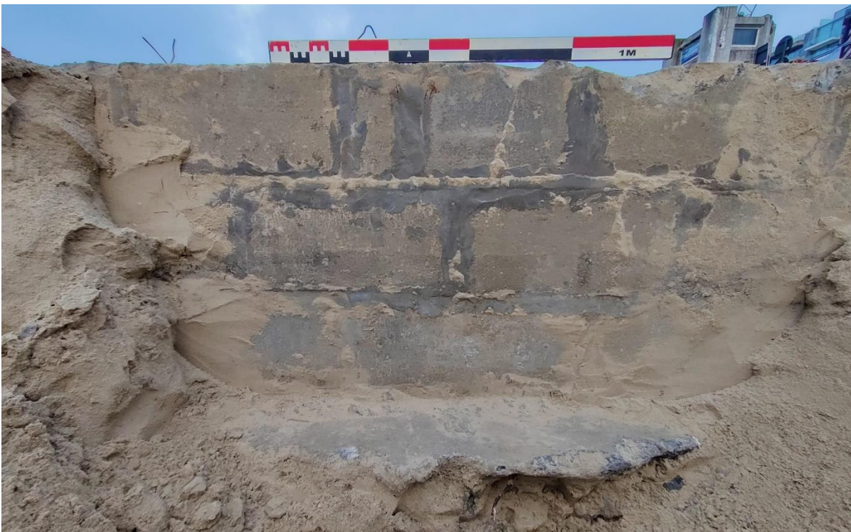
Figuur 61: Detail van de westelijke rand van de omkraging in betonsteen, waarschijnlijk gebruikt als (gewapende) bekisting.
