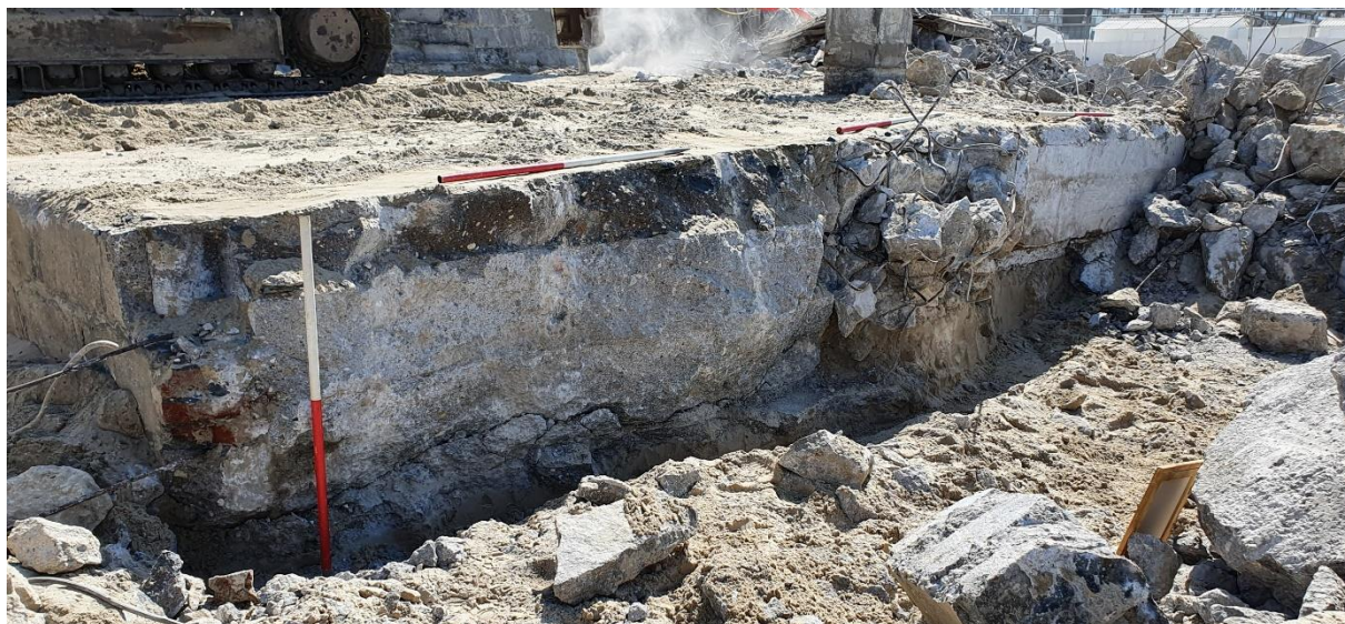
Figuur 58: Foto van coupe C met gewapende bekisting uit snelbouwstenen, de ongewapende omkraging in verschillende lagen gegoten, het restant van de uitstekende XXX en de frontmuur van de bunker achter de omkraging.
