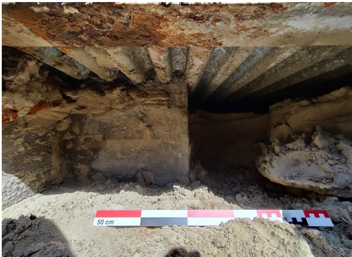
Figuur 42: Zicht op de staat en opbouw van het interieur, foto genomen door de toegang richting koepel.
