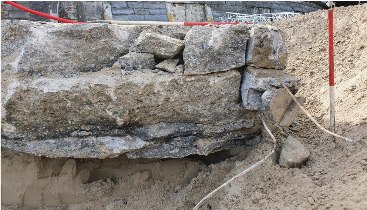
Figuur 60: Detail van de westelijke kraagrand met bekistingsstenen en pakketten ongewapend beton met verschillende samenstelling.
