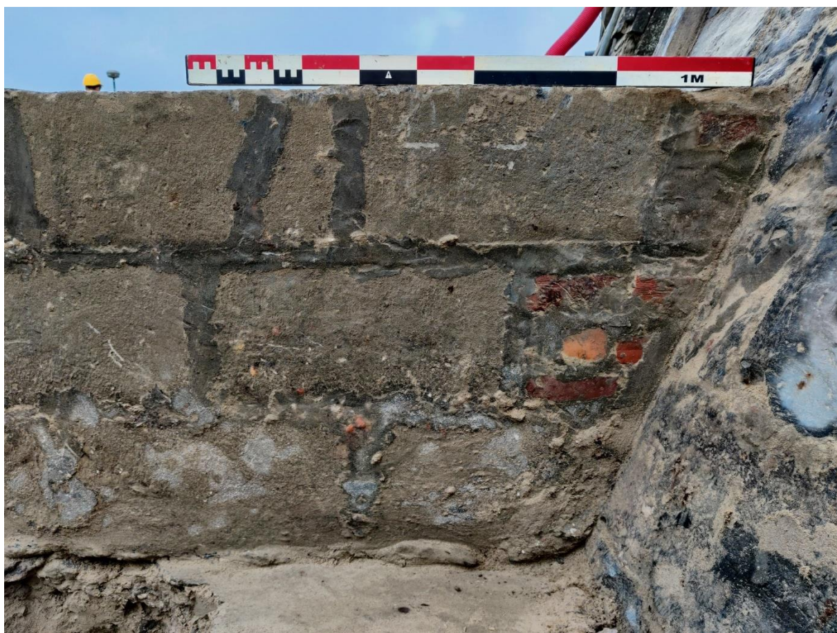
Figuur 62: Detail westelijke aanhechting rand van de Duitse bunkeromkraging met het dijkhoofd.
