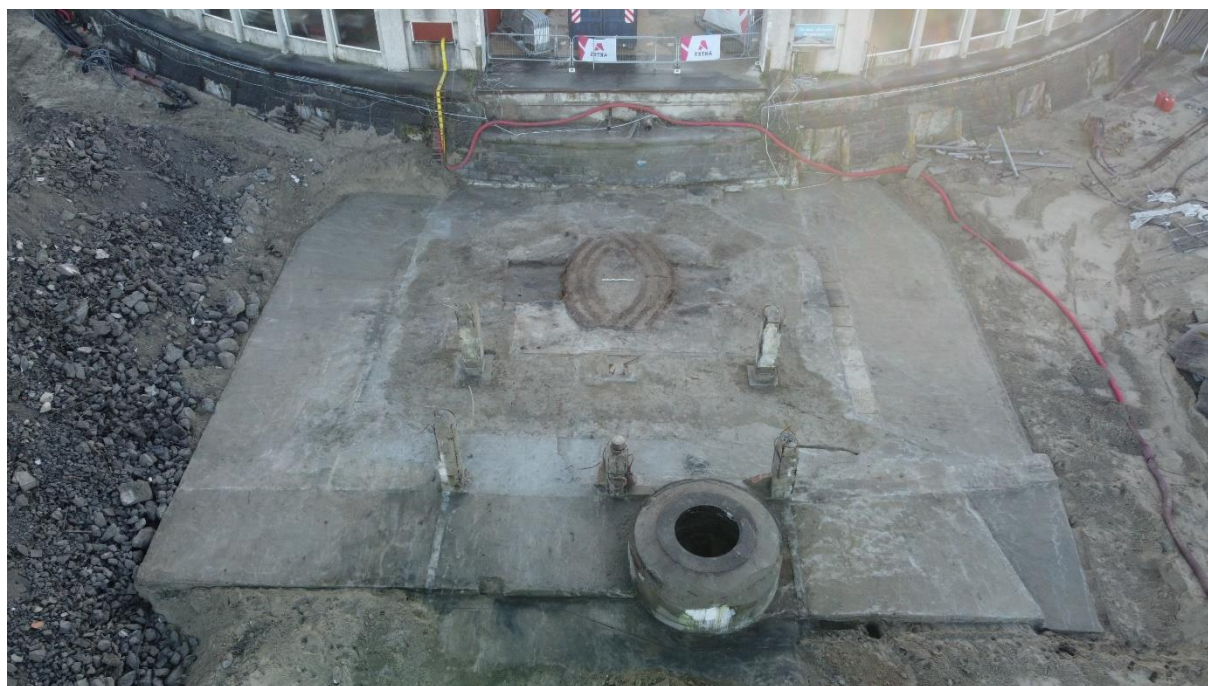
Figuur 11: Overzichtsfoto van de vrijgelegde structuren met dijkhoofd op de achtergrond (© Raph De Brant).
