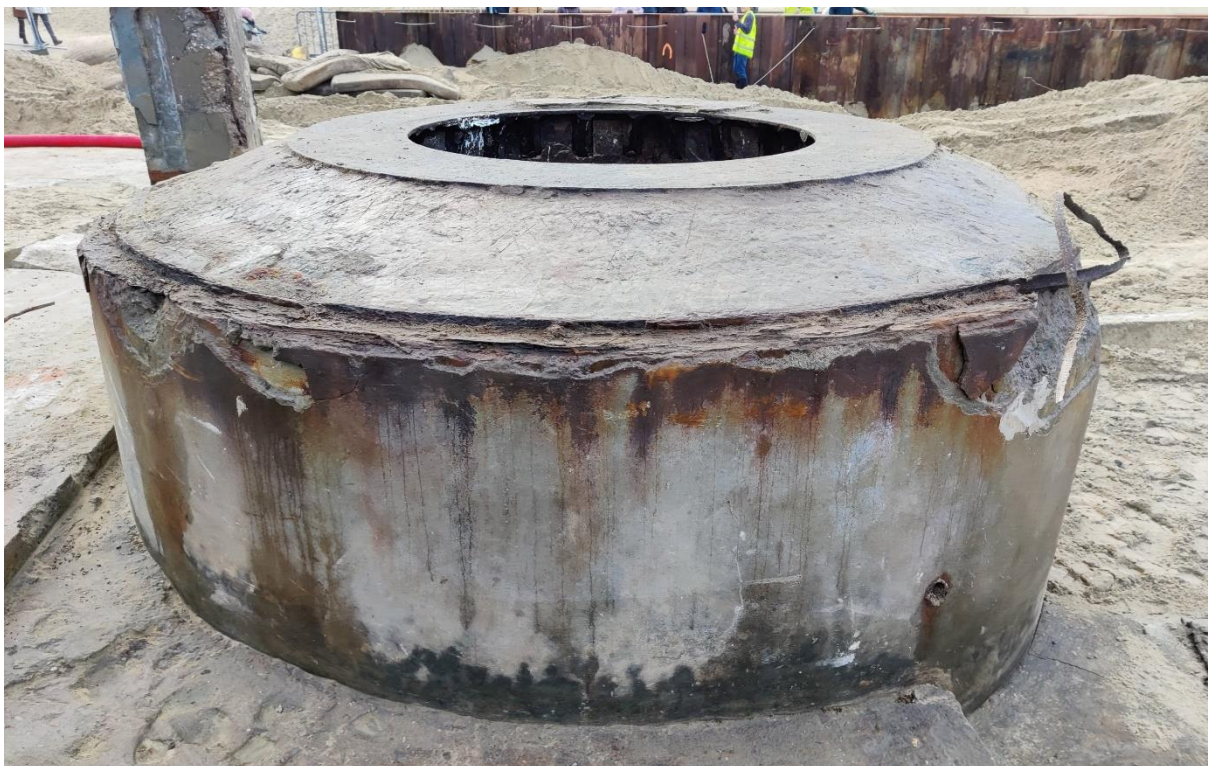
Figuur 28: Foto van de koepel vanuit het noordoosten met een duidelijk beeld van de opbouw.
