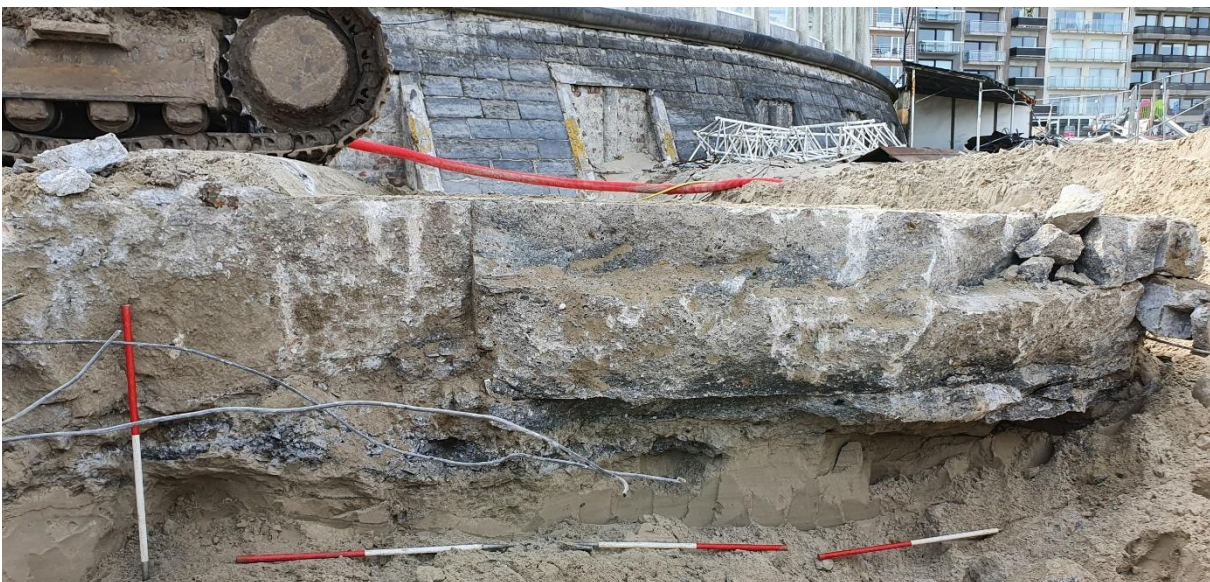
Figuur 57: Foto van coupe B met de ingewerkte blokken de afhellende omkraging in verschillende lagen gegoten en de gewapende bekisting in snelbouwstenen.
