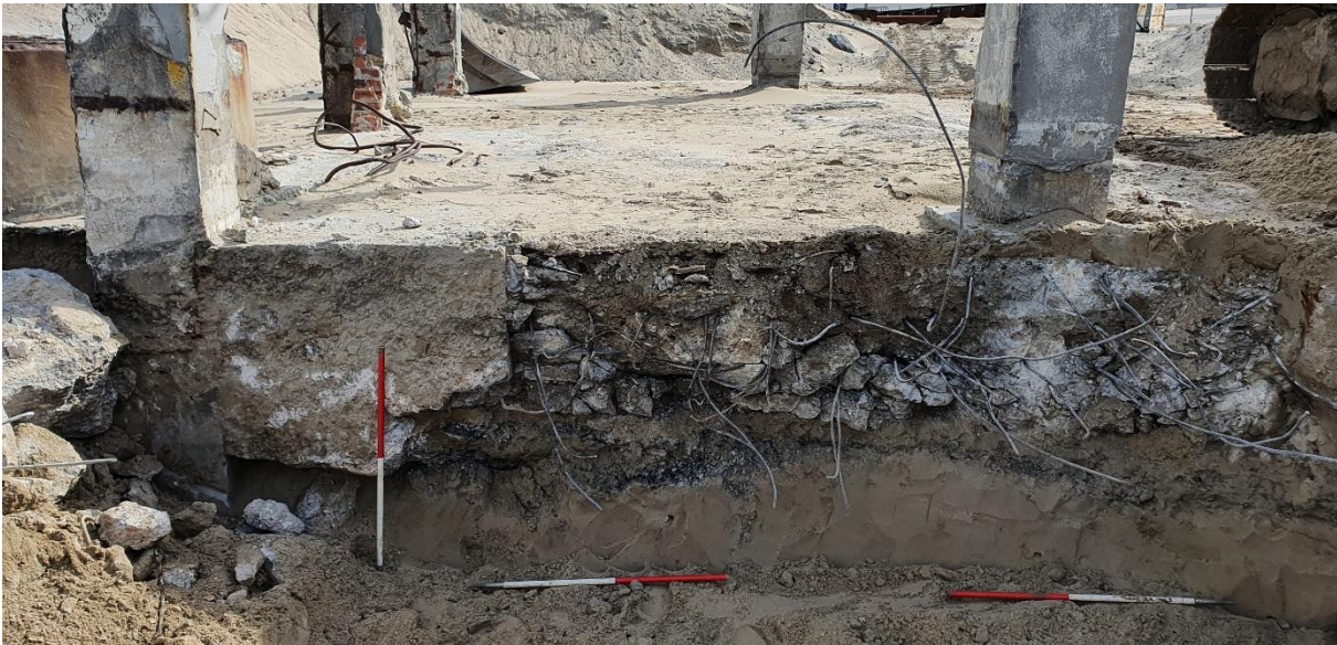
Figuur 56: Foto van coupe A met de Belgische bunker, de pier van '33 (doorlopend onder de omkraging) de gestorte omkraging, gewapende frontmuur en de latere herstelde paal van de herbouwde pier na afbraak van de bunker (gefundeerd op de bunker).
