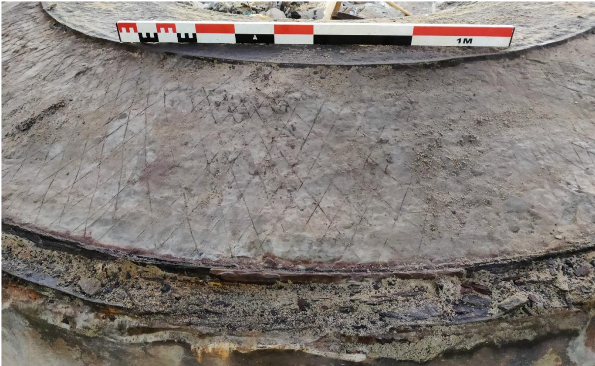
Figuur 30: Detail van de koepel met ruitvormig patroon in het beton.
