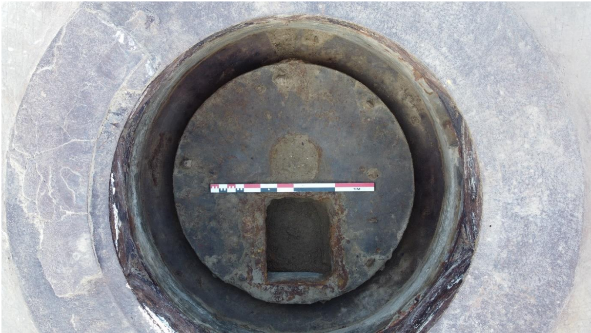
Figuur 26: Opname van de bodem van de koepel met een betonnen vloer met goot en mangat.
