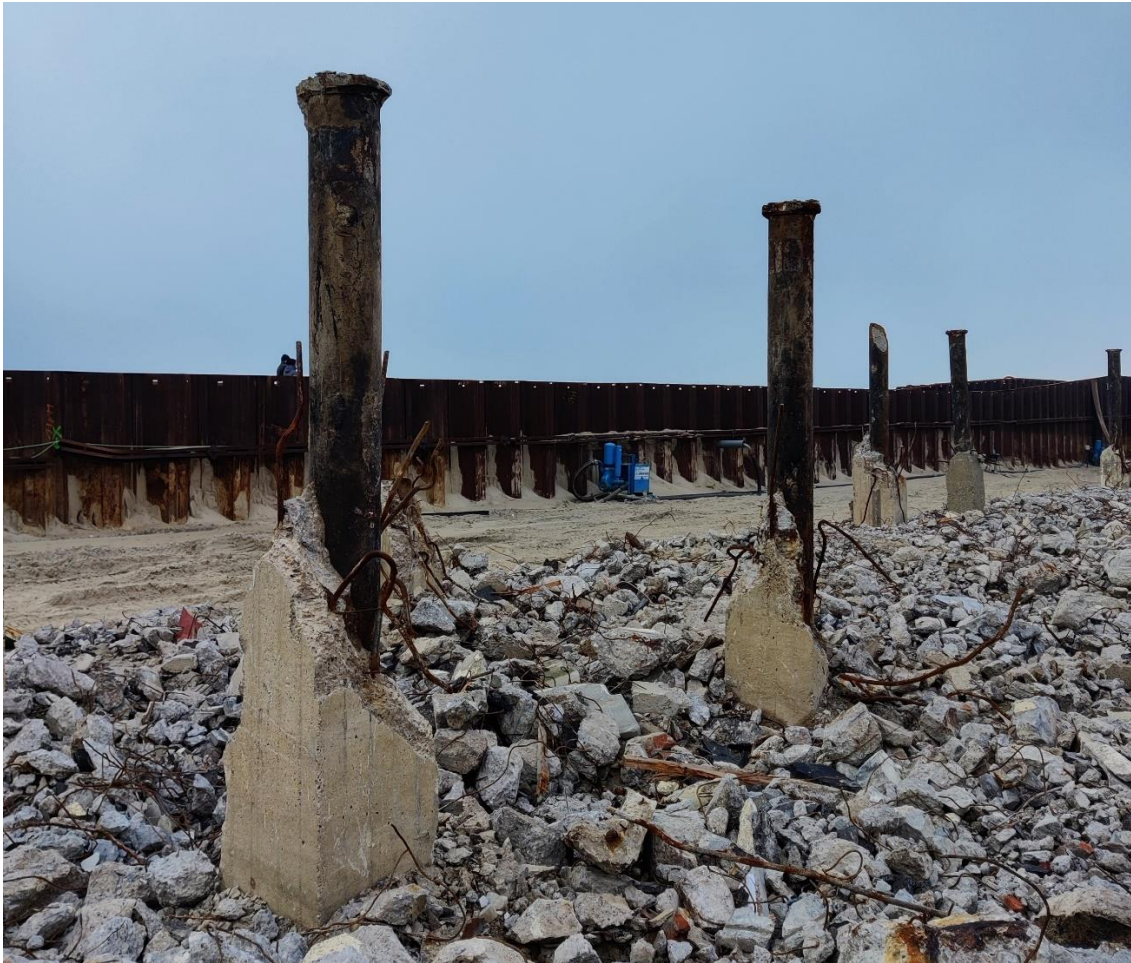
Figuur 16: Iets ten noorden van het onderzoeksgebied waren de gietijzeren kolommen nog intact en zeer duidelijk herkenbaar.
