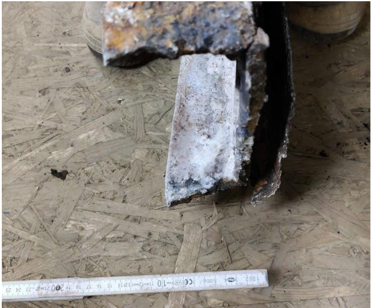
Figuur 54: Profiel van (de helft van) een van de stalen balken, gerecupereerd voor registratie na de afbraak.
