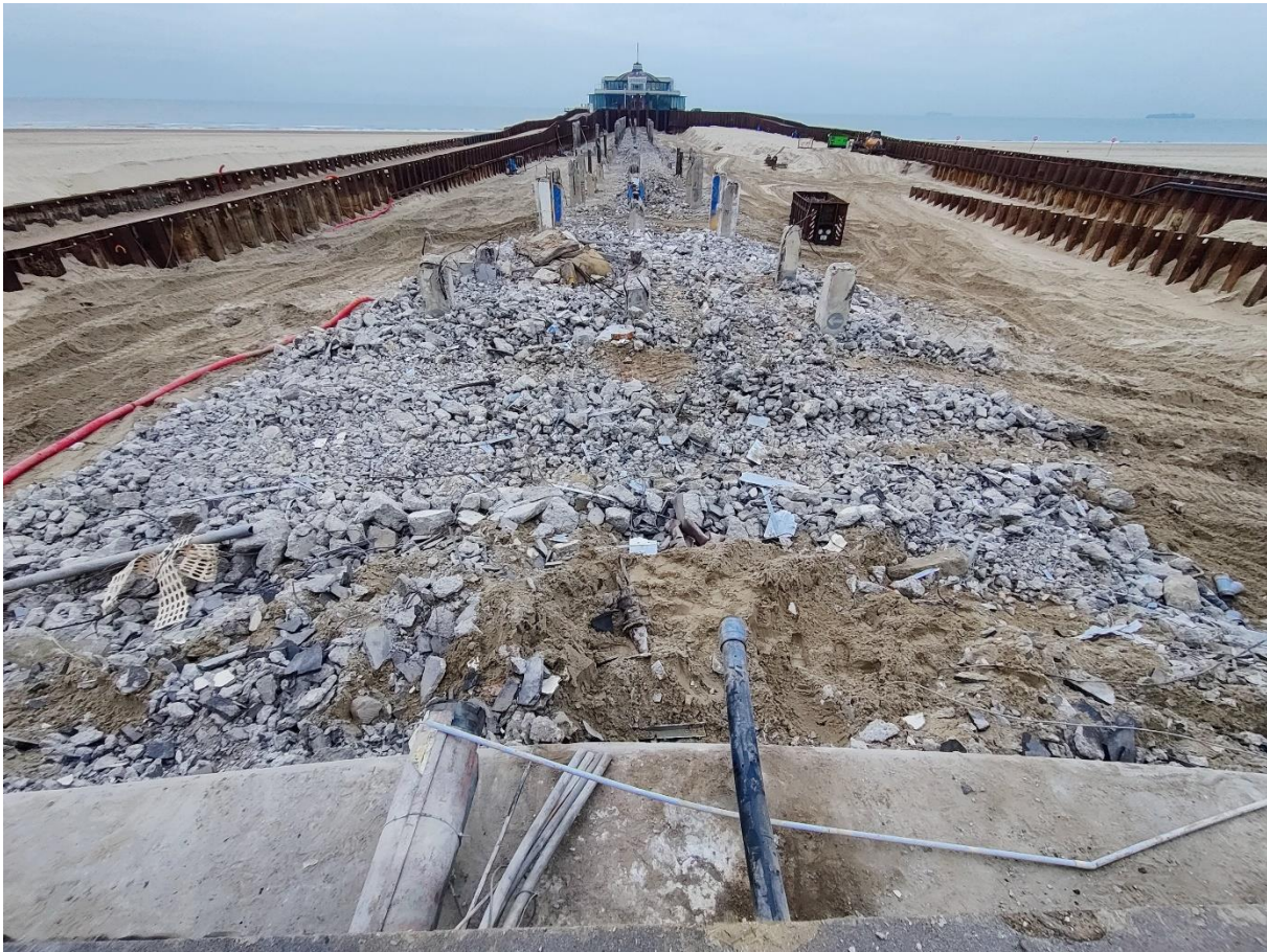
Figuur 7: Situatie van het projectgebied na afbraak van de pier op het einde van de werkdag, 11 januari 2022.
