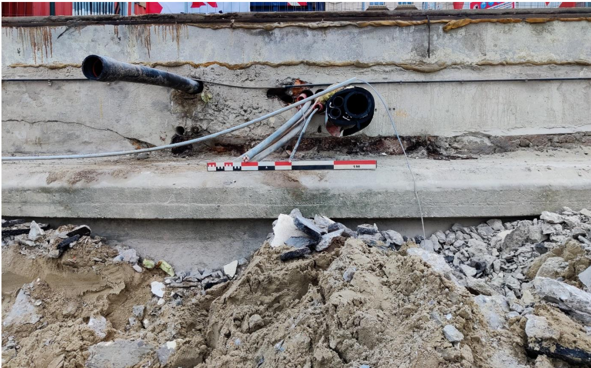
Figuur 64: Metalen element in het dijkhoofd, mogelijk een indicatie van de Duitse toegang tot de bunker.
