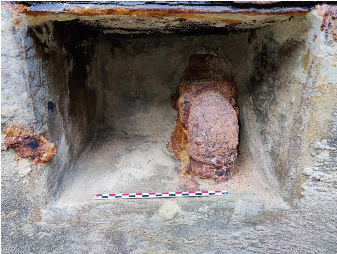
Figuur 33: Detail van uitsparing met buizen in het noordwand van de bunker.
