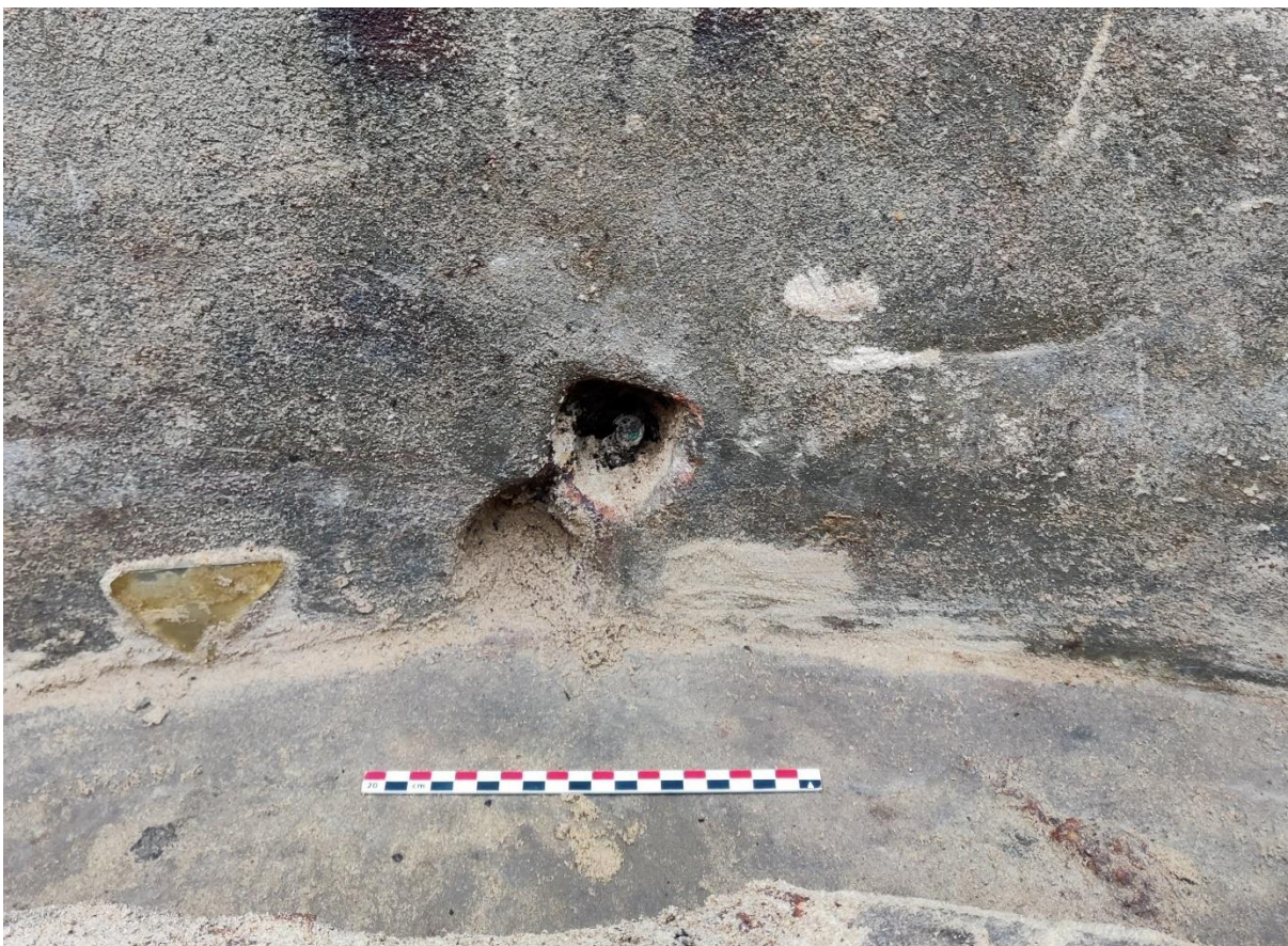
Figuur 34: Detailfoto van binnenkomende bekabeling (en waterafvoer?) in de zuidwand van de bunker ter hoogte van het gootje.
