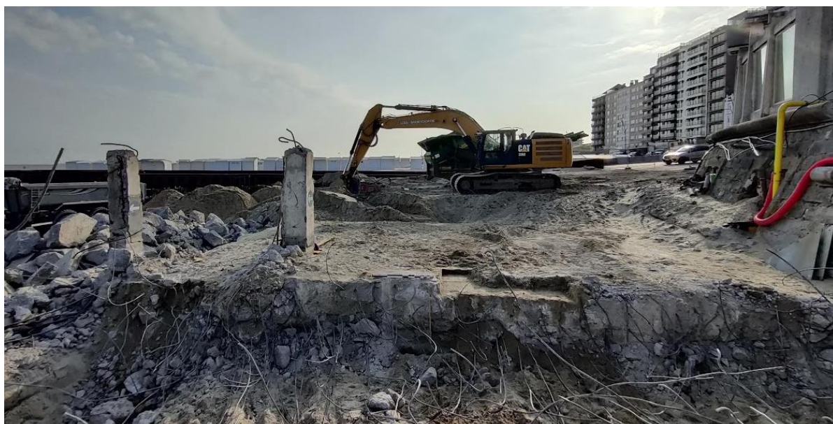
Figuur 59: Foto van coupe D met de frontmuur en de vloer van de bunker ter hoogte van de oostelijk artillerieopstelling.
