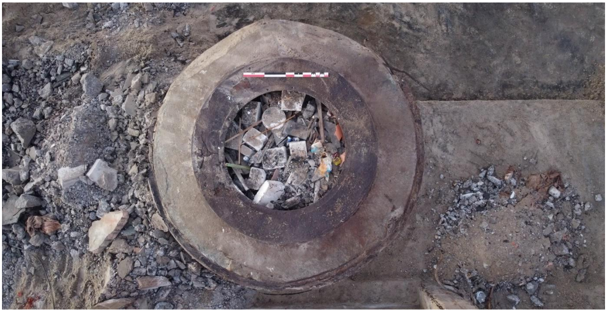
Figuur 24: Belgische bunkerkoepel na de sloop van de pier. Het puin in de bunker was al aanwezig voor de sloop (©Raph De Brant).
