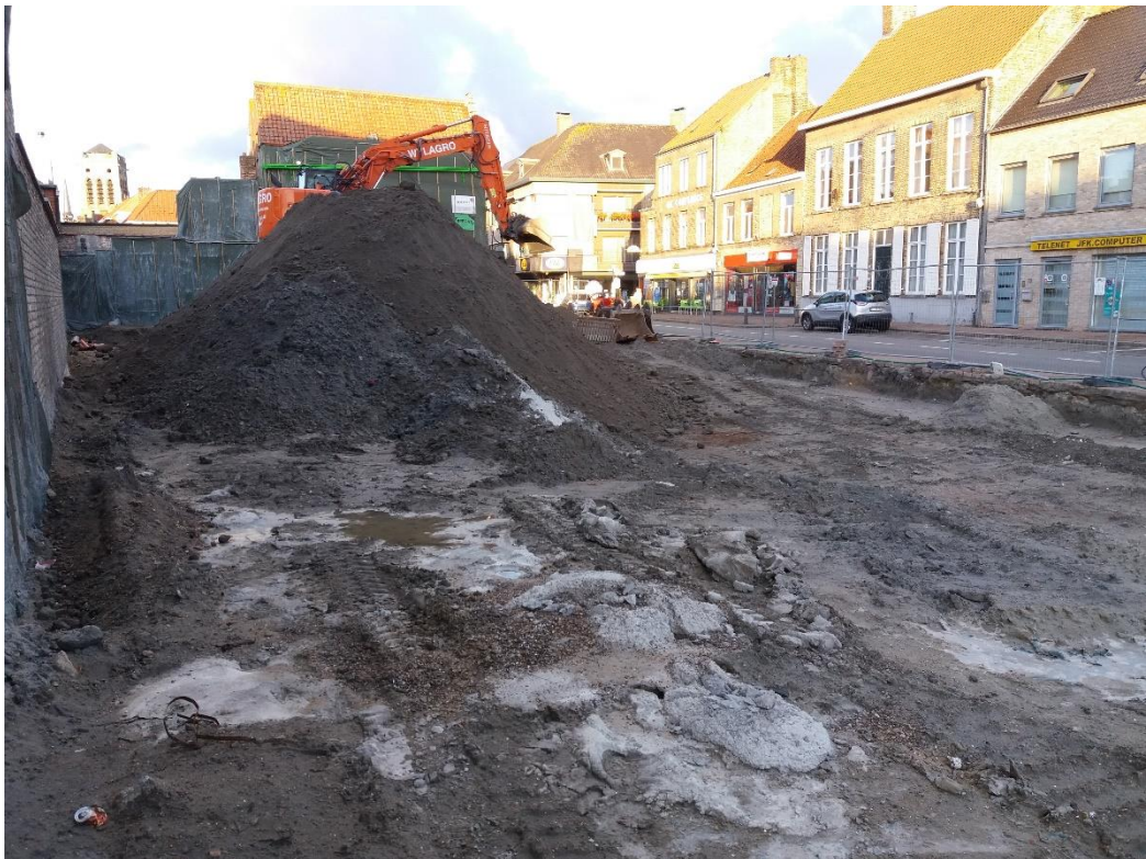
Figuur 76: fotografische opname van het begin van de afgraving op 30 september 2019.
