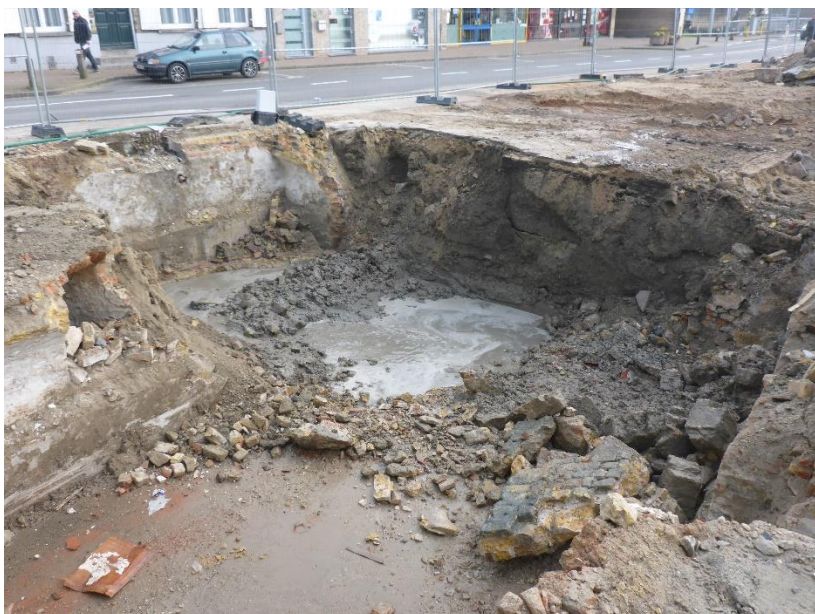
Figuur 129: uitbraak van de kelders in het noordwestelijk deel van het projectgebied tijdens het vooronderzoek (Wuyts et al. 2019).
