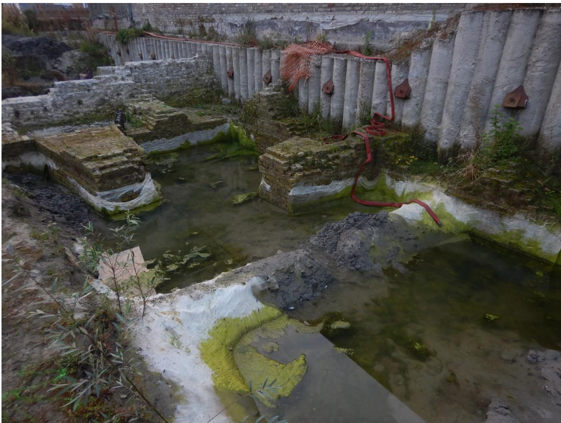
Figuur 21: toestand van de bouwput op 20 september 2021
