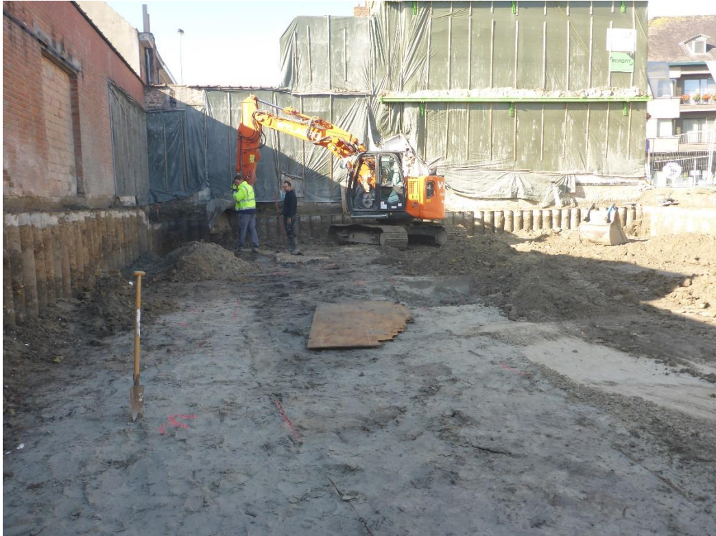
Figuur 81: het afgraven van vlak 2 in de zuidwesthoek van het terrein op 10 oktober 2019
