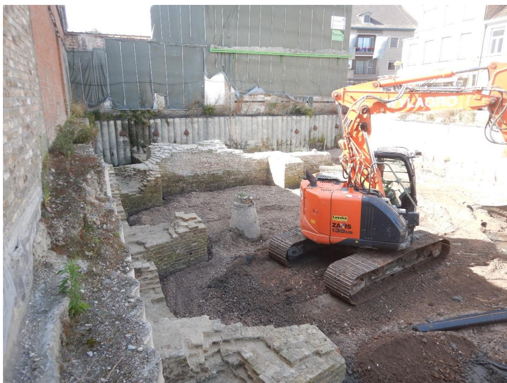
Figuur 93: aanbrengen van doek en puin tussen de muurstructuren op 21 september 2021
