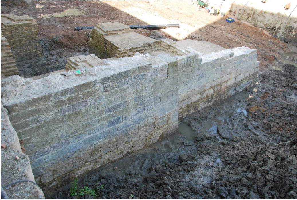
Figuur 47: natuursteen aangewend in de opbouw van de Vauban stadsomwalling
