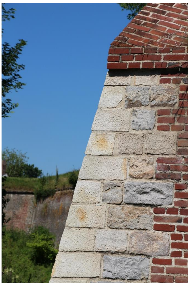
Figuur 140: hoekafwerking met natuursteen aan de cortine te Lille (@Davy Herremans).
