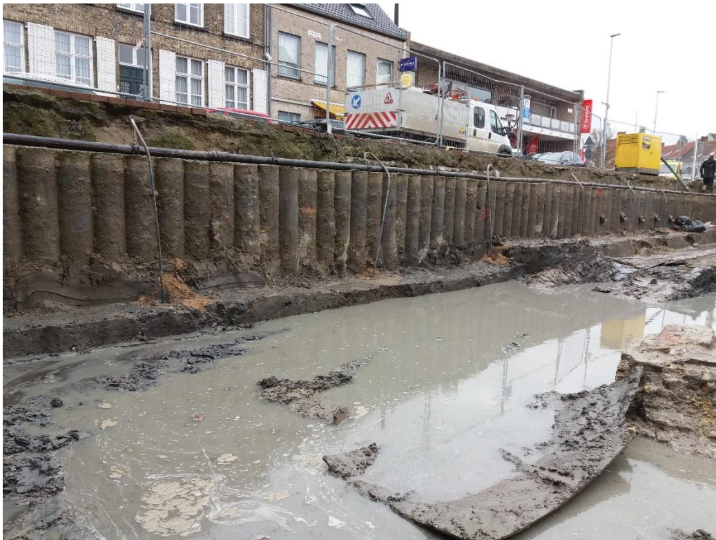
Figuur 84: het plaatsen van de bemaling op 27 november 2019
