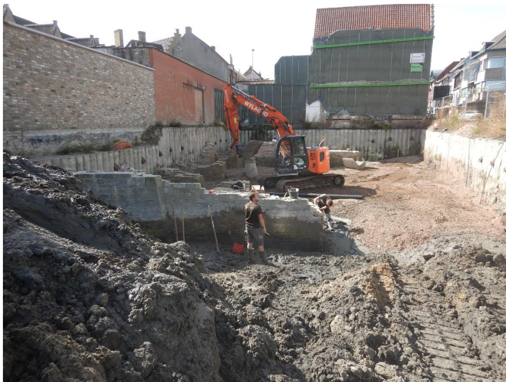
Figuur 92: opkuis van de muurstructuren op 20 september 2021
