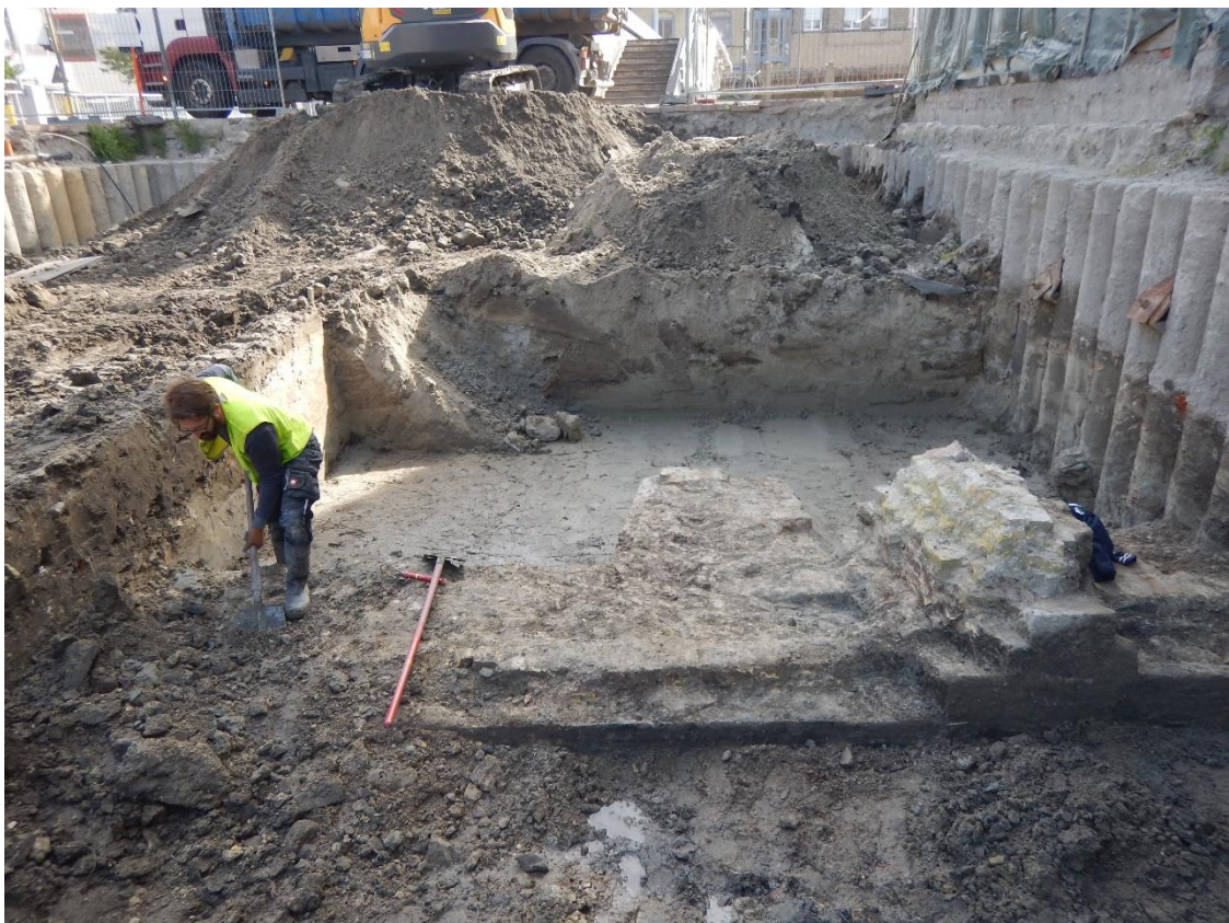
Figuur 20: opkuisen van muurwerk en het zetten van een profiel in werfput E op 5 mei 2020
