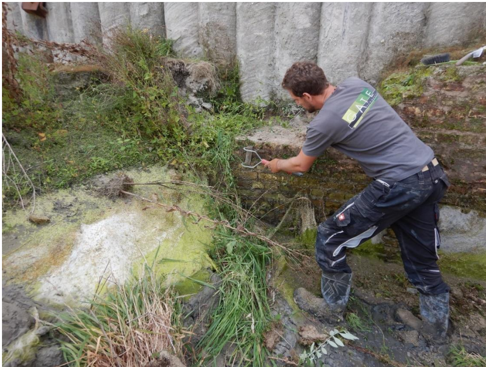
Figuur 22: opkuis van de muren op 21 september 2021
