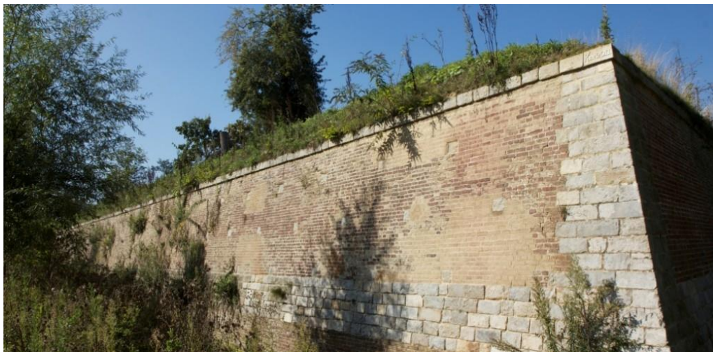
Figuur 139: Zicht op opbouw cortine van Vaubanversterking te Lille. Baksteen, parament en hoekafwerking in natuursteen (@Davy Herremans)
