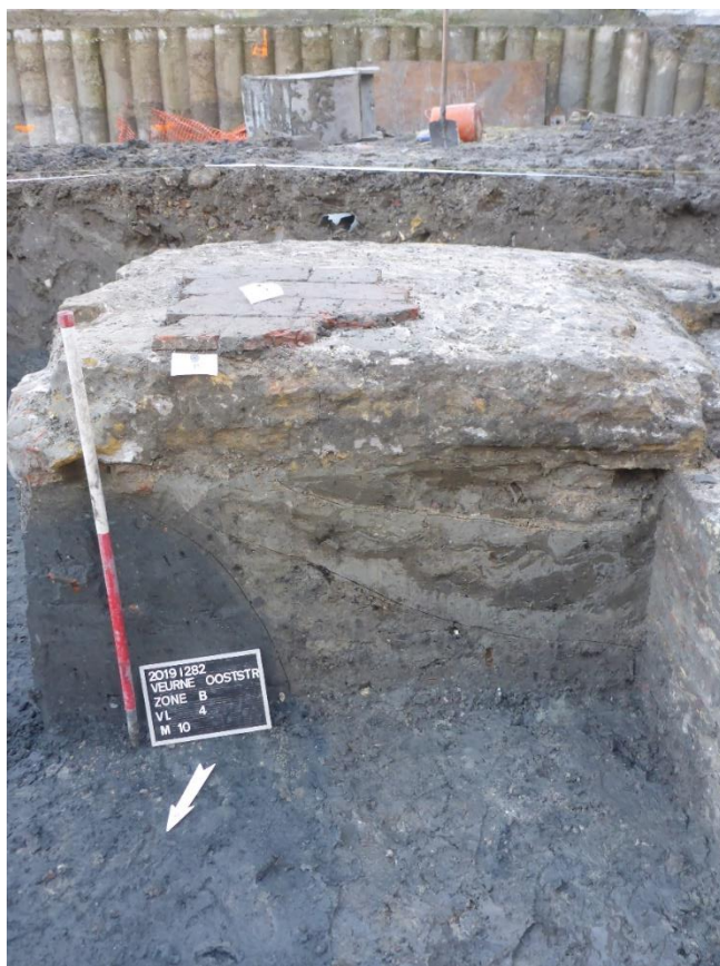
Figuur 131: fotografische opname van M010, fundering 50 en tegelvloer 51
