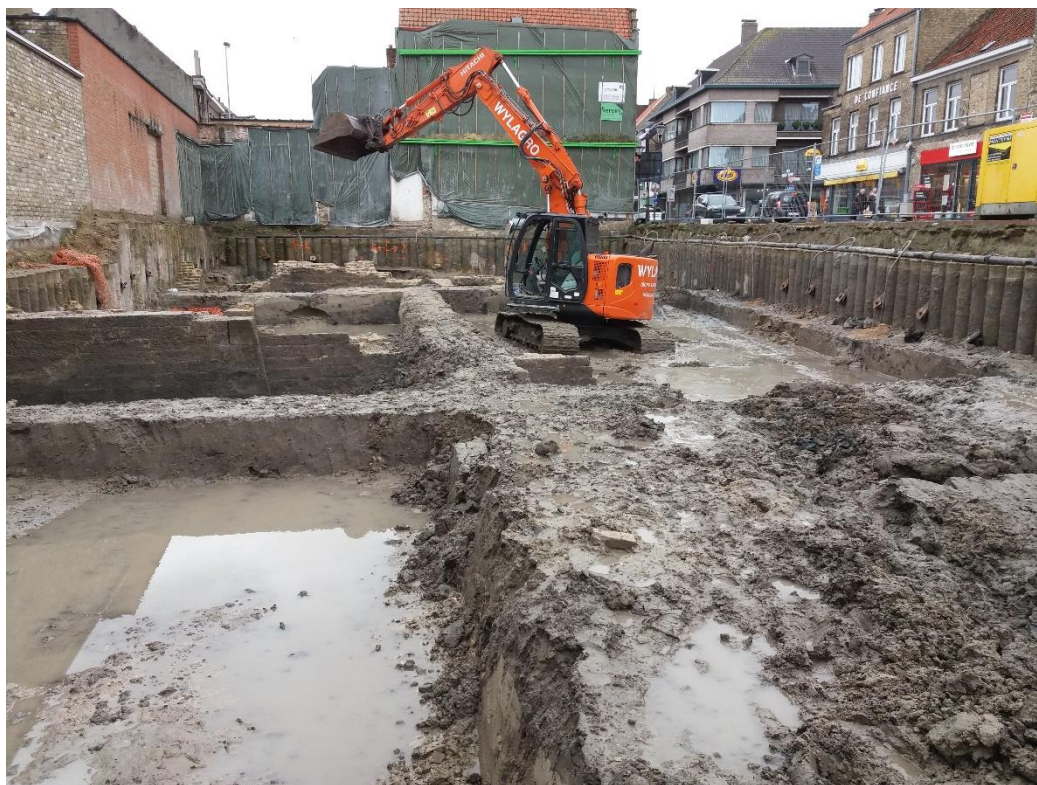
Figuur 85: het plaatsen van de bemaling in zeer natte omstandigheden op 27 november 2019
