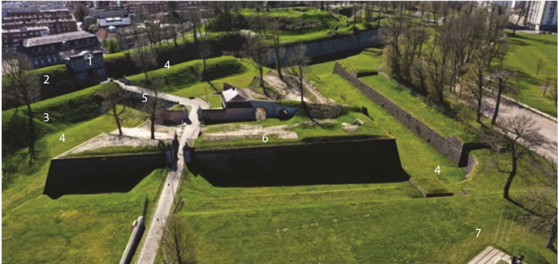
Figuur 138: Vauban versterking in Maubeuge. Situatie vergelijkbaar met de die aan de Oostpoort in Veurne. 1: poort; 2: wal/courtine; 3: tenaille; 4: gracht; 5: brug; 6: demi-lune; 7: glacis (@ Davy Herremans)
