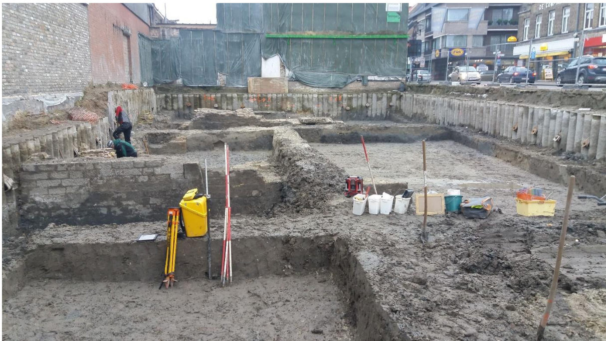
Figuur 17: zicht op het westelijke deel van de bouwput - medio november 2019
