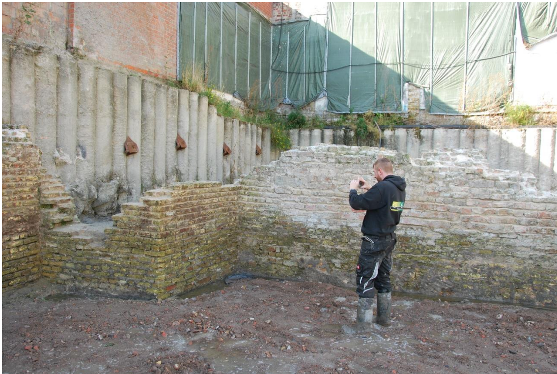
Figuur 24: fotogrammetrische registratie van het muurwerk
