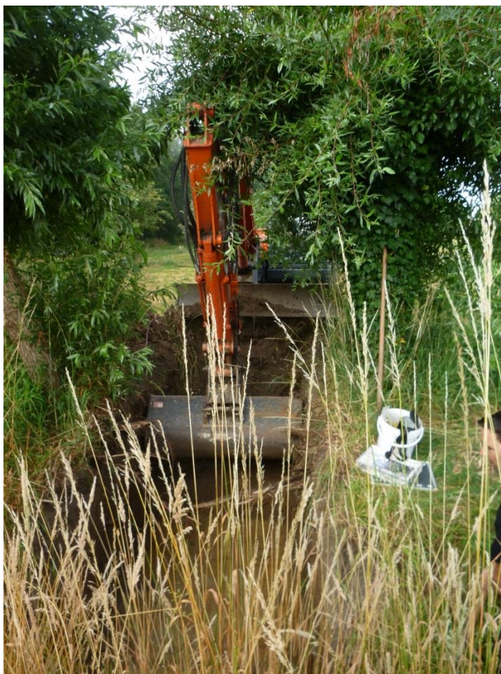
Figuur 40: sfeerbeeld van het aanleggen van de putten tussen de knotwilgen
