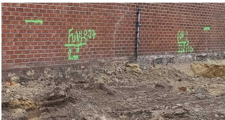
Fig. 6: aanduidingen op de zijgevel van het pand aan de westzijde van het terrein met betrekking tot de funderingsdiepte van die gevel en detail ervan
