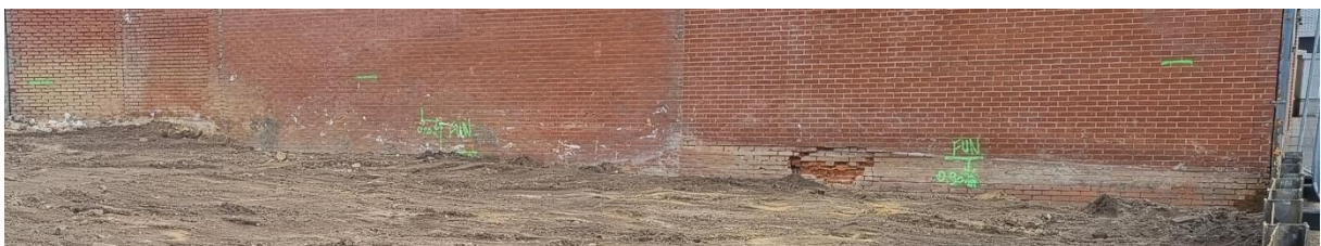
Fig. 4: aanduidingen op de muur van het oostelijk aanpalende pand betreffende de diepte van de fundering van de zijgevel
