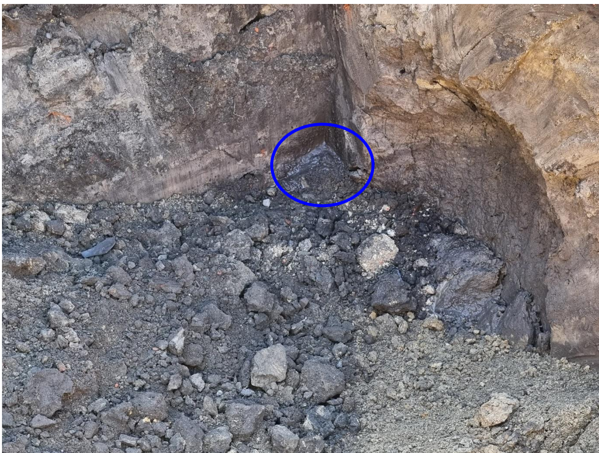
Fig. 26: insijpelingspunt van het grondwater nadat wanden van de profielput al ingekalfd waren
