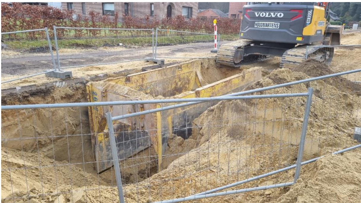
De sleufbekisting die gebruikt wordt voor de aanleg van de riolering
