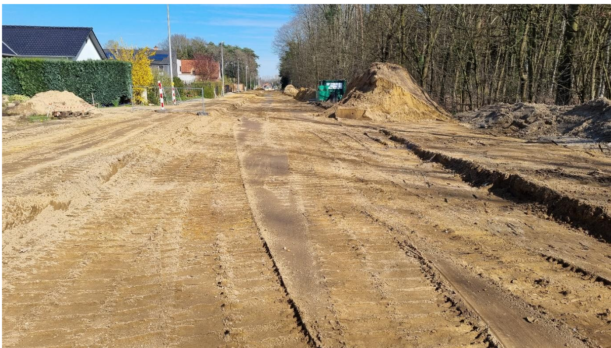
Fig. 28: Het aangelegde vlak op 04/04/2023
