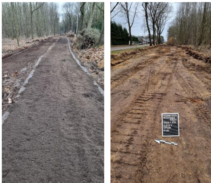
Fig. 17: foto's van het aangelegde vlak, vlak na de ontbossing en na de verwijdering van de strooisellaag (A-horizont)
