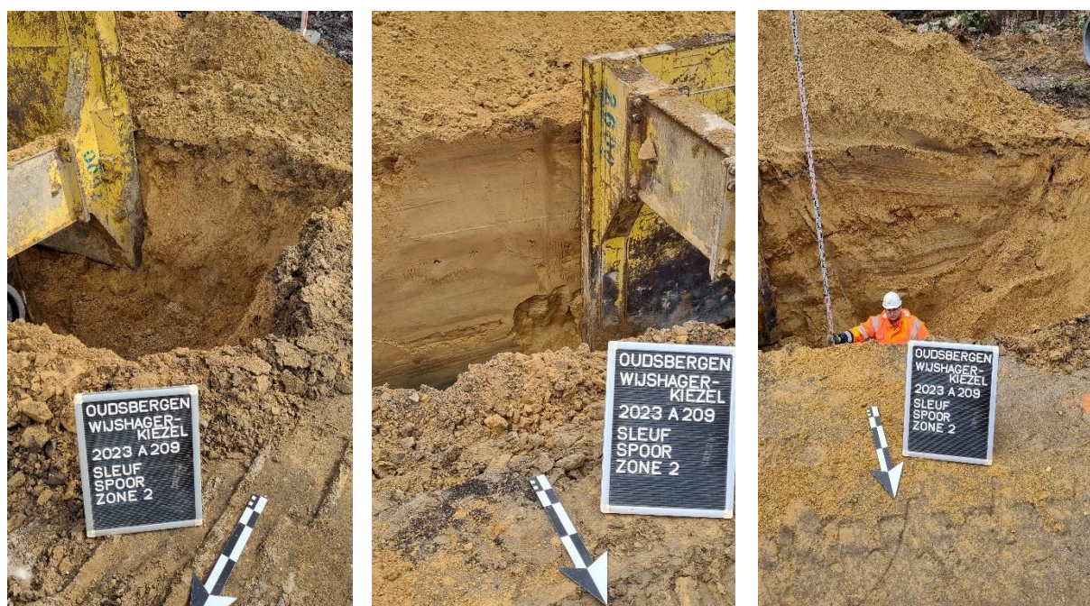
Fig. 12: Bodemprofielen waargenomen tijdens de aanleg van de riolering
