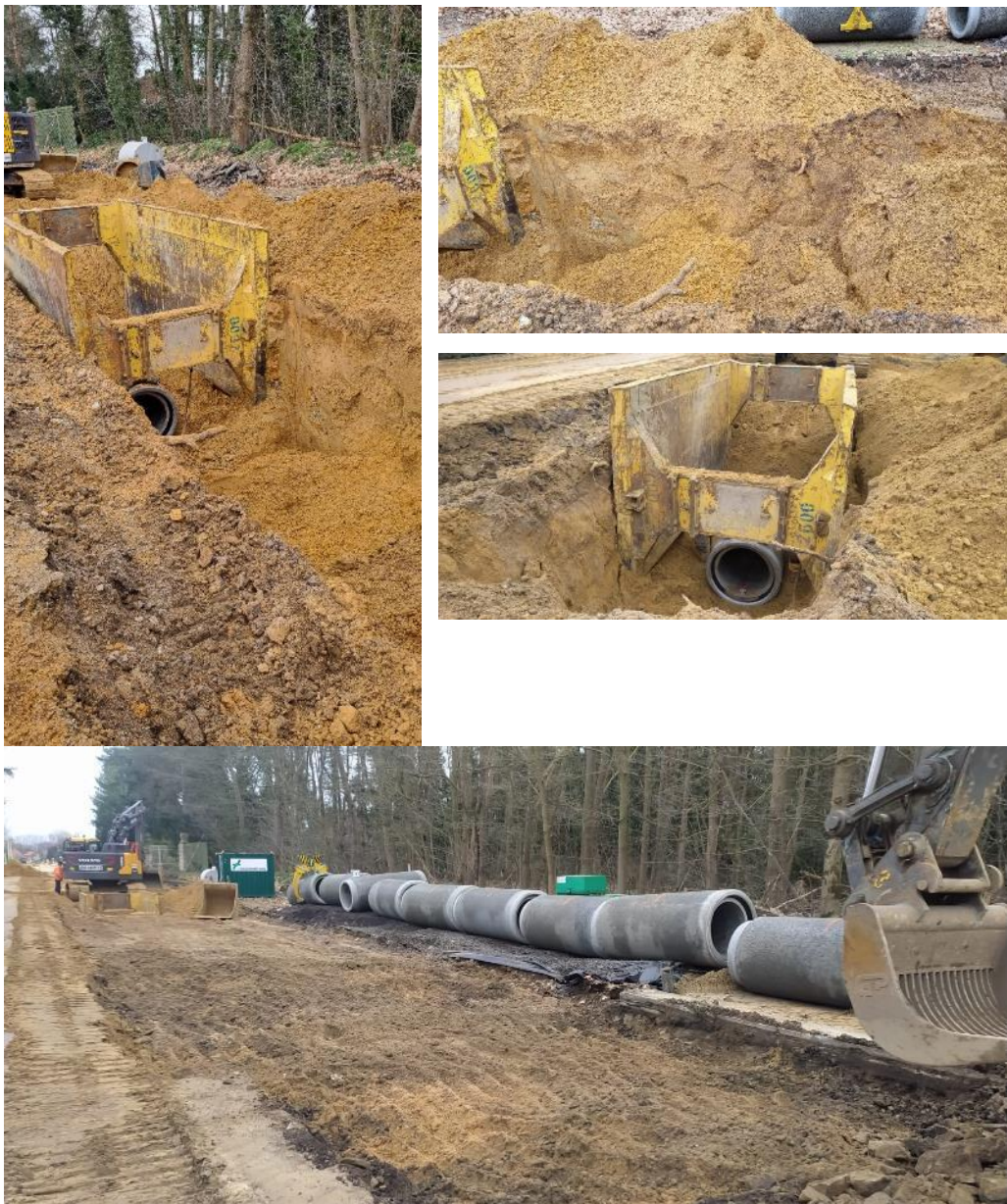
Aanleg van riolering en verdere verwijdering steenslagfundering
