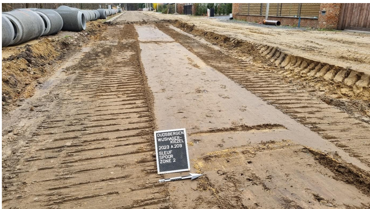
Fig. 24: Het aangelegde vlak op 29/03/2023
