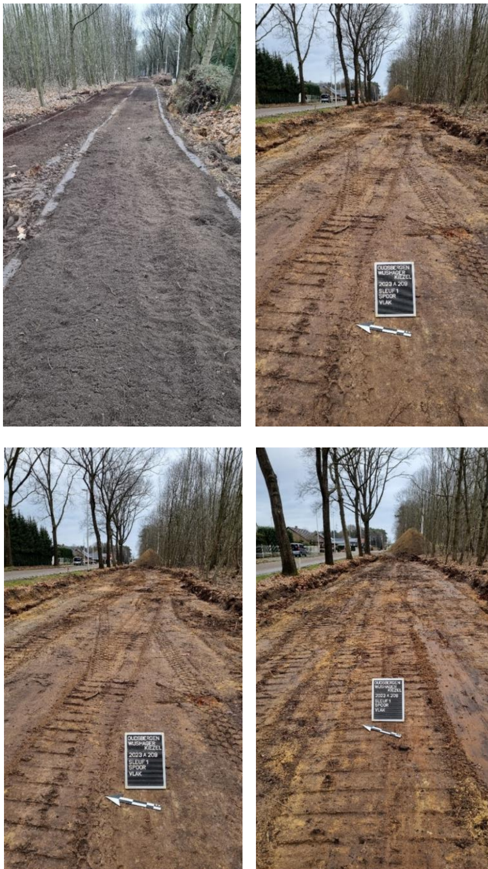
Fig. 7: foto's van het aangelegde vlak
