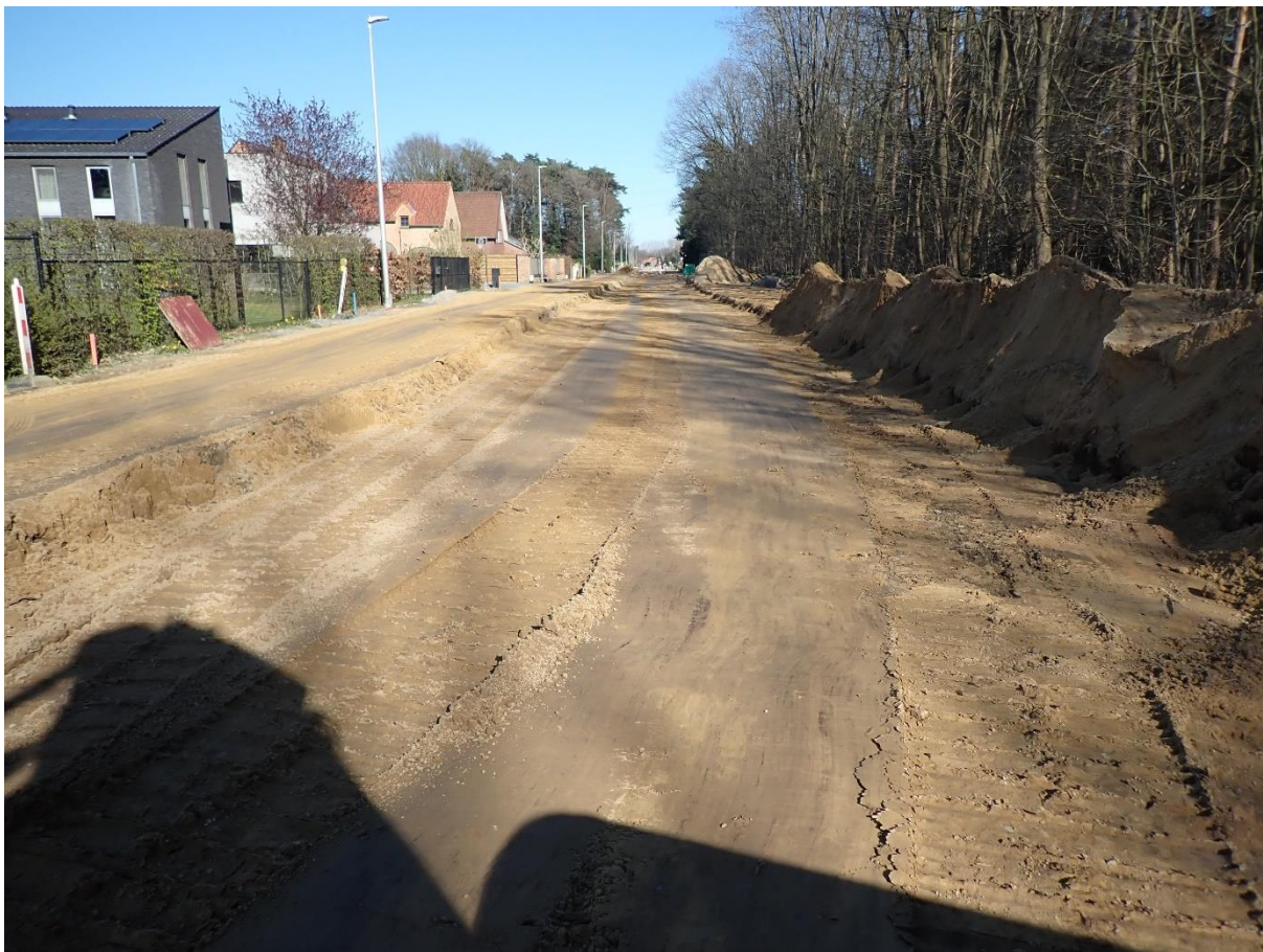
Fig. 27: Het aangelegde vlak op 03/04/2023
