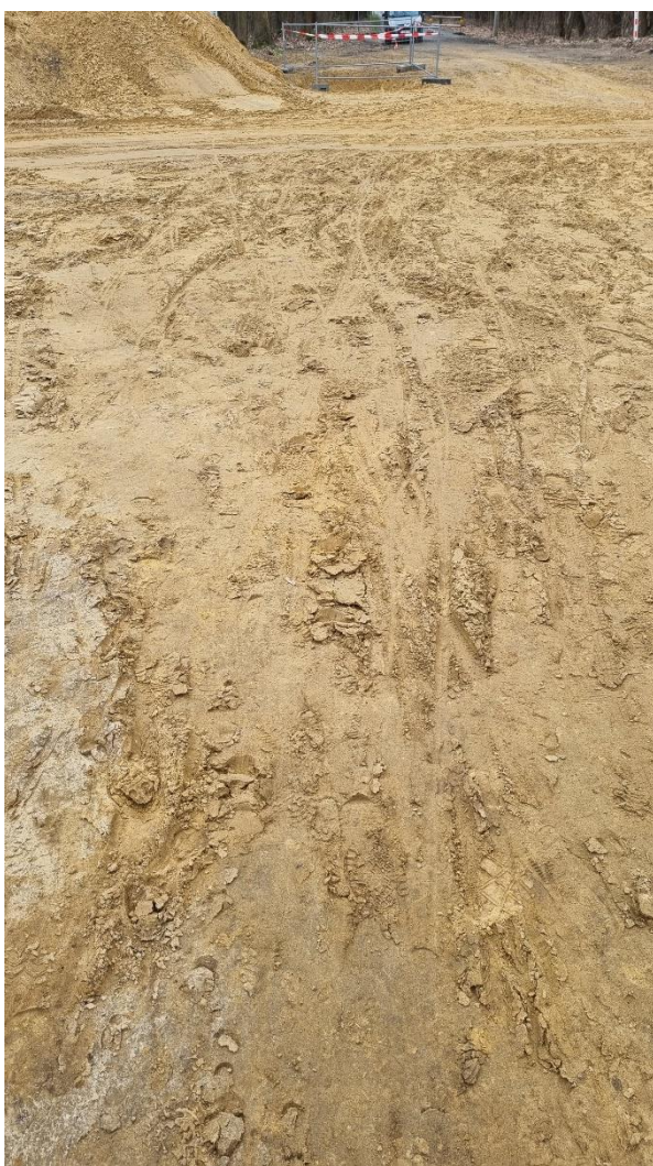
Fig. 30: Het aangelegde vlak op 12/04/2023, een dwarsriolering, heraansluiting van de riolering op de kop van de Rietenstraat, dwars over de Wijshagerkiezel naar de Venstraat.
