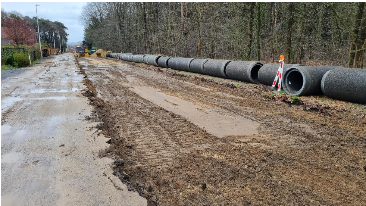
Fig. 26: Het aangelegde vlak op 31/03/2023
