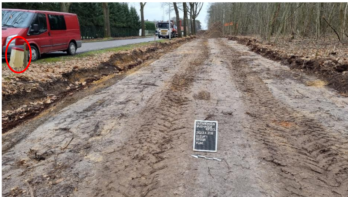
Na het aanwalsen (boven) en (links) de gracht parallel aan de straat, de rood omcirkelde kilometerpaal geeft de afstand tot de Rietenstraat aan, zijnde 100 meter
