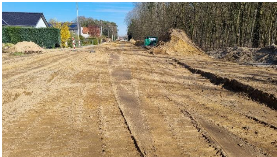
Het vlak na plaatsing van de riolering
