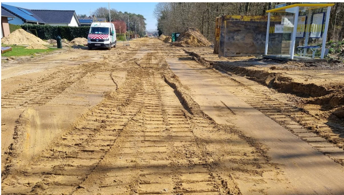
Fig. 29: Het aangelegde vlak op 05/04/2023
