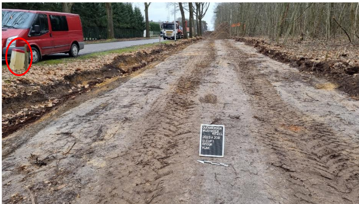
Fig. 19: het vlak na het aanwalsen met links de gracht parallel aan de straat, de rood omcirkelde kilometerpaal geeft de afstand tot de Rietenstraat aan, zijnde 100 meter
