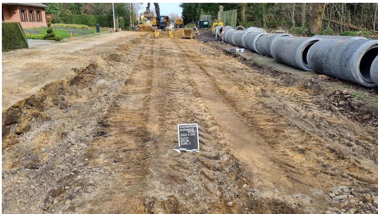
Fig. 23: Het aangelegde vlak op 28/03/2023
