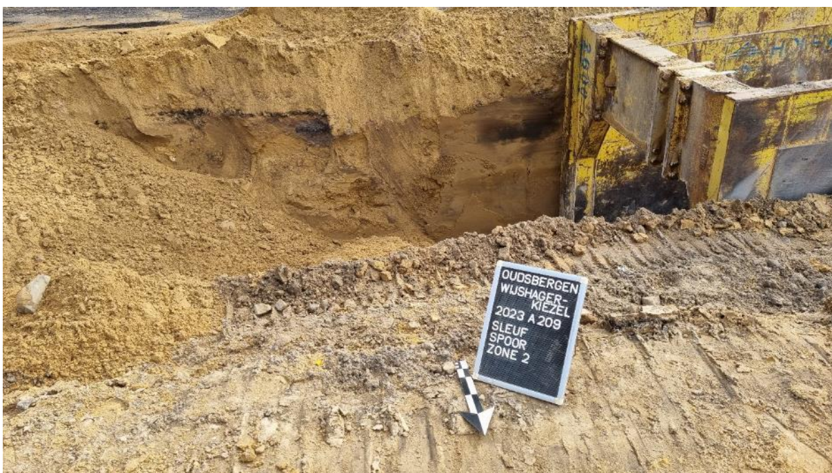
Beperkt zicht op het bodemprofiel tijdens de aanleg van de rioolbuizen
