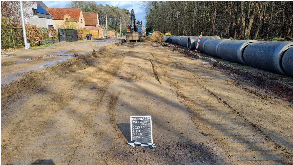
Fig. 25: Het aangelegde vlak op 30/03/2023
