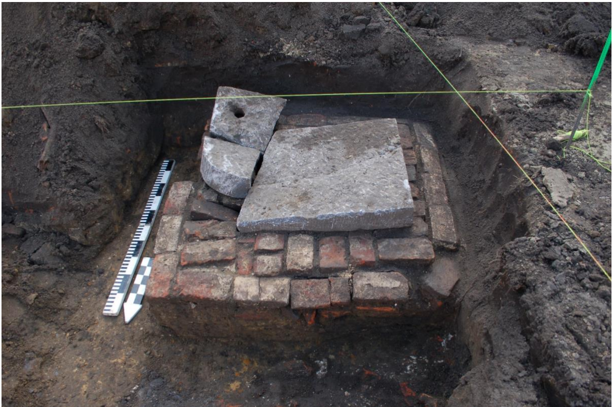
Figuur 16: Zicht vanuit het noorden op de vrijgemaakte toegangspot. Het deksel betreft een omgekeerde arduinen pompsteen. De breuken zijn recent en werden vermoedelijk veroorzaakt door het gewicht van de graafmachine.
