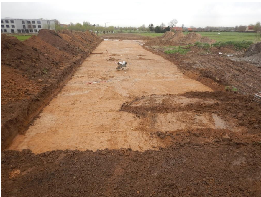
Figuur 86: fotografische opname van de gedeeltelijke opengelegde werkput 1.
