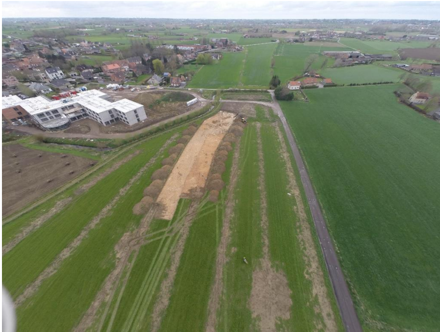
Figuur 85: fotografische opname van de gedeeltelijke opengelegde werkput 1.
