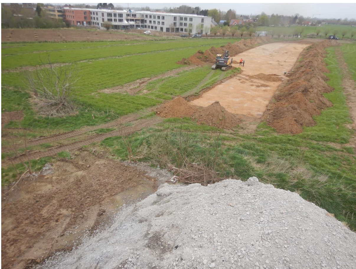
Figuur 25: fotografische opname vanaf de hoop met bouwpuin gelegen tegen werkput 1.
