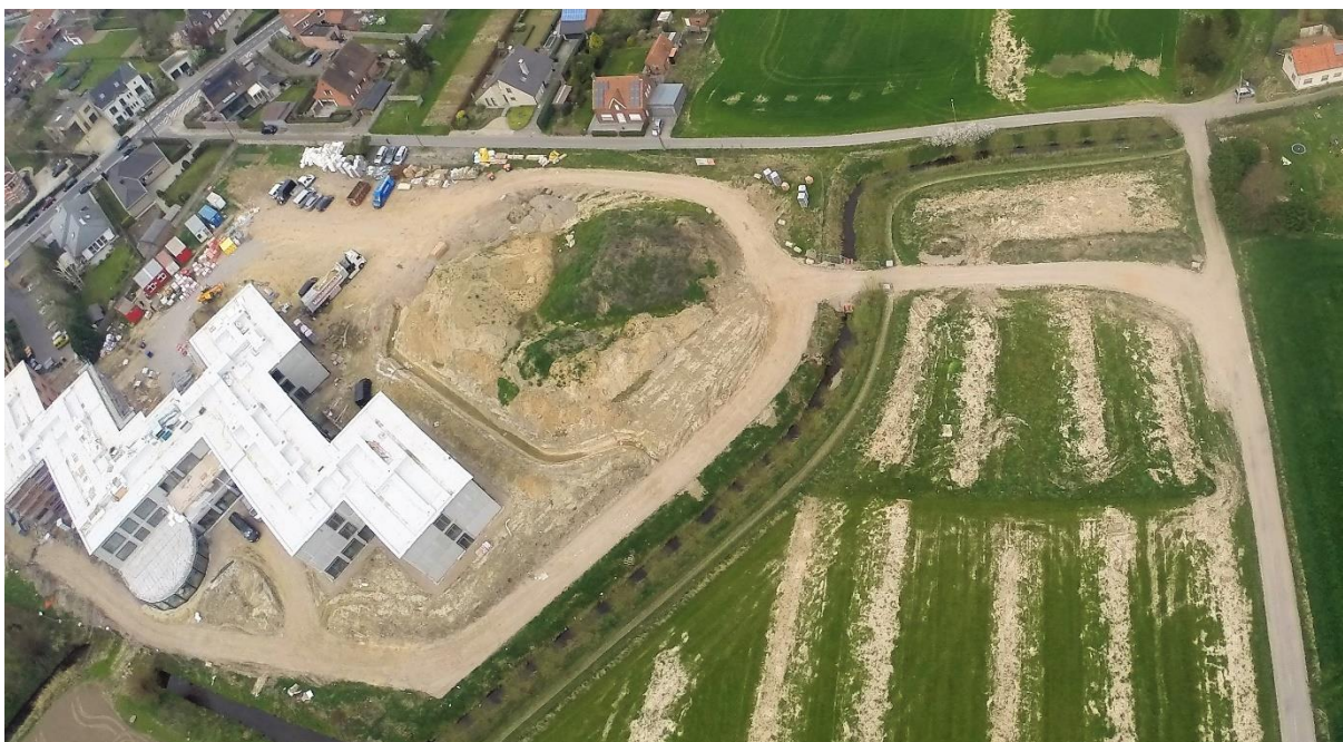
Figuur 24: luchtopname met zicht op de toegangsweg naar de nieuwbouw.
