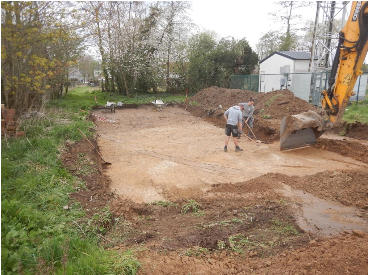
Figuur 13: fotografische opname van de aanleg van werkput 5 met zicht op aanwezige sporen.
