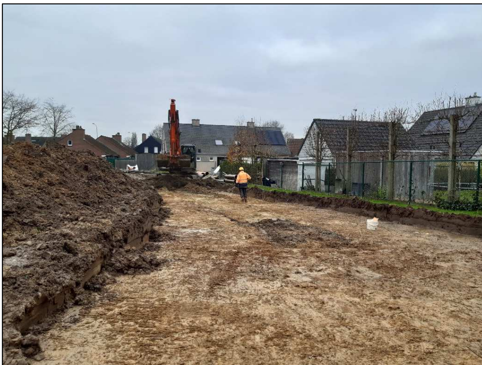
Figuur 3: Zicht op werkput 5 in westelijke richting
