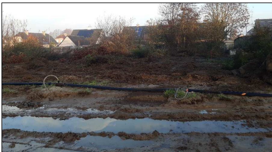
Figuur 4: Zicht op de lijnbemaling centraal op het vlak
