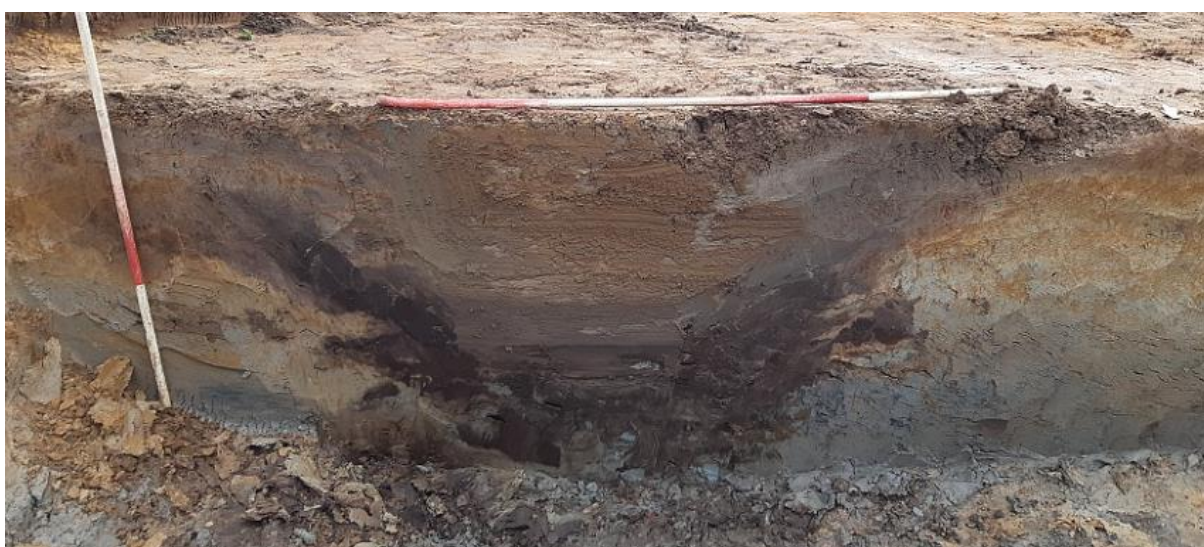
Figuur 26: Coupe op kuil S3007 in werkput 4. Gezien de instabiliteit van de coupe, kon de wand niet goed opgeschoond worden.
