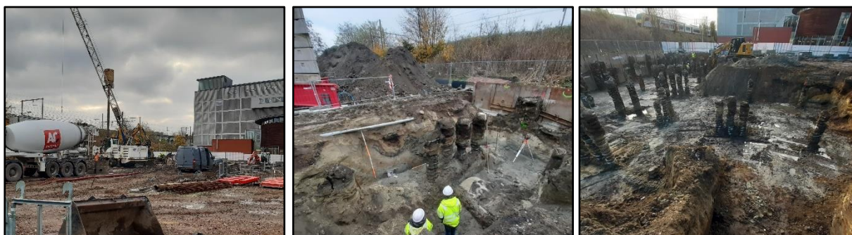
Figuur 1: Opstart (links, 29/11/2022), halfweg (midden, 01/12/2022) en eindfase (rechts, 08/12/2022) van de aanleg van de bouwput voor de nieuwe fietsenberging (ABO nv 2022)
