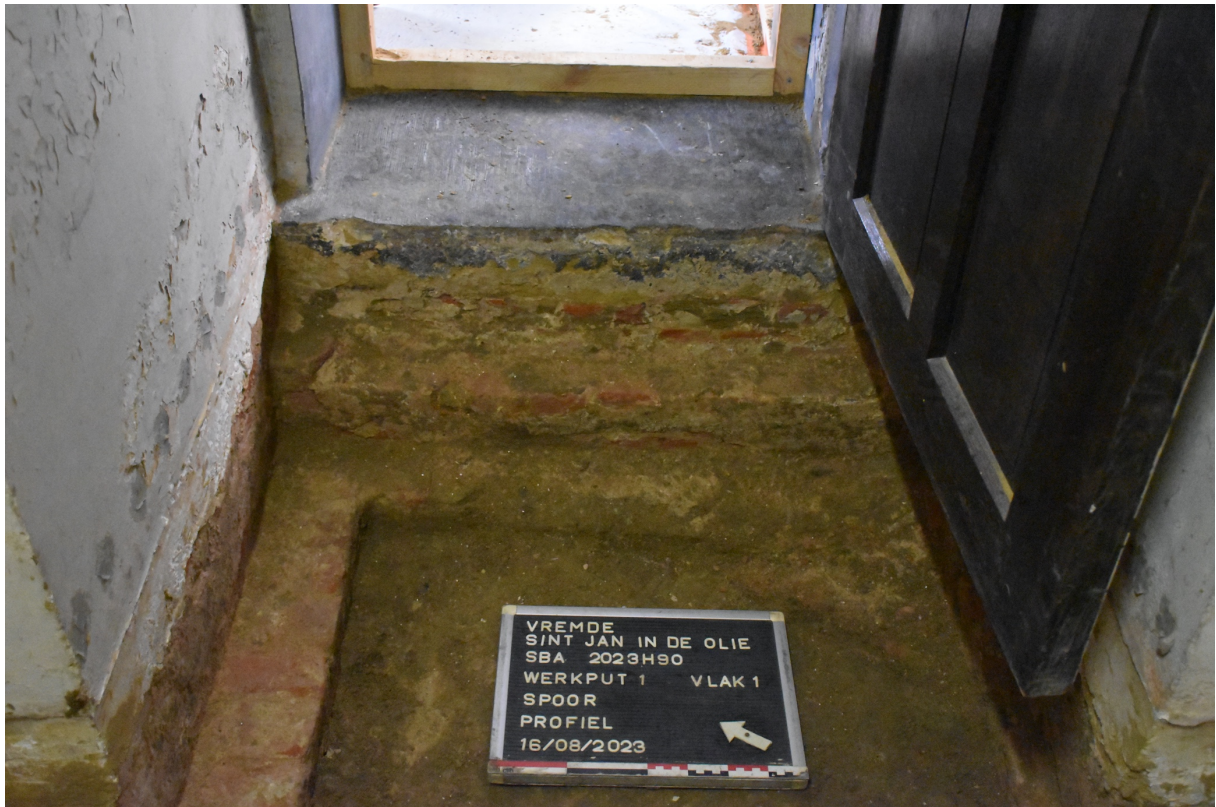
Fig. 2.4: Verstek onder de deur.
