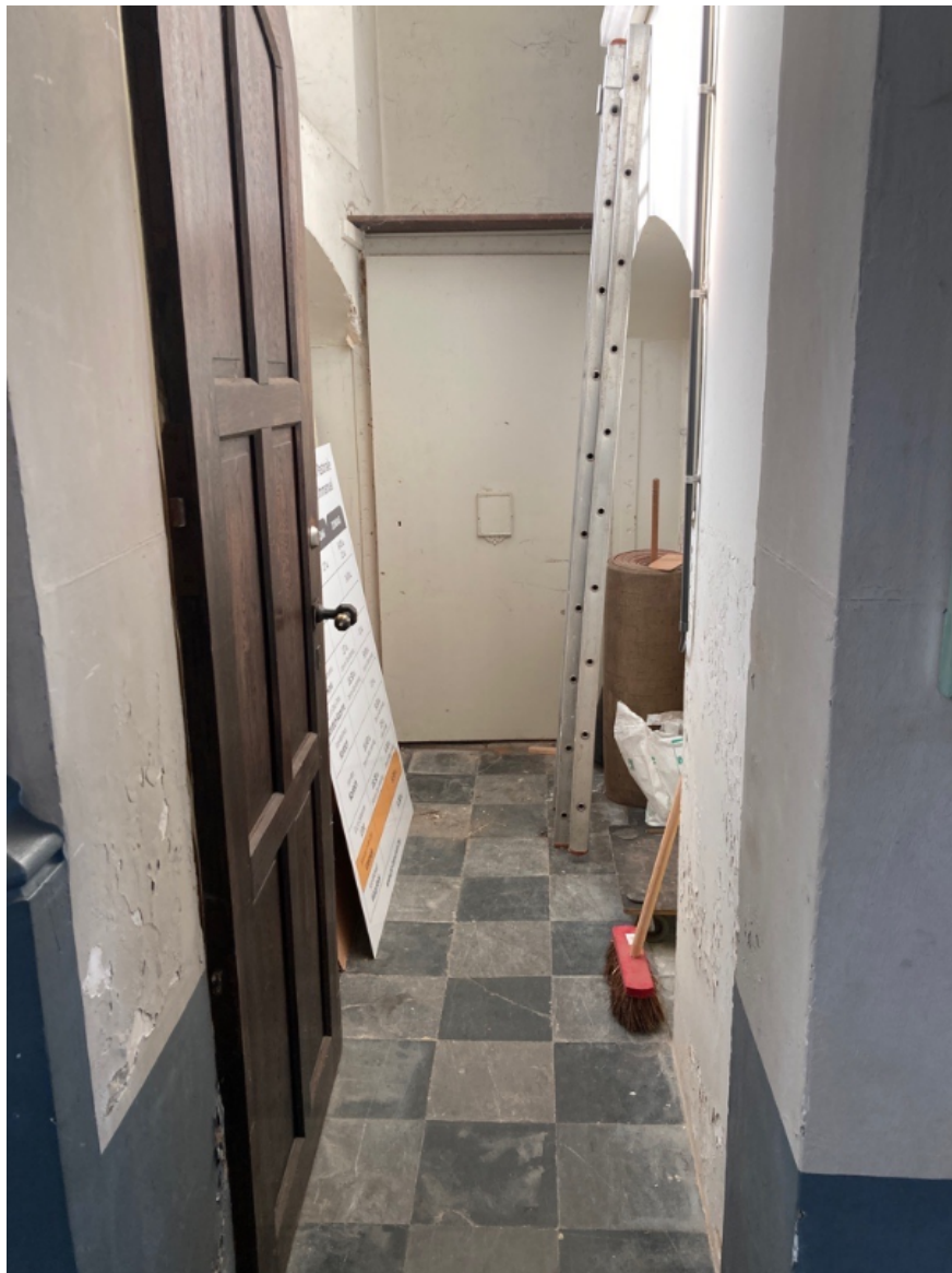
Fig. 2.2: De tegelvloer in de bergruimte voor aanvang van het onderzoek (©aannemer).
