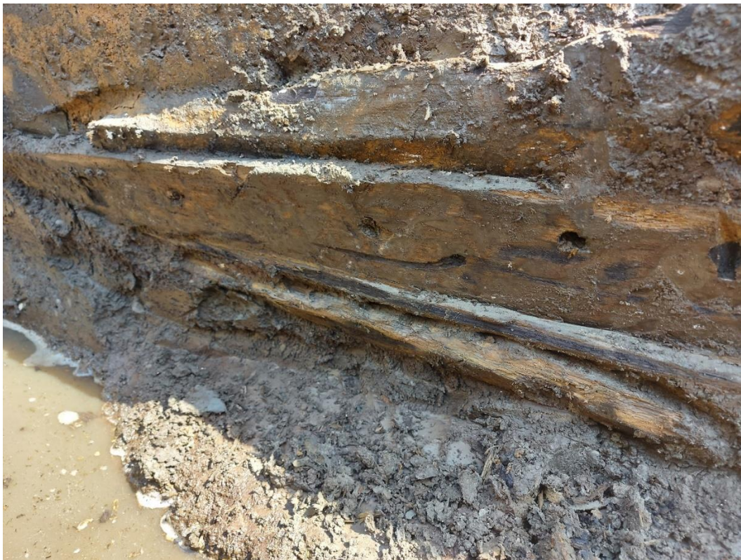
Figuur 64: detailfoto van de beschoeiing met weergave van een paal met verschillende gaten. Dit wijst mogelijk op het gebruik van recuperatiehout.
