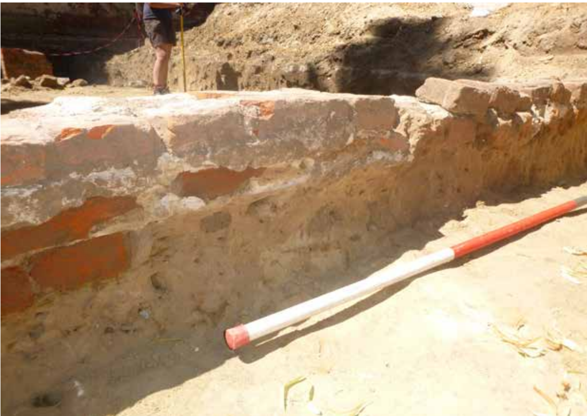
Figuur 85: Detail van overgang S13 (links op foto) en S12.
