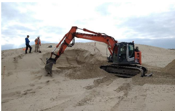
Figuur 43. Laagsgewijs afgraven van de duin.
