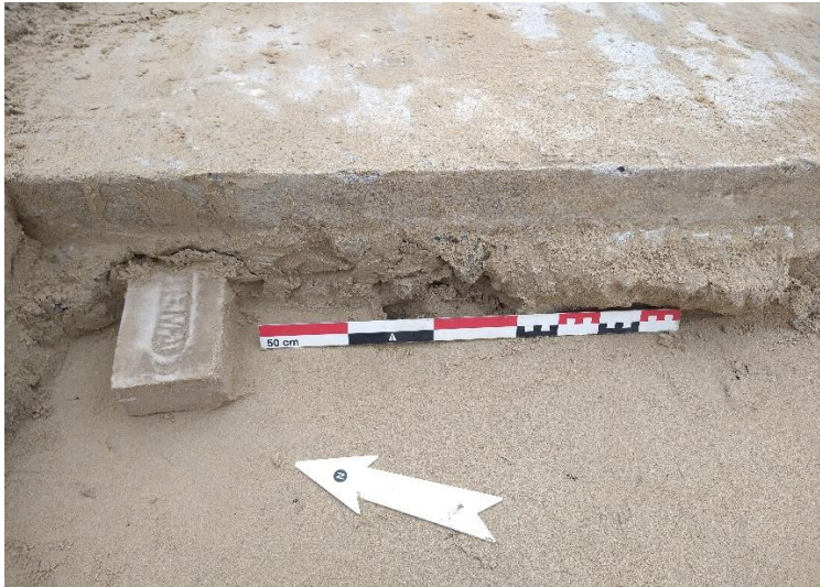
Figuur 62. Een baksteen onder de betonweg, op de houten bekisting stabiel te zetten.
