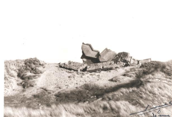
Figuur 39. Een opgeblazen bunker in de duinen van De Panne, welke deel uitmaakte van de Atlantikwall. periode: 1945-1959. (bron: https://westhoekverbeeldt.be/ , Studio Lionel, De Panne, fotonummer: HEU020501358)
