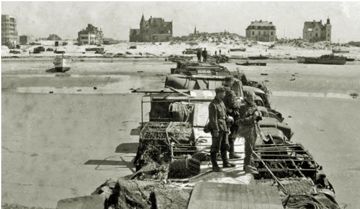
Figuur 27. Voor de Operatie Dynamo, het evacueren van geallieerde troepen via de Noordzee, werden op het strand van De Panne tijdelijke pieren opgericht met militair materiaal (bron: Operatie Dynamo (google.com) ).
