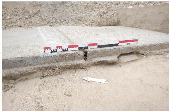
Figuur 60. Op het funderingspakket werd een houten bekisting aangelegd, waardoor tussen de platen steeds onderbrekingen aanwezig zijn.
