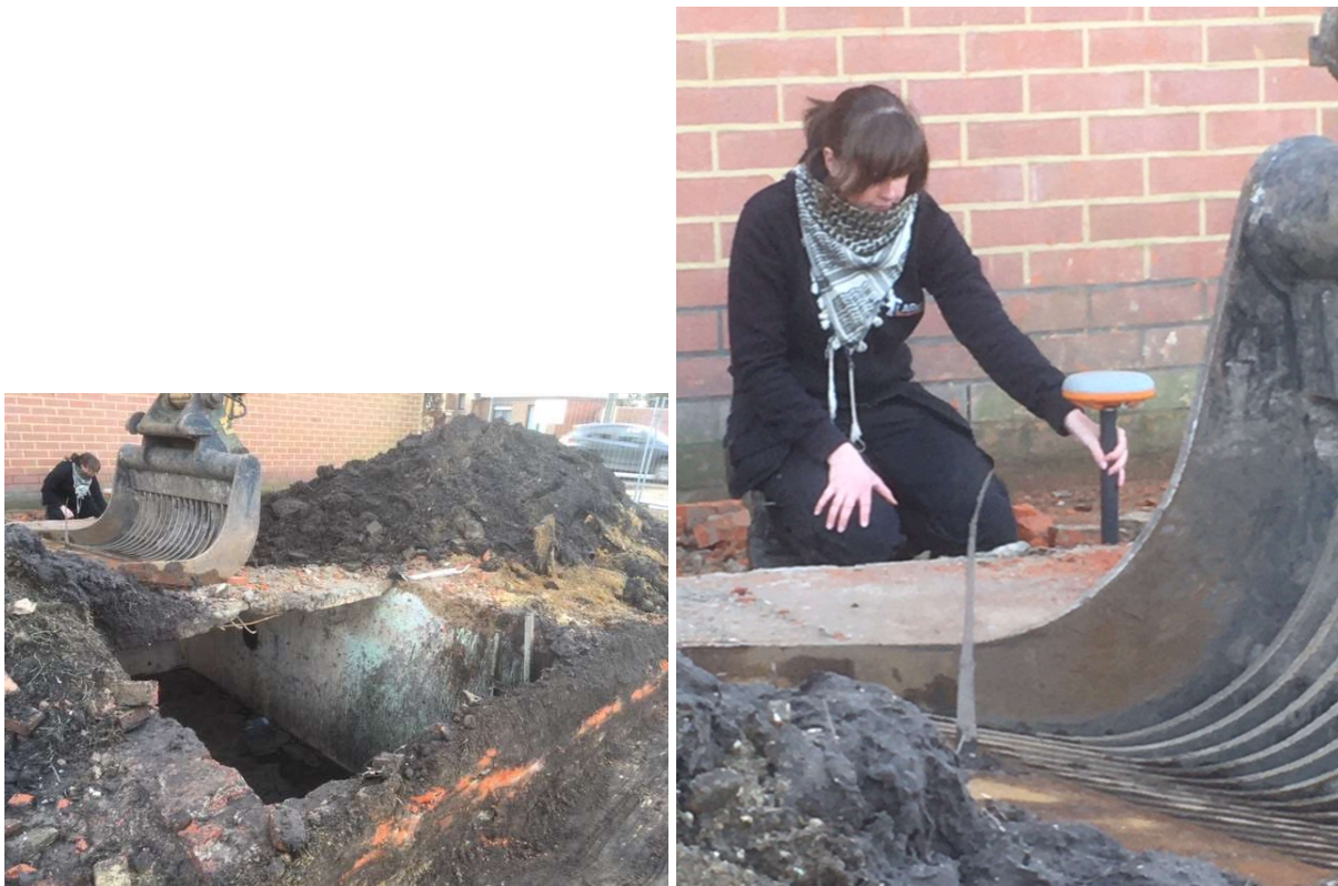
Figuur 3.4. Zicht op de kelder van de gesloopte woning aan de Hoogstraatsesteenweg. Links is te zien dat als de stok van de GPS, die 2 m is, op de keldervloer staat, deze zo goed als volledig in de kelderruimte zit. ©LARES
