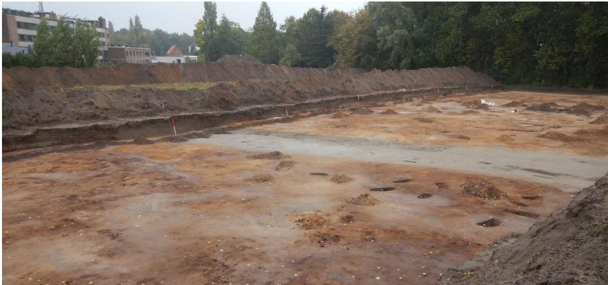
Figuur 21: Overzicht op het lengteprofiel in werkput 1 (profiel 6).
