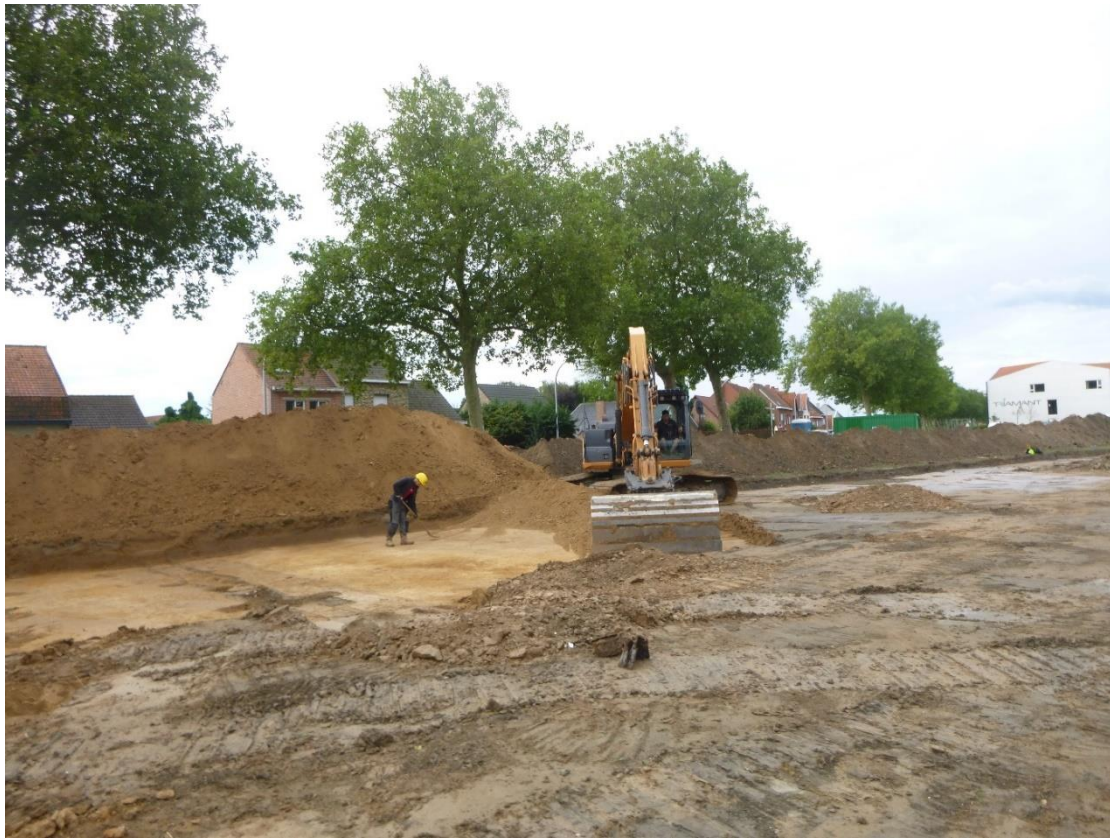
Figuur 3: Aanleg vlak met 21.5 tons kraan.
