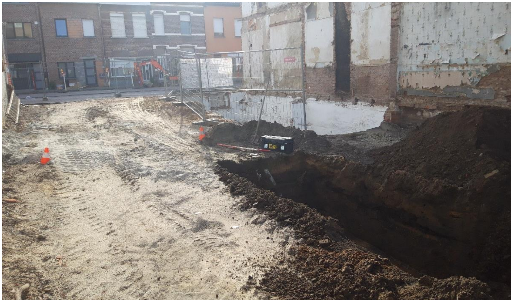
Figuur 9: Zicht op fase 2 (bebouwde zone) met de sleuf tot tegen de kelderruimte palend aan de straatzijde.
