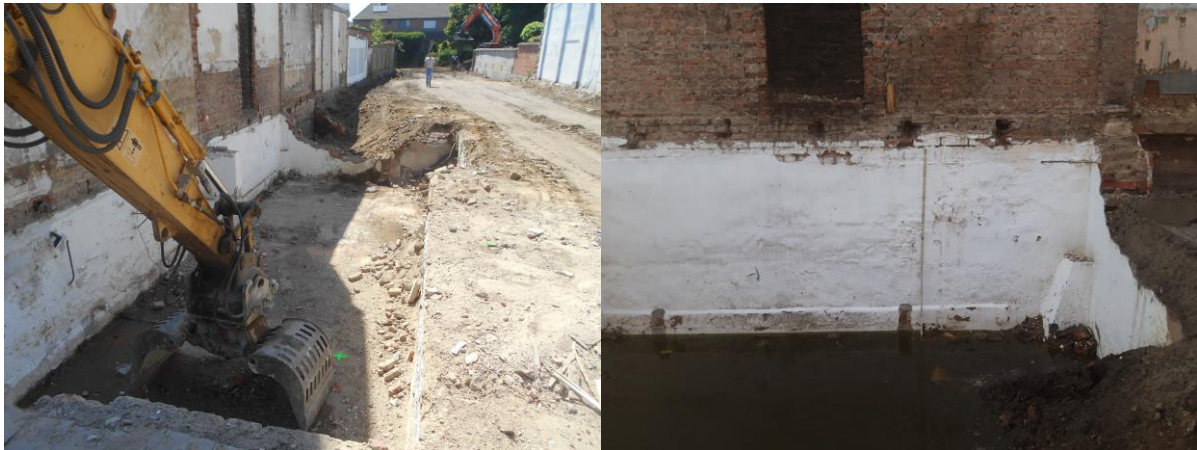
Figuur 8: Zicht op de aanwezige kelder ter hoogte van de straatzijde. De bovenkant van de vloerplaat bevond zich op ca. 1,80m onder het maaiveld.
