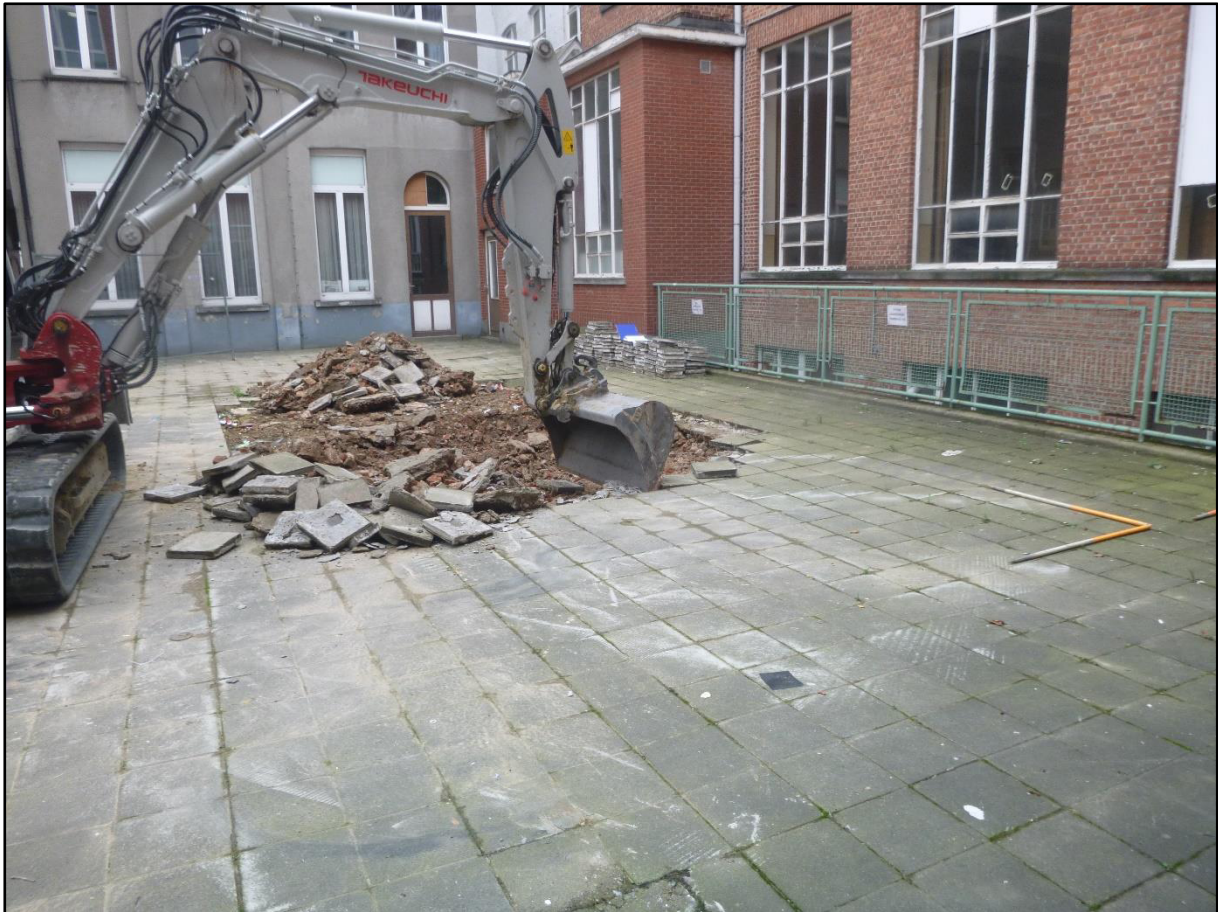
Figuur 5: Algemeen zicht op het schoolplein met zone na het verwijderen van de vloertegels voor de aanleg van de proefput gezien vanuit het westen (ABO nv 2021)
