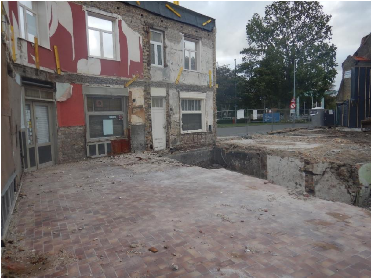
Figuur 3: Overzichtsfoto van het terrein voor de aanvang van de proefsleuven. Zicht uit het westen op de te behouden gevel. Rechts is een kelder zichtbaar waarvan het bestaan niet was gekend tijdens het opstellen van de bureaustudie.
