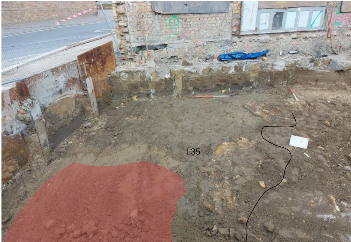
Figuur 55: Zicht op laag L35 met in de voorgrond de versterking veroorzaakt door een profielput (rood), aangelegd tijdens de werfbegeleiding en rechts het puin van de versterking veroorzaakt door een kelder (foto genomen op vlak 2).
