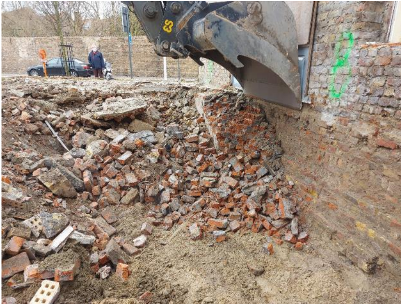
Figuur 10: Uitgraven van de sleuf voor de constructie van de grondkering van de bouwkuip, zicht op de noordzijde van het perceel.
