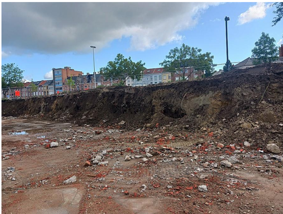
Figuur 5: Zicht op de verwijderde keldermuur thv Zone 1, situatie op 07/08/2023 (@BAAC).
