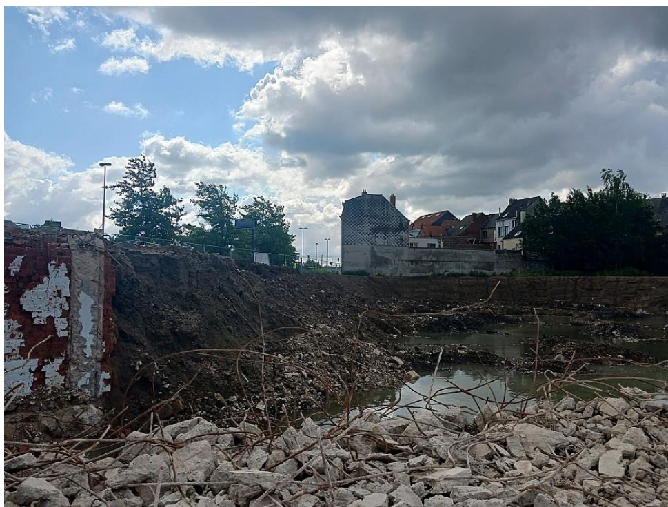
Figuur 4: Weggehaalde keldermuur en aanvulling talud thv Zone 10 , situatie op 07/08/2023 (@BAAC)
