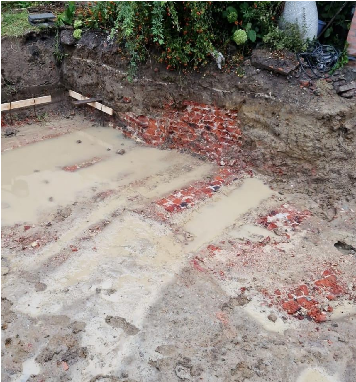
Figuur 7: Foto van de steunbeer na verwijderen van de bovenste delen (© opdrachtgever).
