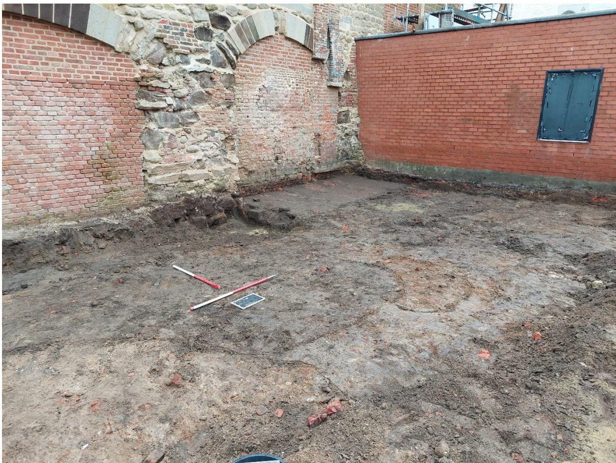
Figuur 12: Overzichtsfoto aan de noordzijde van het studiegebied. De stadsmuur is links te zien en toont duidelijk de toegemetselde spaarbogen.
