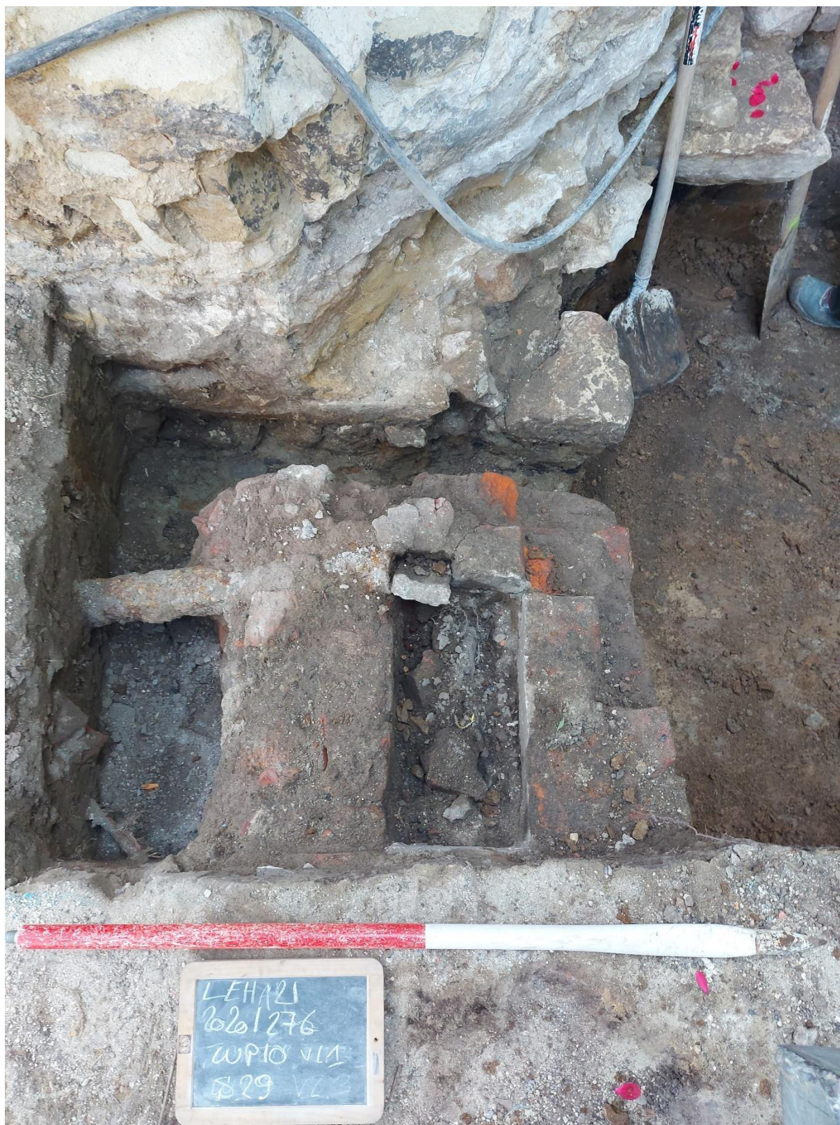
Figuur 28: S28 en S29 in werkput 10, zicht uit het zuiden.
