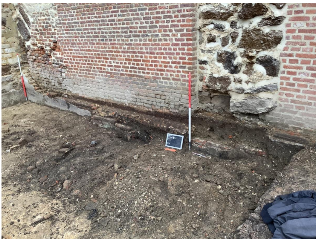
Figuur 44: Oostelijke muur van het Gildehuis (M92) parallel aan de stadsmuur.
