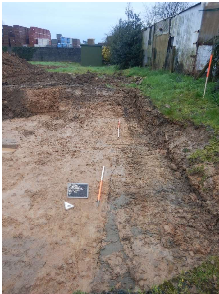
Figuur 6: Verstoring S1 van de hoogspanningskabel die van de Heerbaan tot de groene cabine loopt
