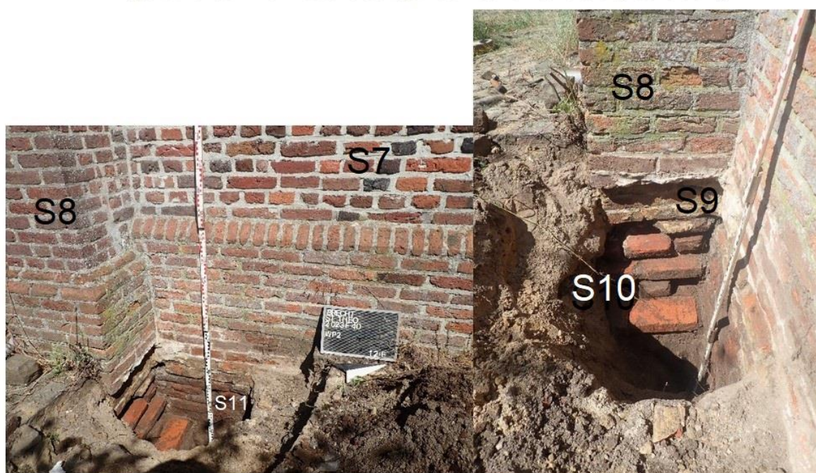
Figuur 6: Werkput 2 met zicht op de fundering van de zuidelijke zijgevel en de fundering onder de steunbeer.
