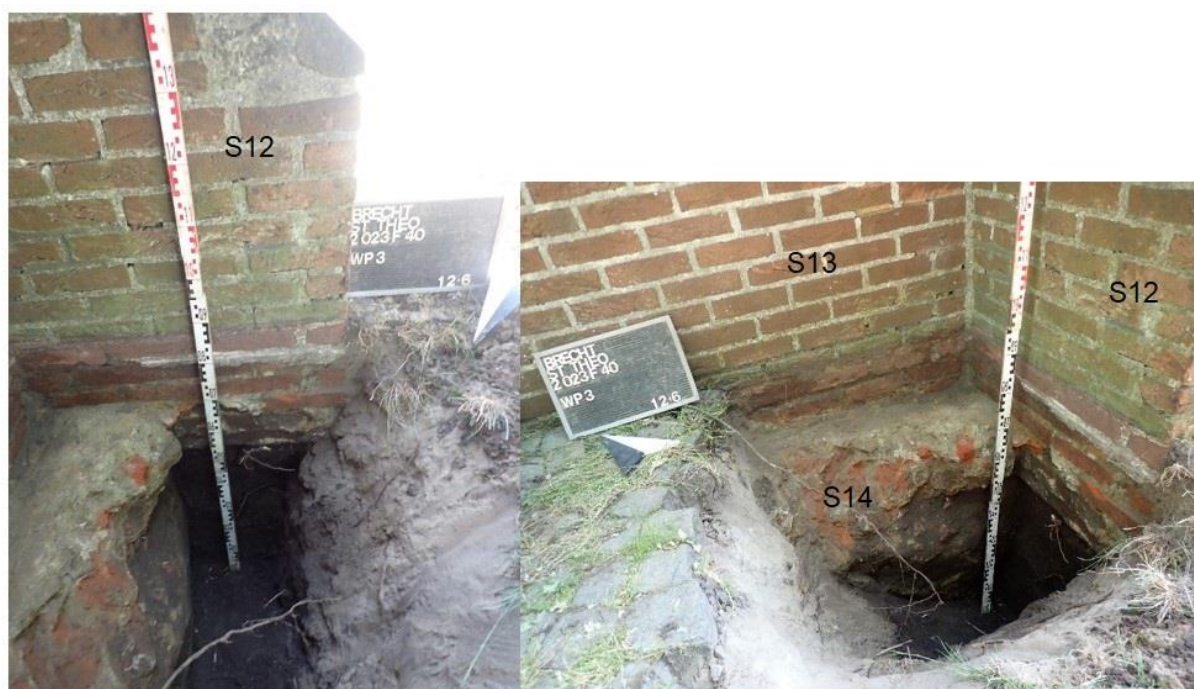
Figuur 7: Werkput 3 met zicht op ontbreken fundering onder steunbeer (L) en zicht op laag met kalkmortel en baksteen (R)
