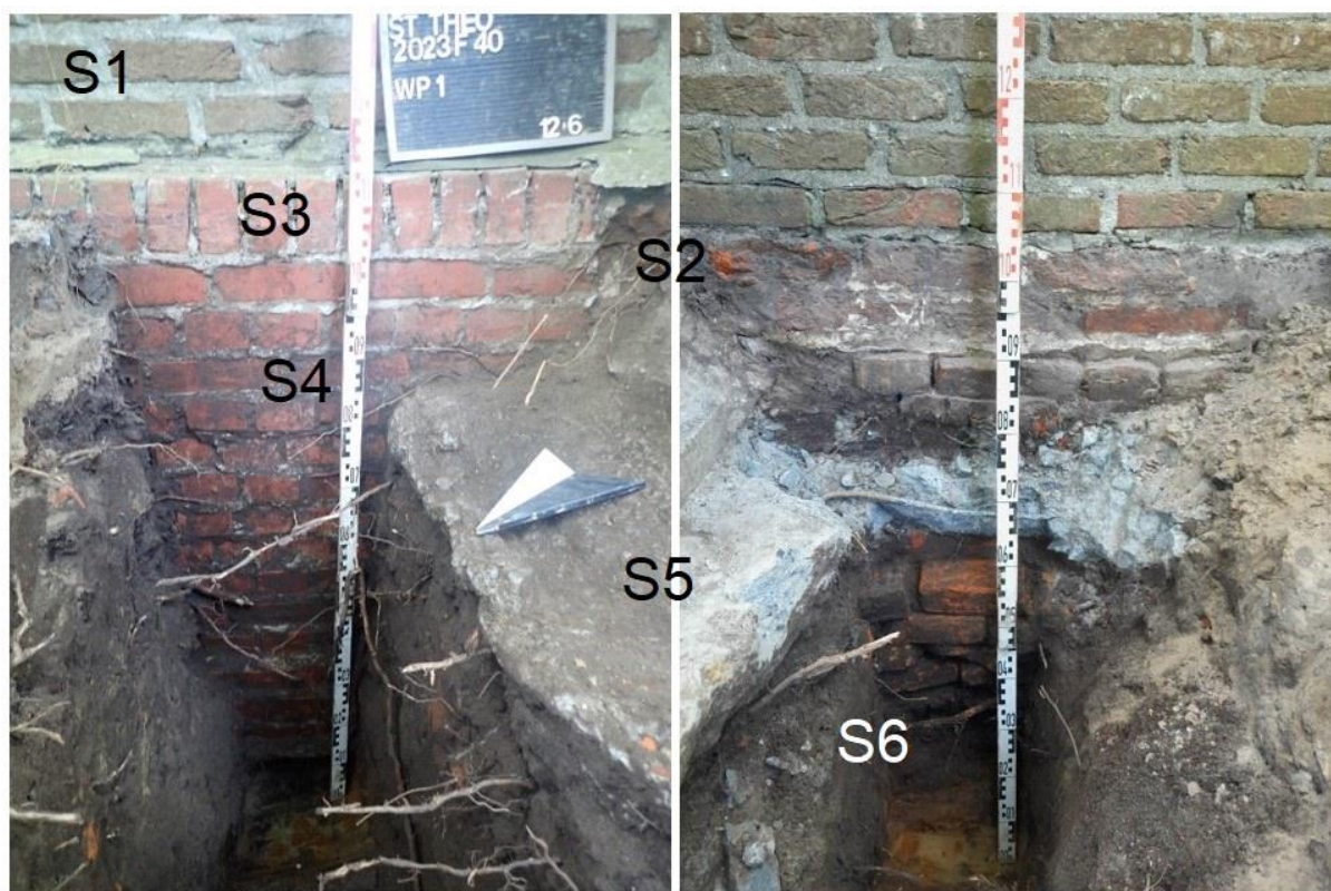
Figuur 5: Werkput 1 met links de herstelling uit 1981-1984 en rechts de originele fundering
