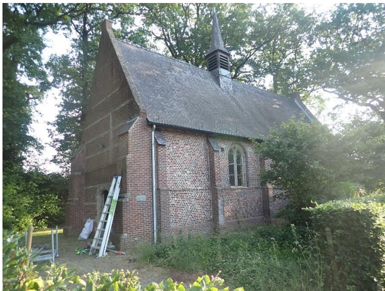
Figuur 3: Zicht op de kapel bij aanvang van het onderzoek
