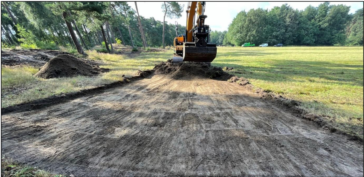
Figuur 17: De aanleg van het enigste vlak binnen werkput 3 in het noordelijke onderzoeksgebied.
