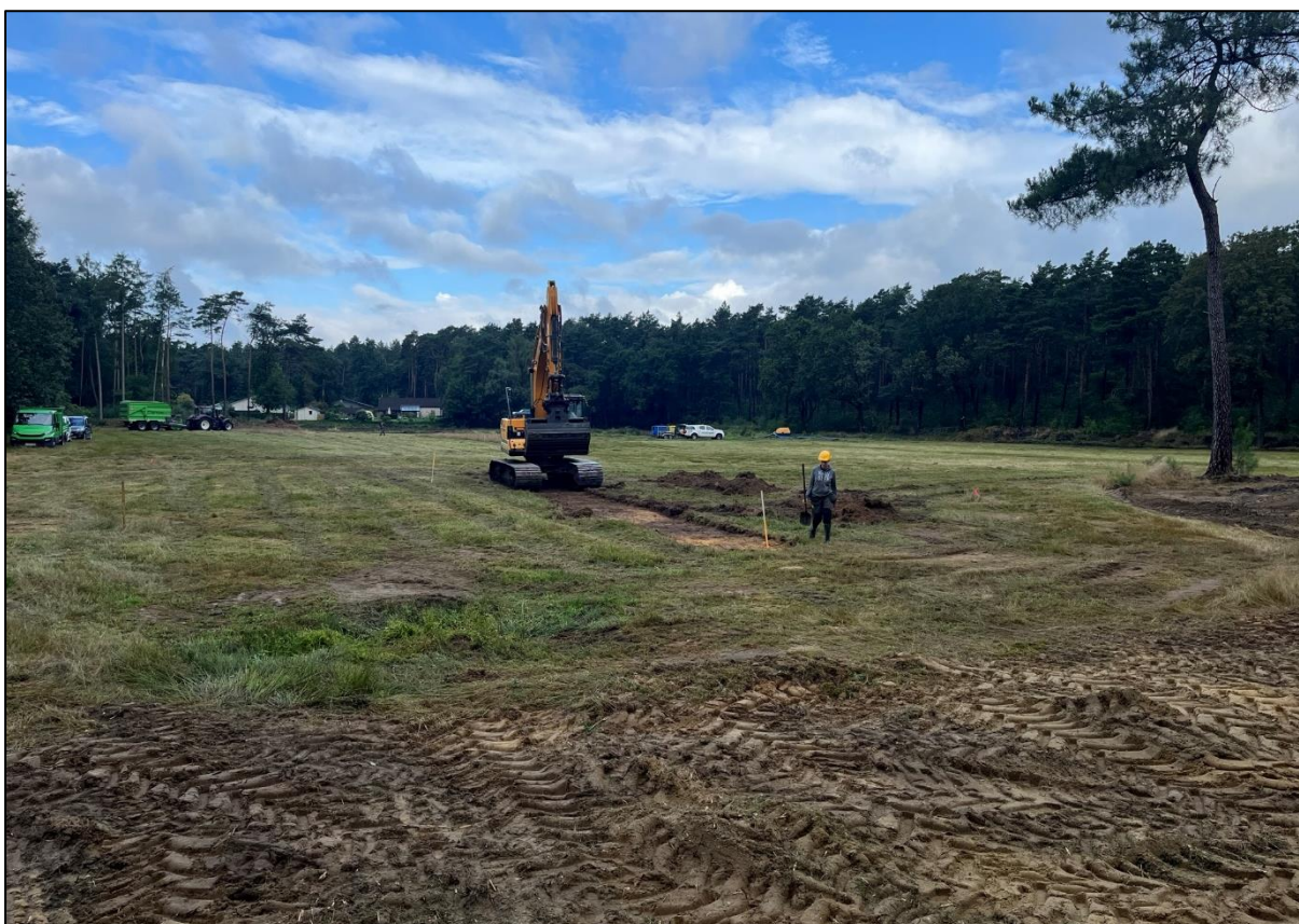
Figuur 27: Omgevingsfoto tijdens de aanleg van werkput 1, die later opgenomen zal worden in werkput 2. Gefotografeerd in westelijke richting.
