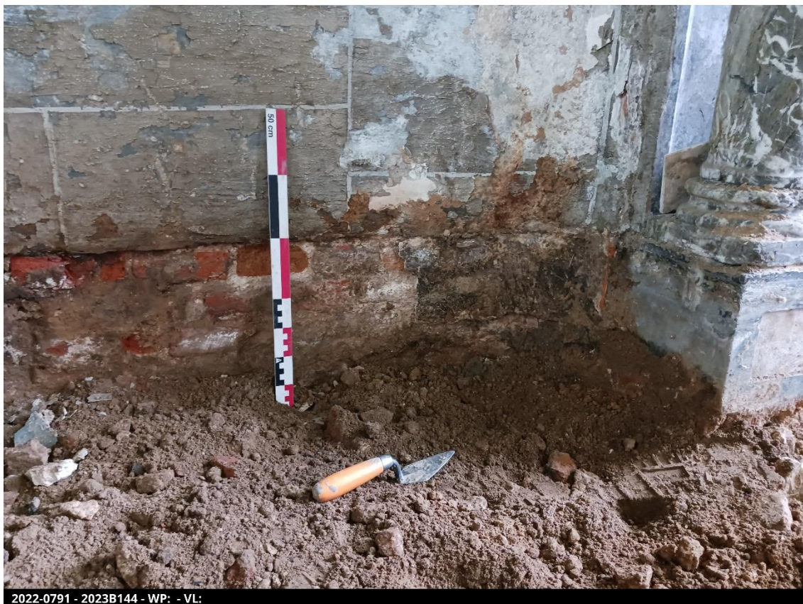
Figuur 9: Weergave uitgraafdiepte in ruimte 0.7.
