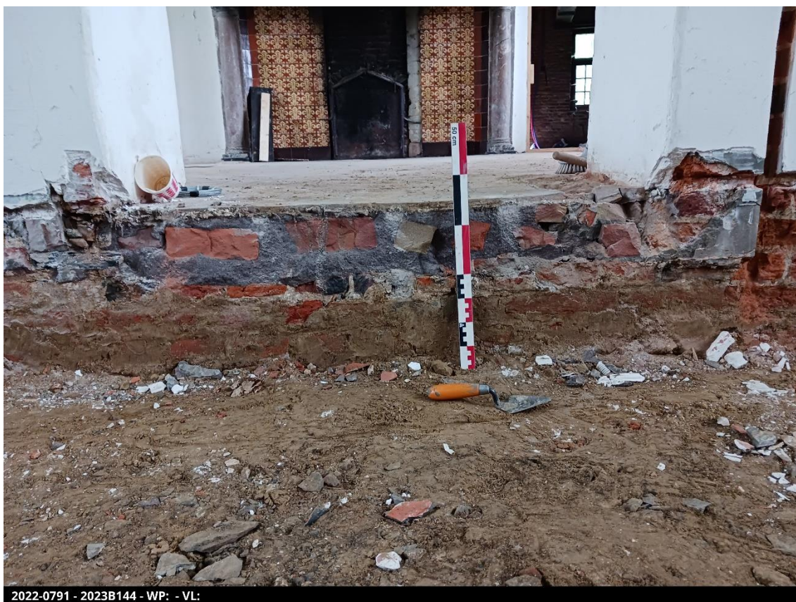
Figuur 8: Uitgraafdiepte ter hoogte van de doorgang tussen ruimte 0.6 en 0.5.
