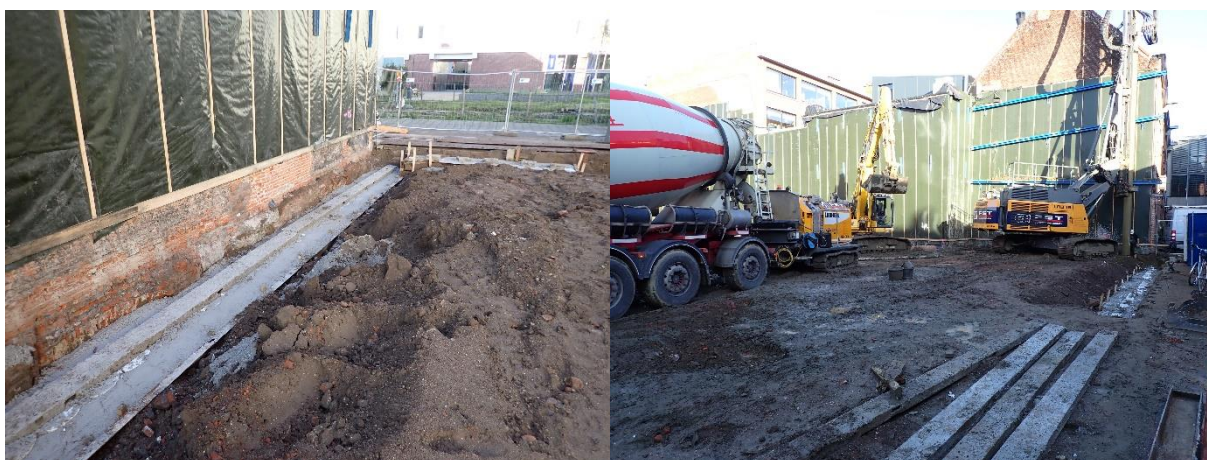
Figuur 56: Plaatsen van de secanswanden op 18 oktober 2022 (© J. Verrijckt bv)
