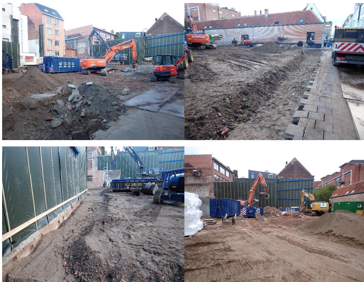
Figuur 54: Voorbereidende werken op 20 en 26 september 2022 (© J. Verrijckt bv)
