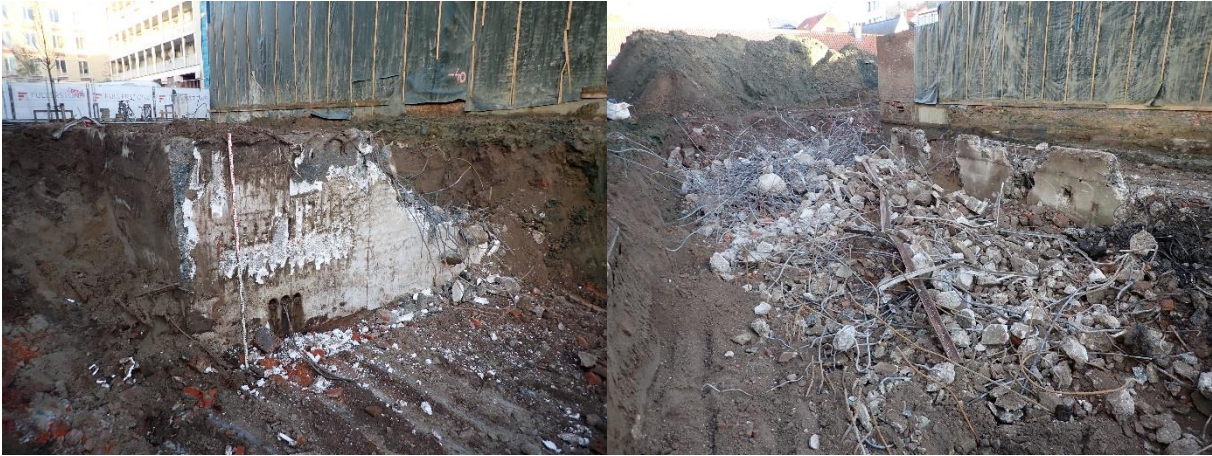
Figuur 58: Werfbegeleiding ter hoogte van deelzone 1 (WP1) op 24 november 2022 (© J. Verrijckt bv)
