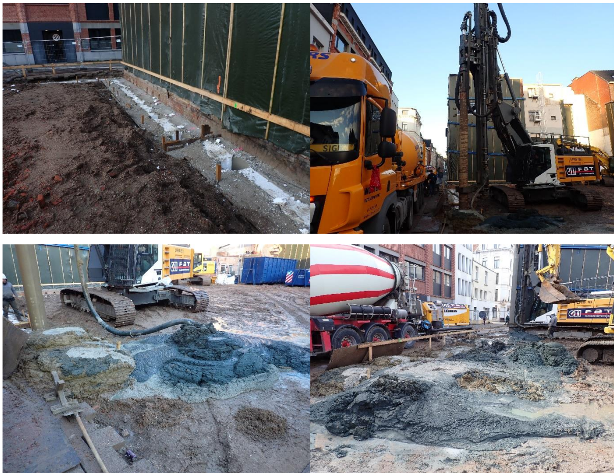
Figuur 55: Plaatsen van de secanswanden op 28 september 2022 (© J. Verrijckt bv)
