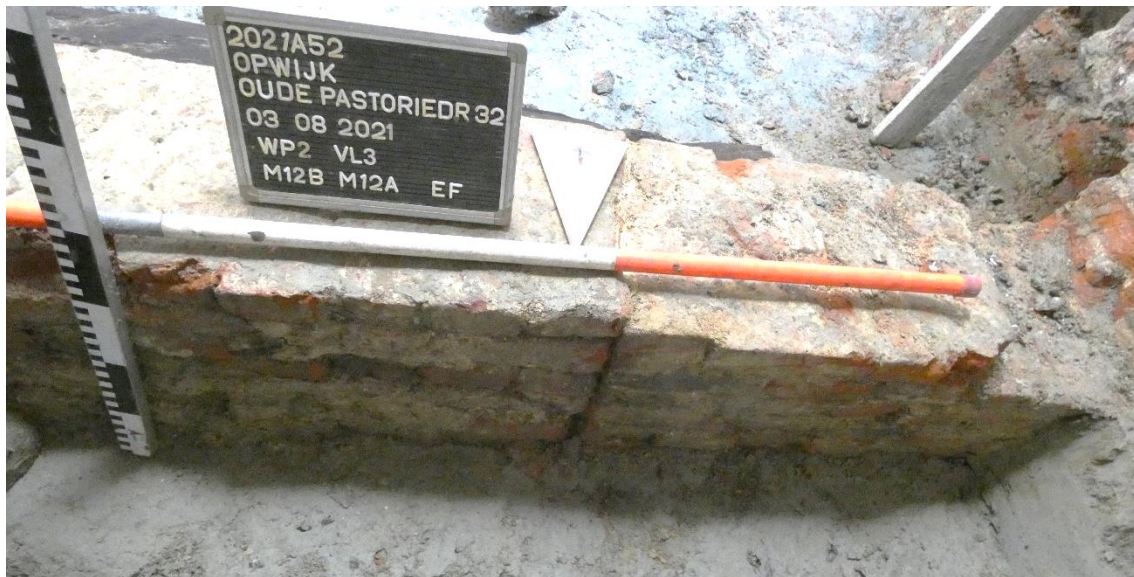
Figuur 117: Dichtgemetst deel (rechts: M12A) in de muur in het noorden van de kelder (M12B)
