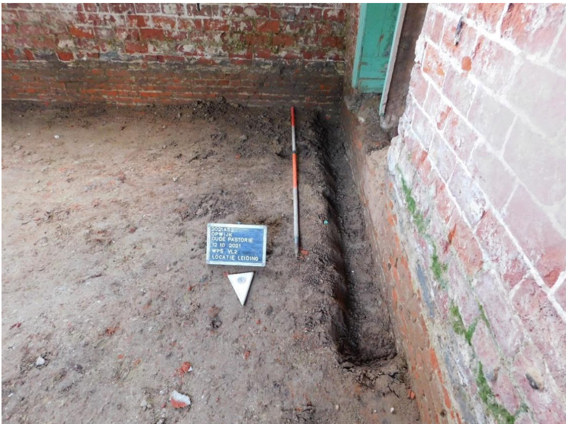
Figuur 133: Uitgraving voor leidingen in werkput 5
