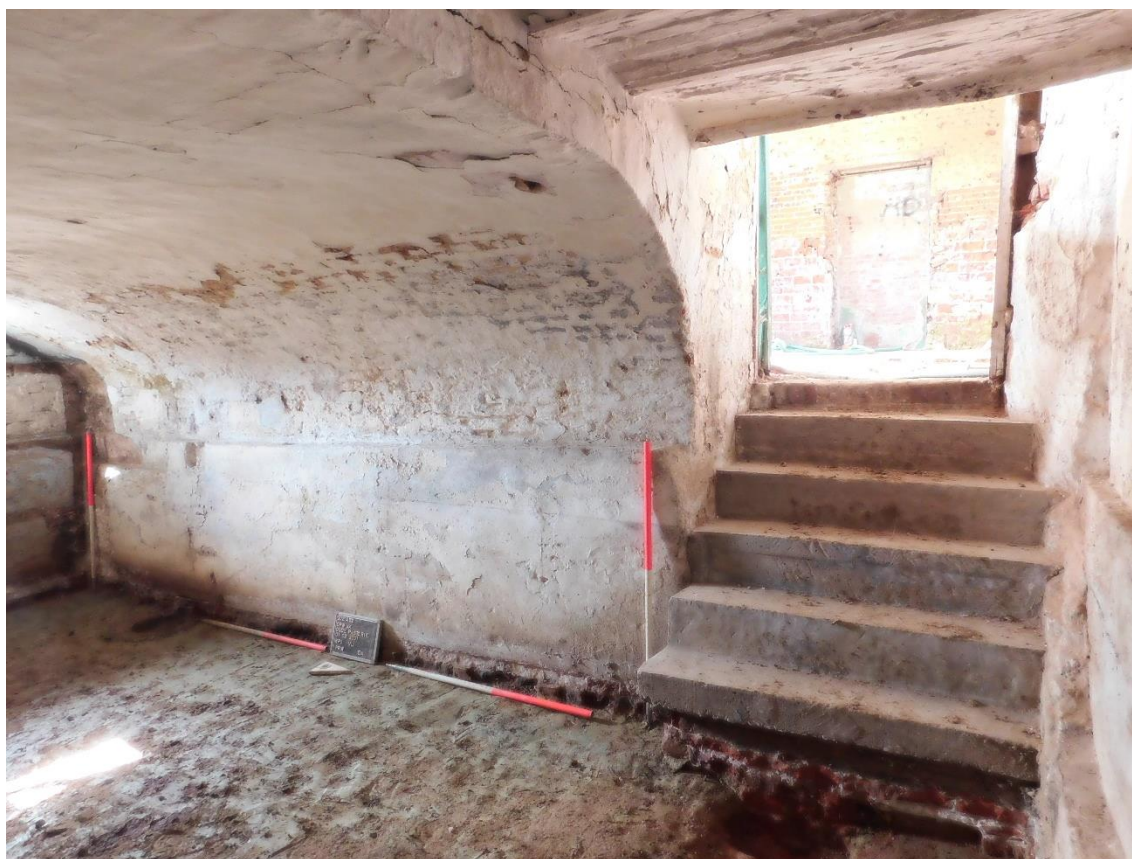
Figuur 108: Overgang tussen het oorspronkelijk tongewelf (links) en de troggewelven (rechts) in de kelder (werkput 2)
