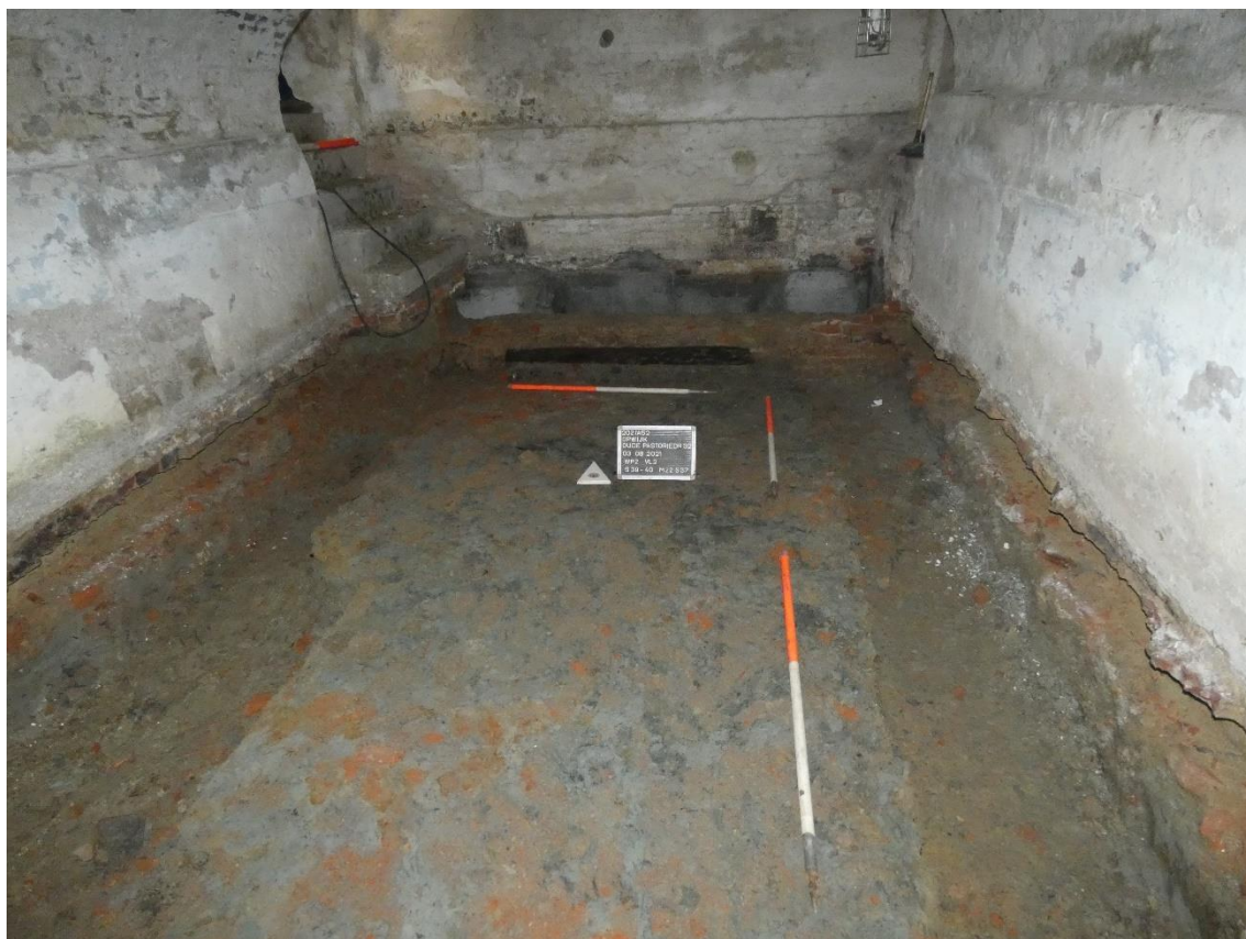
Figuur 110: Werkput 2, vlak 2 aan bovenzijde S39
