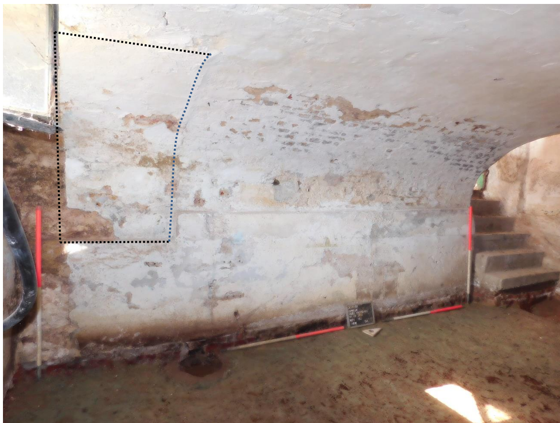
Figuur 115: Dichtgemetselde kelderopening in westelijke wand kelder
