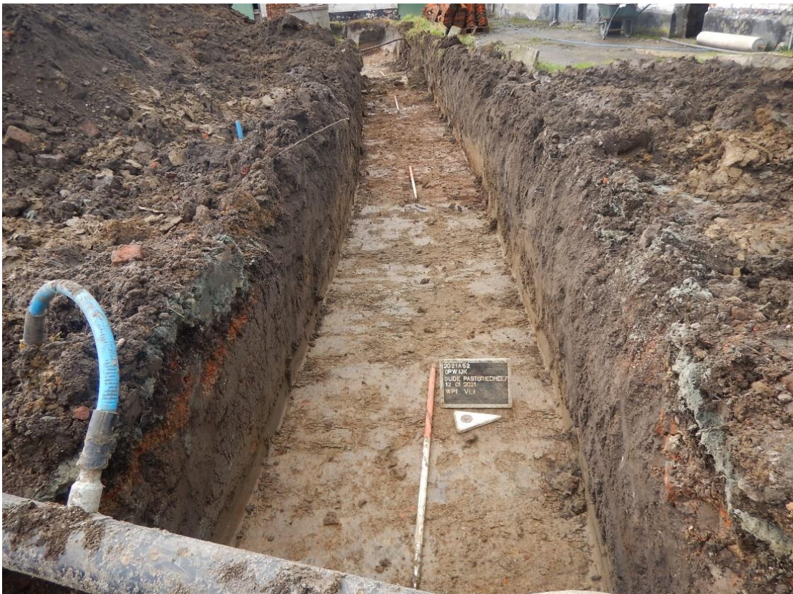
Figuur 46: Overzicht WP1 ter hoogte van de sleuf waar de leidingen geplaatst worden
