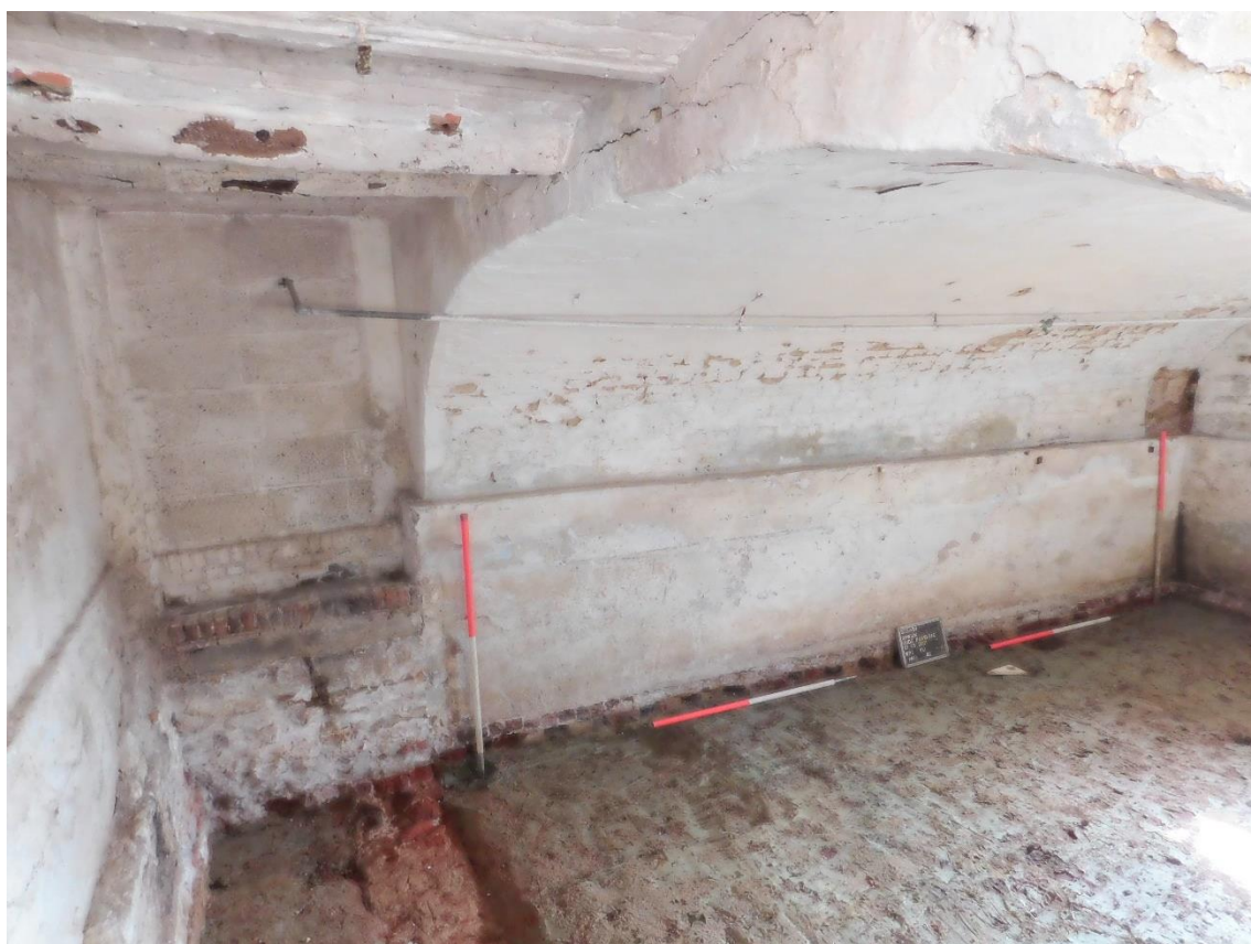
Figuur 116: Dichtgemetselde kelderopening (M21) ter hoogte van trap in het noordoosten
