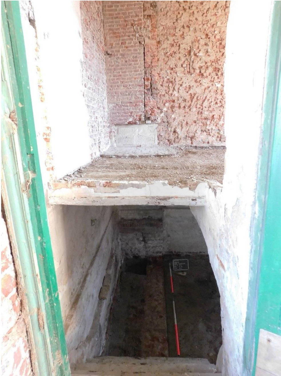
Figuur 109: Foto van de toegang tot de kelder en de bovenliggende bovenkamer met tussenliggende troggewelven. De bouwnaad ter hoogte van de bovenkamer komt overeen met de locatie van muur M12 in de kelder
