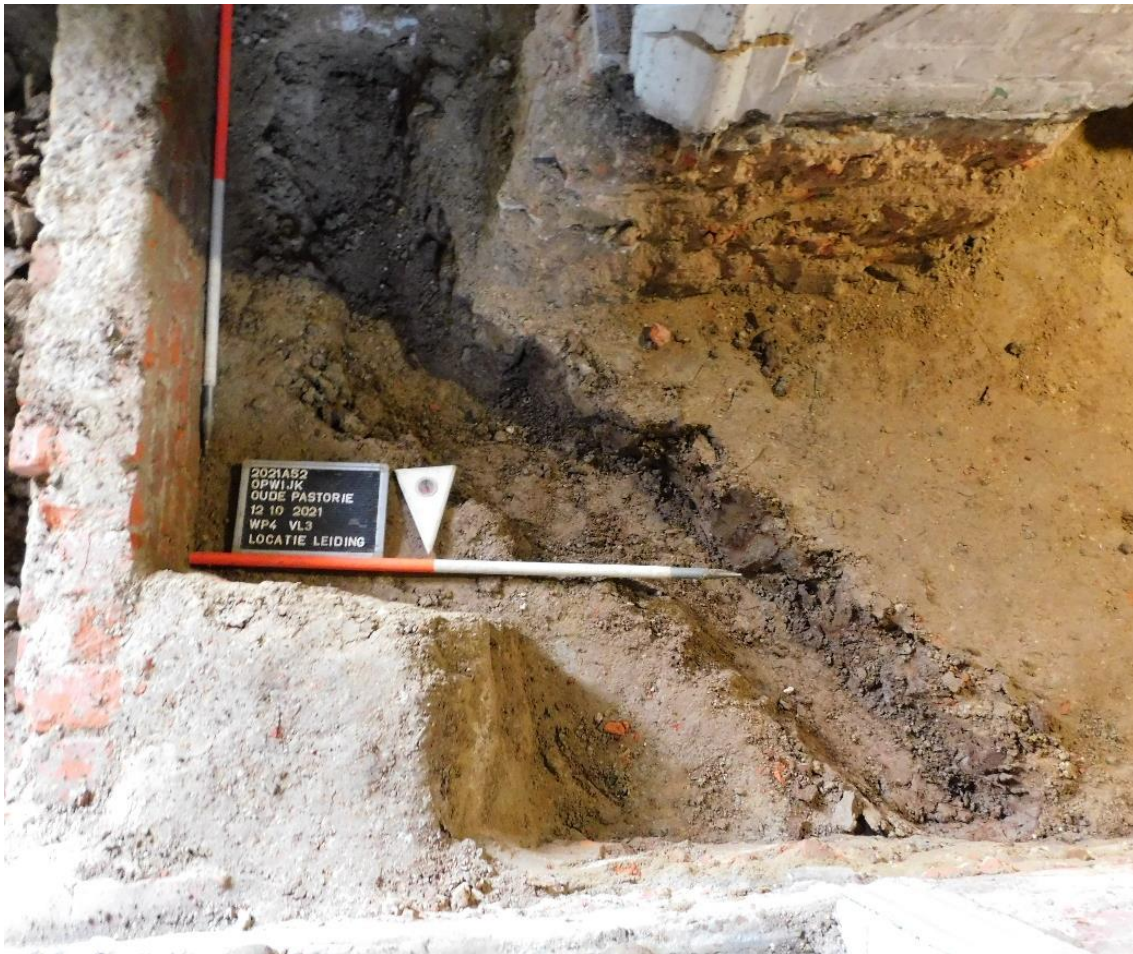
Figuur 131: Uitgraving voor leidingen in werkput 4
