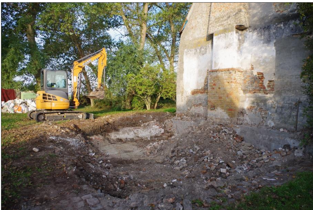
Figuur 9. Situatie bij aanvang van de werfbegeleiding
