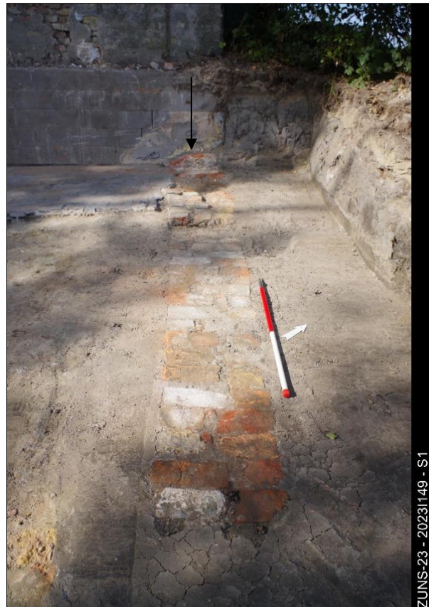
Figuur 16. Muur S1, met aanduiding van de jongere bouwfase
