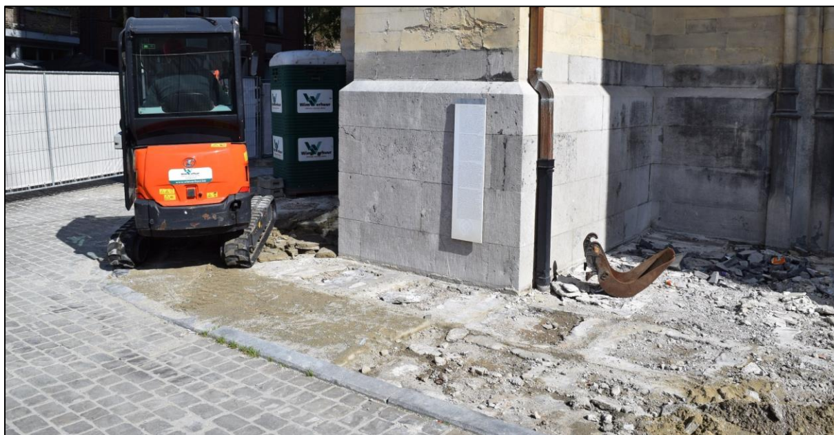
Afb. 24: Werkfoto na de opbraak van de natuursteen tussen het N – en het W-portaal.
