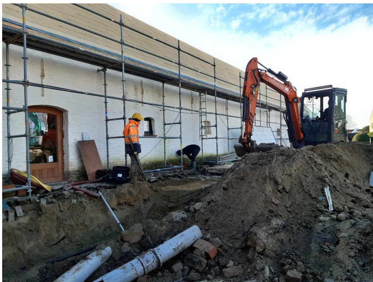
Figuur 2: Aanleg sleuf op de parking.
