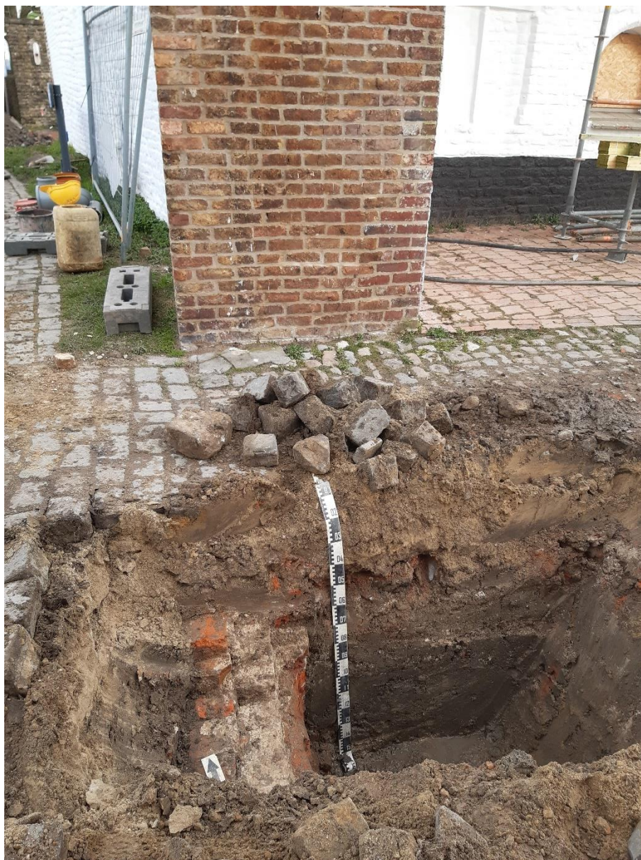
Figuur 17: Fundering van poortgebouw (WP11).
