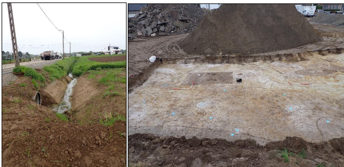
Figuur 11: L: zicht op reeds vergraven zone; R: zicht op grondstockage
