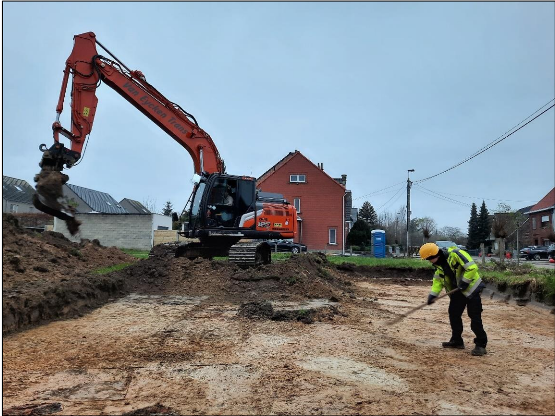
Figuur 2: Aanleg van het vlak in werkput 1
