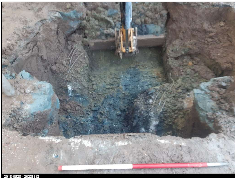
Figuur 8: Uitgraven van de liftput, met aanwezigheid van twee oudere funderingspalen.
