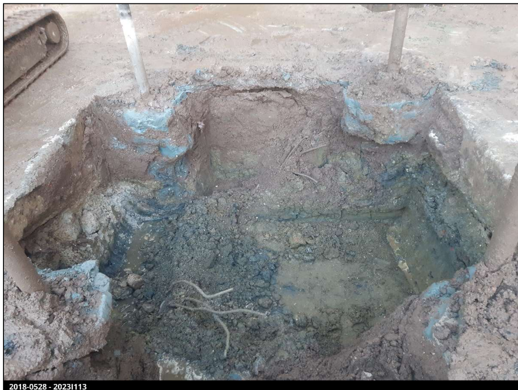
Figuur 12: Overzicht uitgraven liftput tot op verstoringsdiepte.
