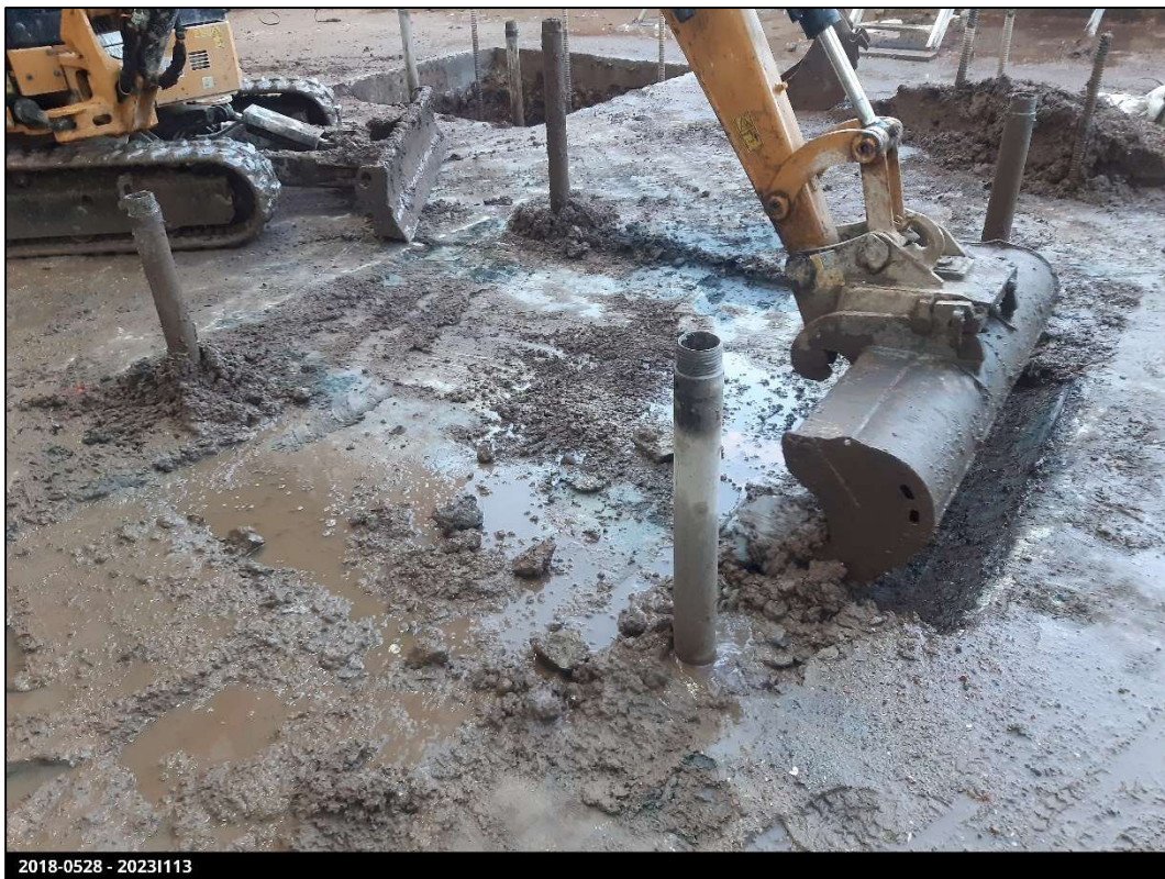
Figuur 11: Overzicht uitgegraven liftput.
