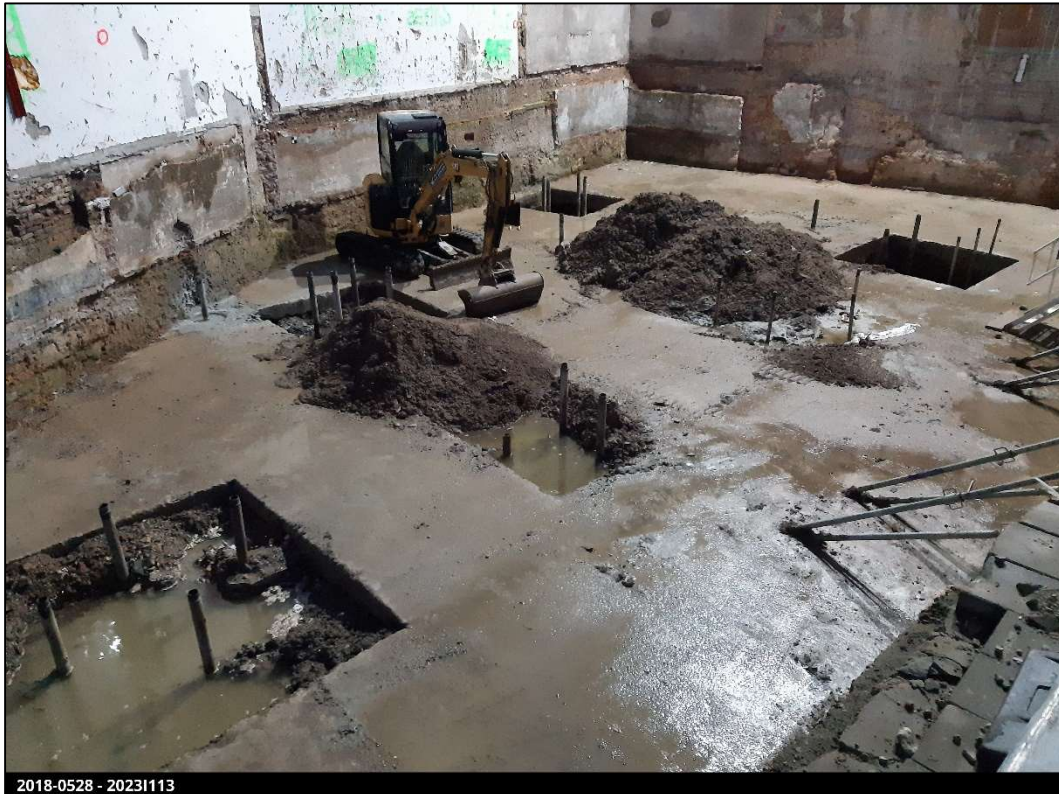
Figuur 9: Overzicht van de keldervloer met de uitgegraven putten voor de paalkoppen.
