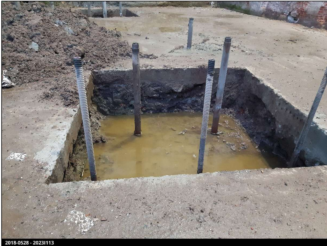
Figuur 10: Overzicht van een uitgegraven put voor de paalkoppen.
