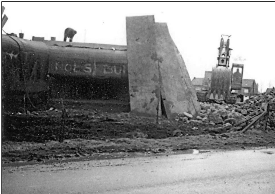
Figuur 11: Sloop van de bunker in de jaren '80 22
