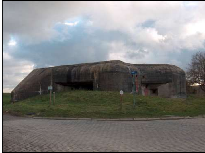
Figuur 12: Intacte bunker regelbau 630 in Stene, onderdeel uitmakend van Stützpunkt Stene 23
