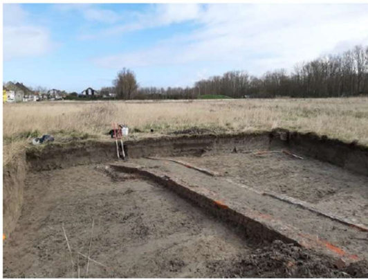
Figuur 177: Loopgraaf ter hoogte van put 1 bij de aanleg.
