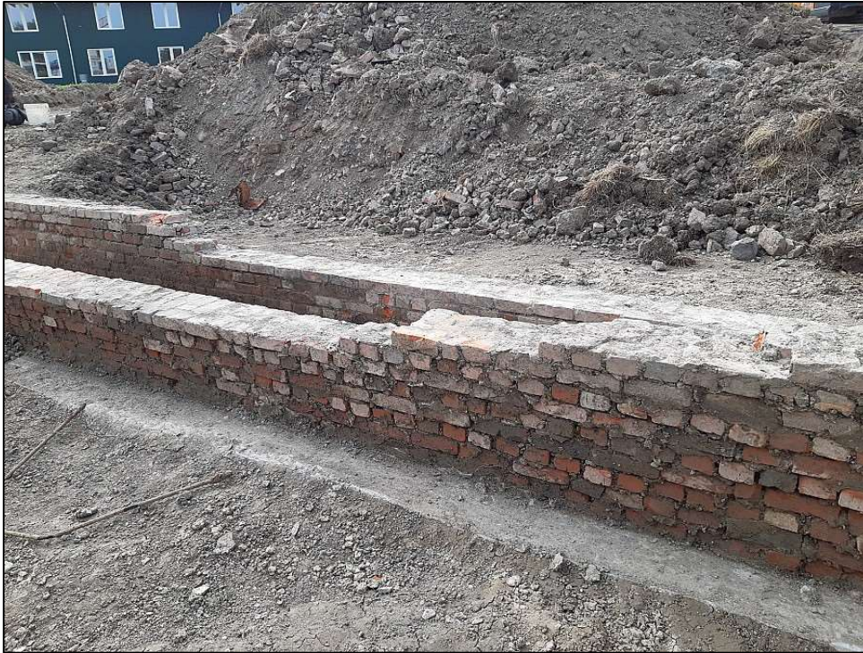
Figuur 18: Registratie van de buitenkant van de loopgraaf met betonnen plaat zichtbaar
