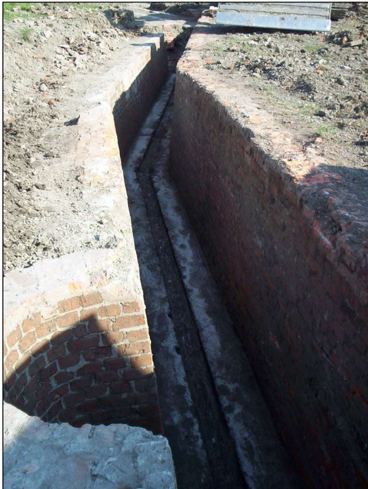
Figuur 36: Segment van de loopgraaf met nis en afwateringsgoot zoals aangetroffen bij de opgraving in 2006 40
