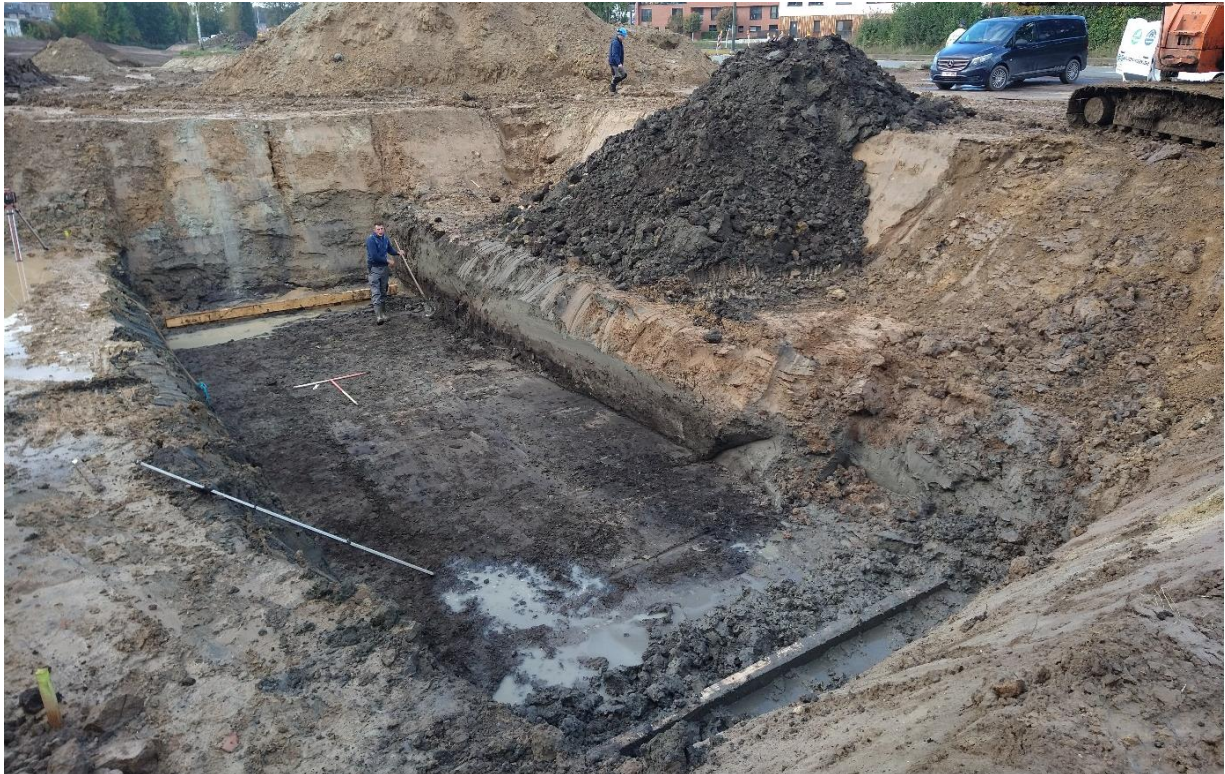
Figuur 13: Vlak 3 in het noorden van het plangebied (werkput 5), in de zone waar een betonnen duiker geplaatst wordt., zicht richting zuiden (© RAAP België).
