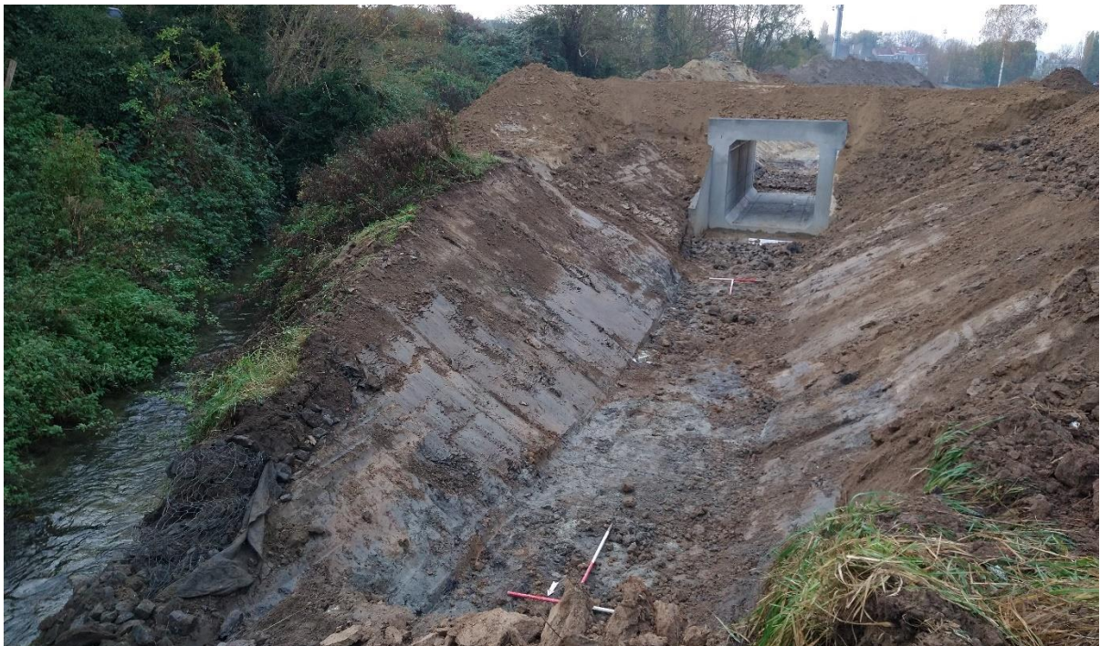
Figuur 14: Overzicht vlak 3 bij het uitgraven van de doorsteek naar de huidige loop van de Woluwe (links op foto) in het uiterste noorden van het plangebied (werkput 5), na plaatsen van de betonnen duiker, zicht richting zuiden. (© RAAP België).
