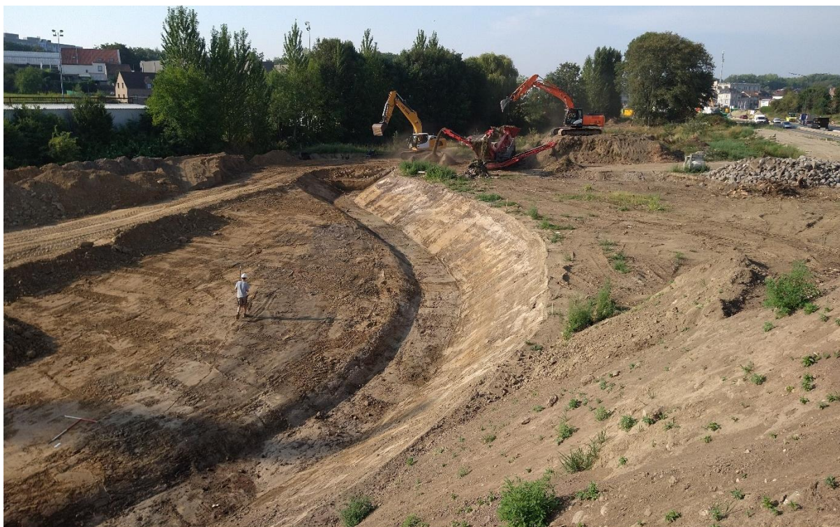
Figuur 9: Sfeerfoto werkput 1 met afgewerkte nieuwe loop (vlak 3), oostelijke winterbedding (vlak 2) en deel met afgegraven teelaarde (vlak 0) (© RAAP België).
