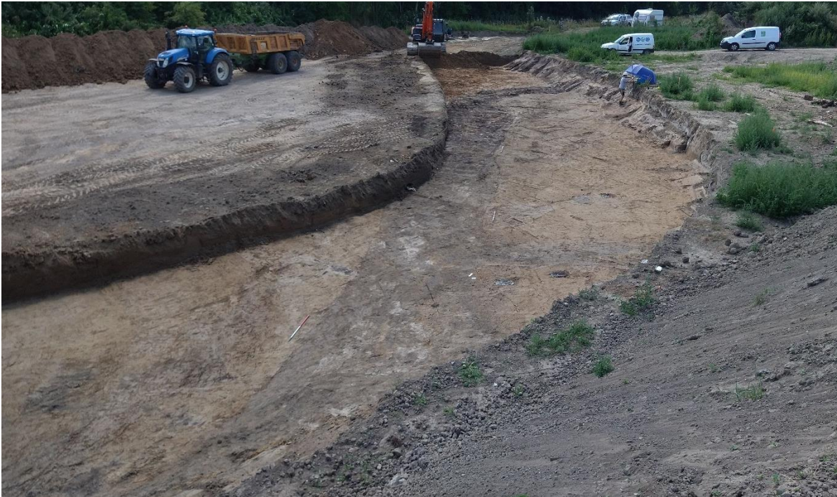
Figuur 37: Gracht S1 in vlak 1, zicht vanuit noorden.
