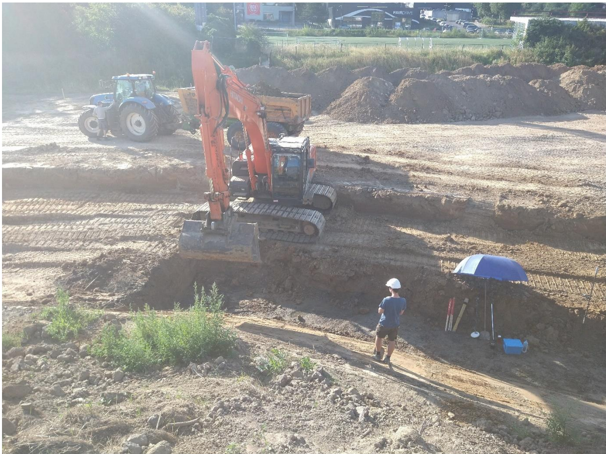
Figuur 8: Sfeerfoto aanleg van de beek zelf in \frac{3}{4} talud (vlak 3) ter hoogte van werkput 1. De kraan bevindt zich op vlak 1, de afgegraven grond wordt gestockeerd op vlak 0 (afgegraven teelaarde). Op de achtergrond de Woluwebeek ter hoogte van het gras-en struikgewas (© RAAP België).
