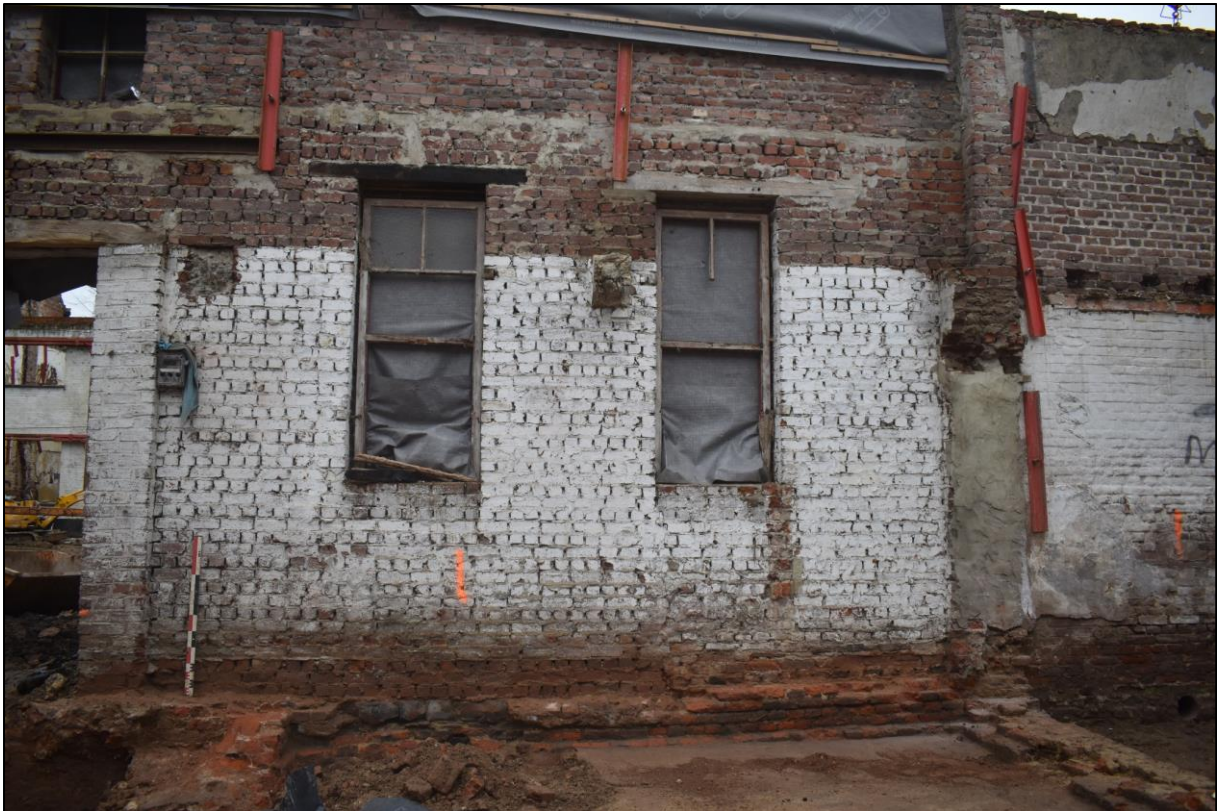
Afb. 31: Deel van de noordwestelijke binnenmuur met linksonder S5 en rechtsonder S4.
