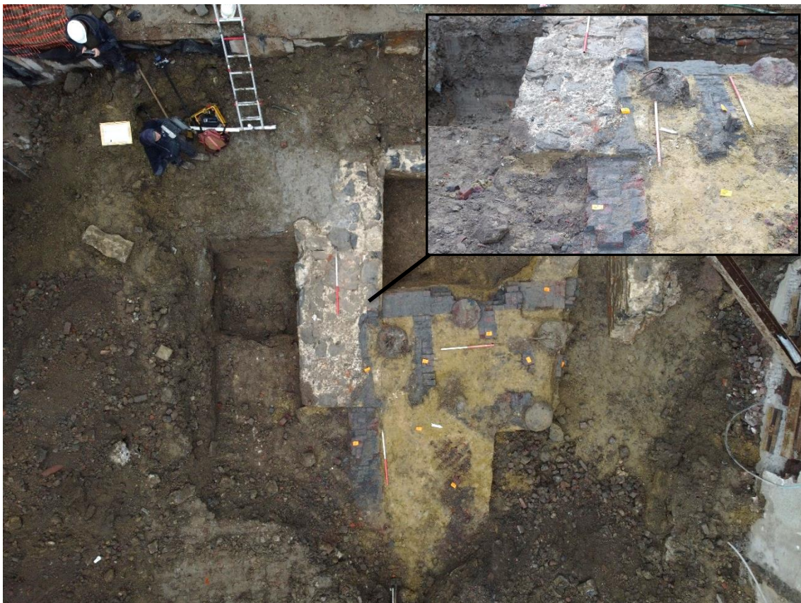
Figuur 31. Recent muurwerk dat tot tegen en ook deels op de natuurstenen steunbeer werd aangelegd.
