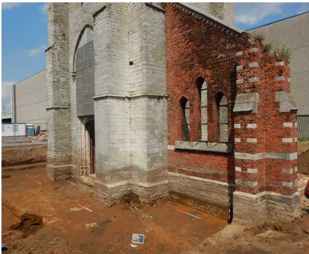
Figuur 76: Westzijde van de kerk op het onderste opgravingsniveau (vlak 2), waarop duidelijk te zien is dat de plint van de aangebouwde zijbeuk (M3) zich hoger bevindt dan de plint van de toren (M1)
