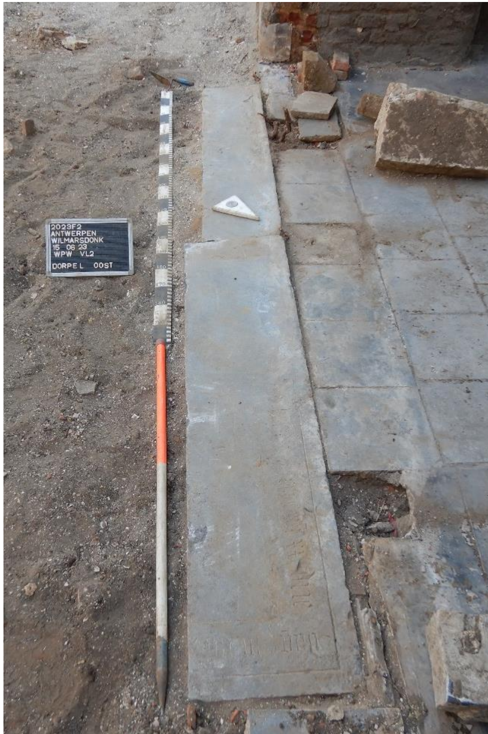
Figuur 79: Dorpel aan de oostzijde (vlak 2), bestaande uit gerecupereerde grafstenen
