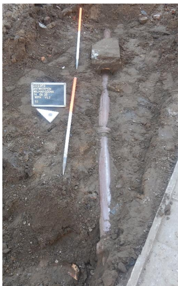
Figuur 67: Gresbuis (S2) ten noorden van de kerk (vlak 2) in werkput N
