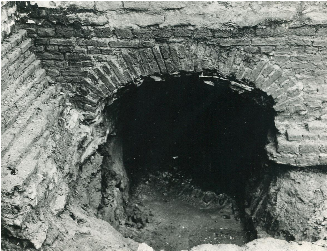
Figuur 8: Onderzoek van de funderingen van de toren door Havermans in 1966
