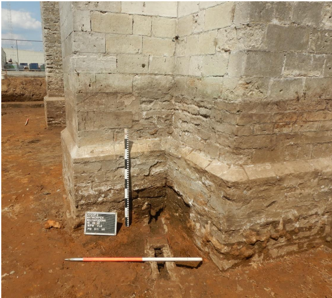
Figuur 61: Foto van de aansluiting van goot M9 (vlak 2) op de westgevel van de kerktoeren
