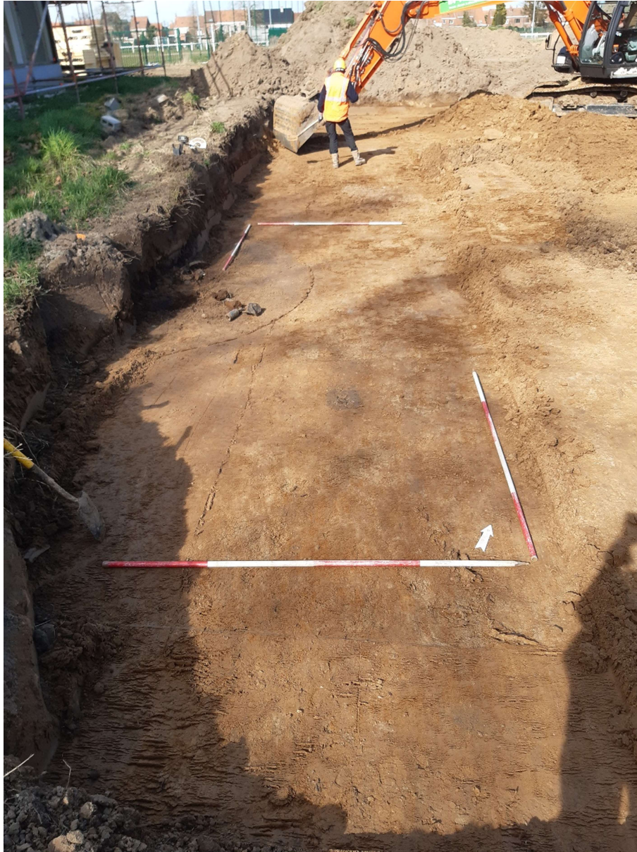
Figuur 4: Aanleg van vlak 2 met een 19 tons kraan.
