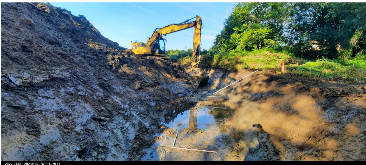
Figuur 11: Foto van uitgraving met aan linkerkant zicht op grondstockage.
